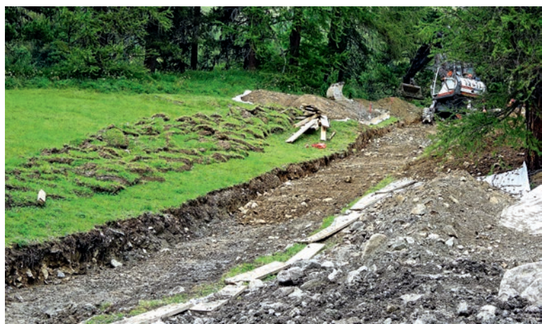
Figura 19: Deposito a breve termine delle zolle erbose direttamente sulla vegetazione esistente. I depositi di suolo sono versati su uno strato di separazione [foto: K. Edelkraut].
