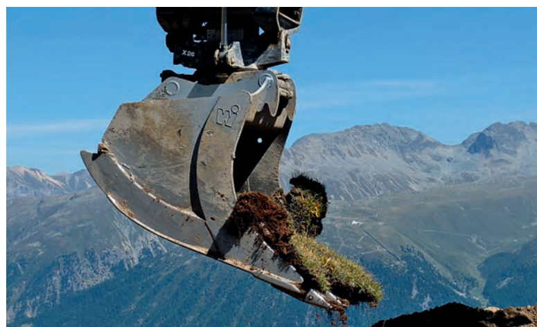
Figura 17: Le zolle vengono staccate con cura con la pala dell'escavatore [Foto: T. Schmid].
