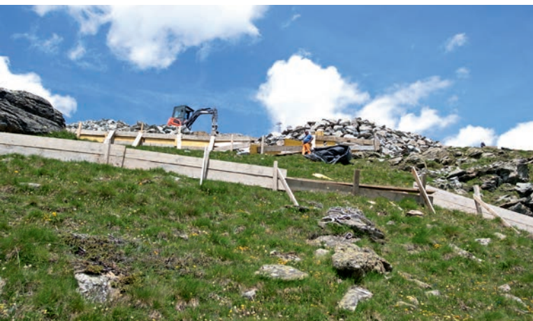
Figura 16: I pannelli di contenimento mettono in sicurezza il cantiere e impediscono lo scivolamento del materiale verso le superfici sottostanti [foto: M. Peters].
