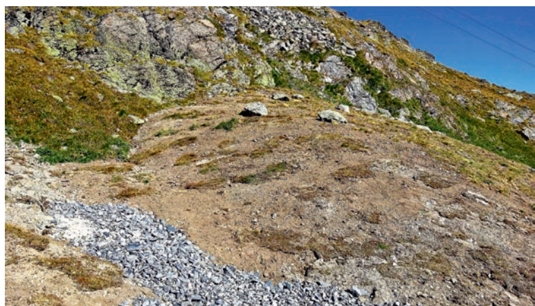
Figura 26: Se non ci sono abbastanza zolle per un rinverdimento di tutta l'area, esse vengono disposte a mosaico e gli spazi intermedi vengono seminati [Foto: K. Edelkraut].
