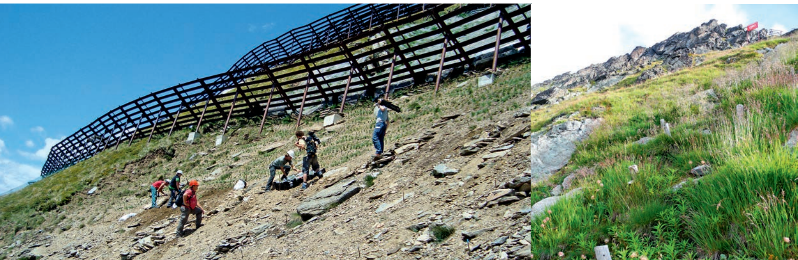
Figura 25: Se la copertura del suolo in pendii ripidi è necessaria, vale la pena l'impiantazione di piante coltivate ex sito.
