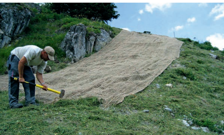
Figura 30: Fissaggio dei geotessili con chiodi di legno. Bisogna fare attenzione a garantire un contatto continuo con il terreno, soprattutto nel caso di tessuti e stuoie a maglie strette (Foto: M. Schwager).
