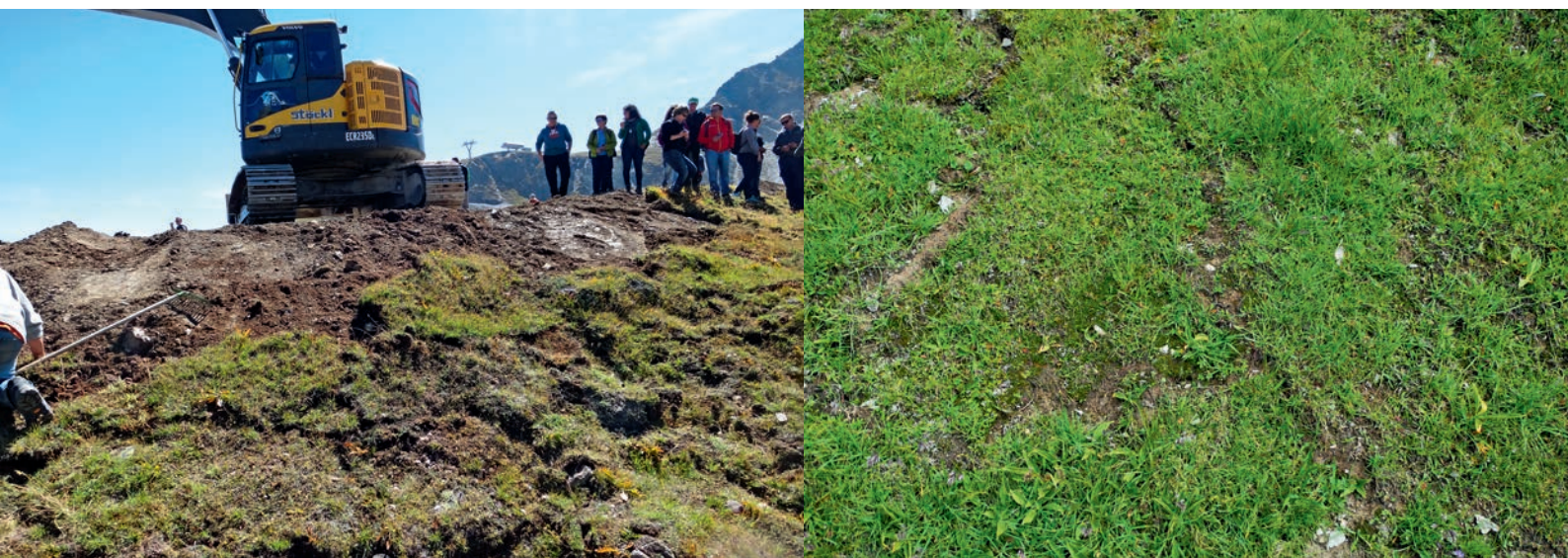
Figura 24: per fissare e sistemare le zolle sono necessari un escavatore e lavoro manuale [foto: B. Krüsi]. In seguito, l'intervento risulterà poco o per nulla visibile [foto: K. Edelkraut].
