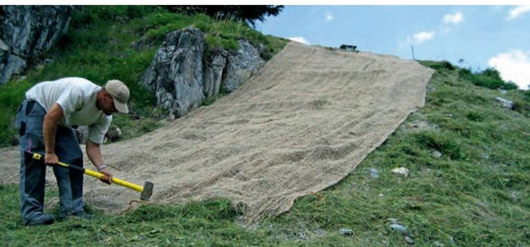
Figure 30 : Fixation des géotextiles avec des clous en bois. Il faut veiller à assurer un contact continu avec le sol, en particulier avec les toiles et les nattes à mailles serrées (photo : M. Schwager).
