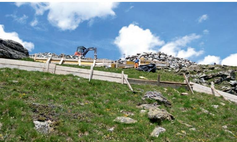
Figure 16 : Des panneaux de coffrage sécurisent le chantier et empêchent le glissement des matériaux vers les surfaces en aval (photo : M. Peters).
