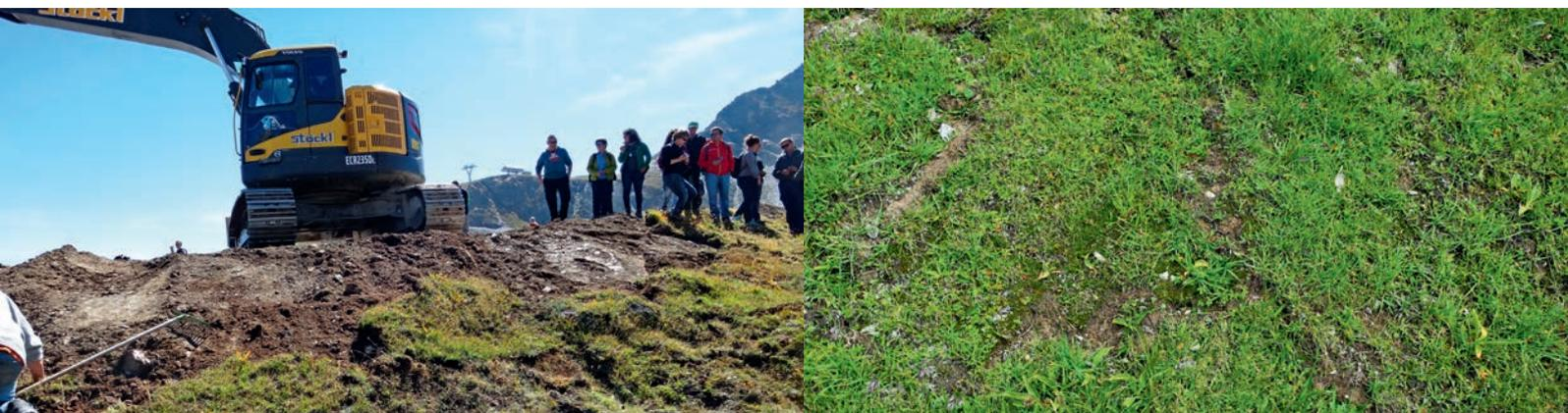
Figure 24 : La fixation et la pose des plaques de gazon nécessitent une pelleteuse et du travail manuel (photo : B. Krüsi). Par la suite, l'intervention n'est pratiquement plus ou pas visible du tout (photo : K. Edelkraut).
