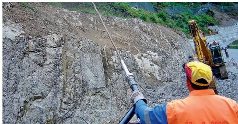
Figure 27 : Procédure de végétalisation avec semis hydraulique [photo : T. Schmid].
