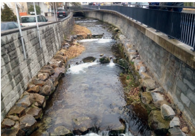
Abbildung 17: Seeforellenaufstieg im Küssnacher Dorfbach: Fischgängiger Abschnitt nach Abschluss der Bauarbeiten 2012. Aufnahme vom 13.3. 2018 / Foto: Hans Burch
