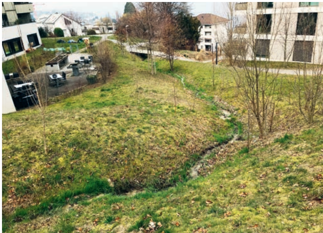
Abbildung 21: Rubschbach/Horgen: Die revitalisierte Strecke als Teilausdolung im Strickler-Areal (Abschnitt 5). Beidseits des Bachs entstanden neue Siedlungen. Aufnahme vom 2.3.2023 / Foto: Hans Burch
