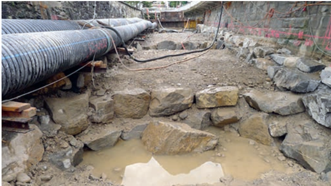
Abbildung 16: Seeforellenaufstieg im Küssnacher Dorfbach, Bauarbeiten 2011 mit aufwändiger Wasserhaltung. Foto: Gemeinde Küssnacht, Abt. Tiefbau
