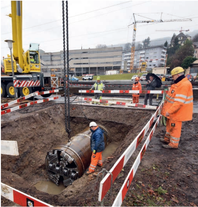
Abbildung 19: Rubschbach/Horgen: Nach erfolgreicher Querung der Seestrasse, der Bahnlinie und der Seegartenstrasse erreicht die neue Bachleitung via Mikrotunneling das Parkbad Seerose (Abschnitt 2). Dort wird der Bohrkopf ausgebaut. Aufnahme vom 9.12.2015 / Foto: Geoinfra AG
