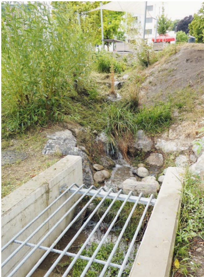
Abbildung 13: Revitalisierter Abschnitt des Gulmenbachs/Wädenswil. Im Einlaufbauwerk sind ein Amphibienaufstieg sowie einige Exemplare der Gattung «Veronica beccabunga L.» zu sehen. Aufnahme vom 2.7.2023 / Foto: Hans Burch
