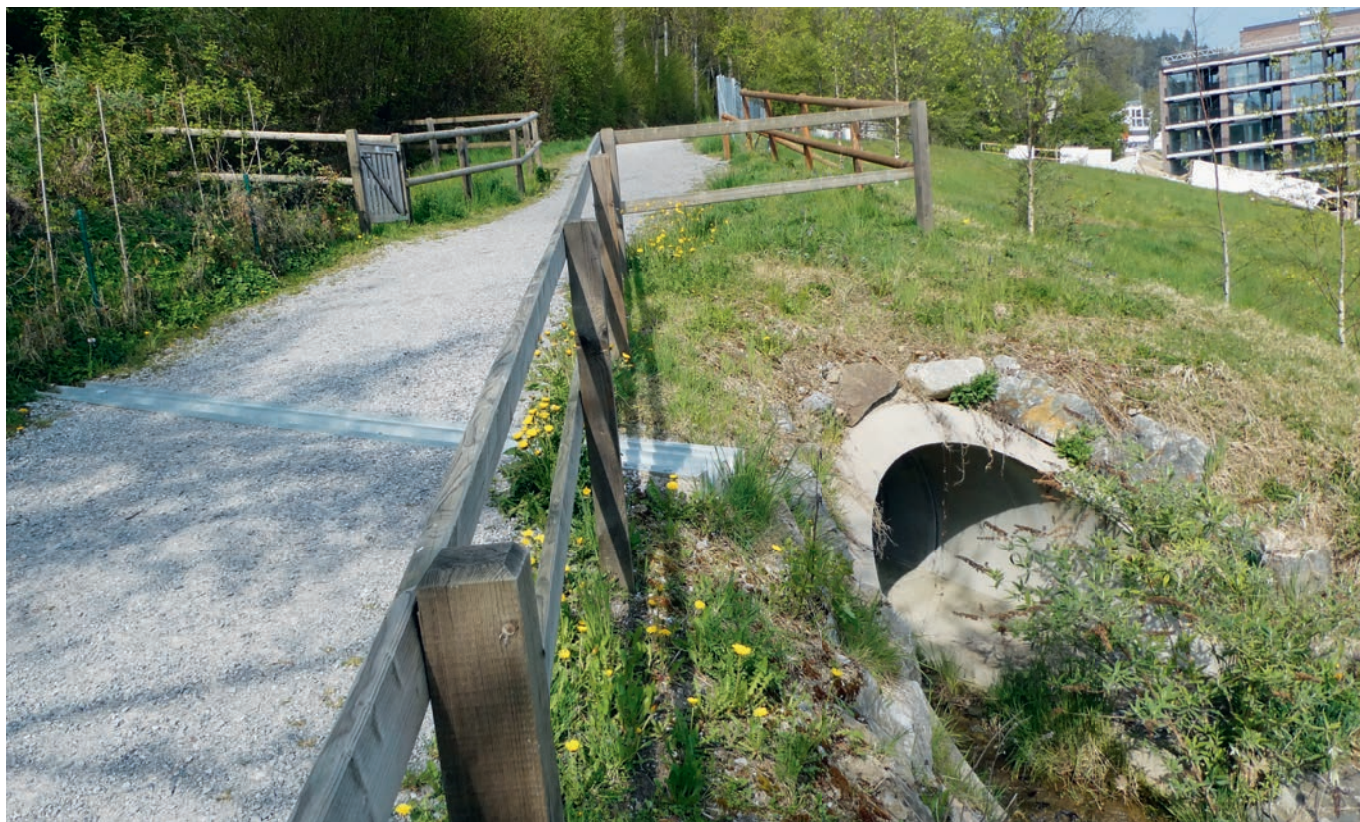
Abbildung 24: Rubschbach/Horgen: Der neue grosszügige Durchlass unter dem Schweiterweg ersetzt eine alte Betonröhre von nur 50 cm Durchmesser [Abschnitt 10]. Im Hintergrund ist die neue Gross-Überbauung der Realstone SA zu sehen. Aufnahme vom 22.4.2022 / Foto: Hans Burch
