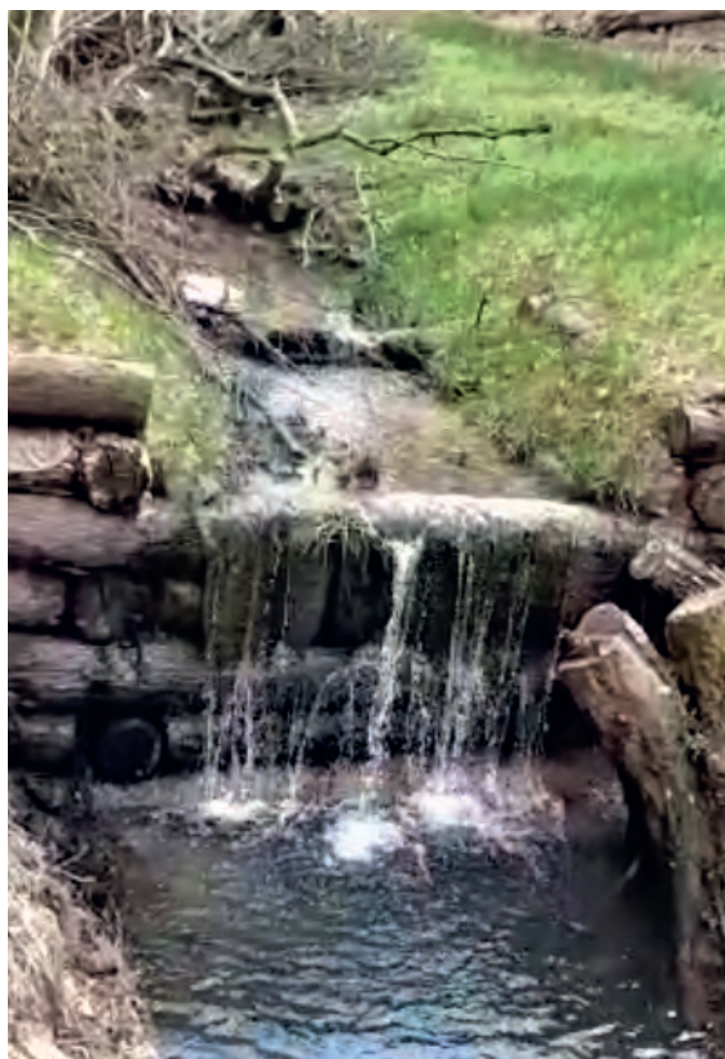
Abbildung 33: Fertige Holzkastensperre Sperre 3 Figure 33 : Barrage de caissons en bois terminé Barrage 3
