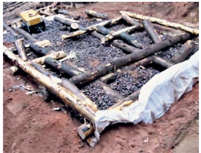
Abbildung 15: Schwerboden der Holzkastensperre Figure 15 : Fond robuste du barrage de caissons en bois
