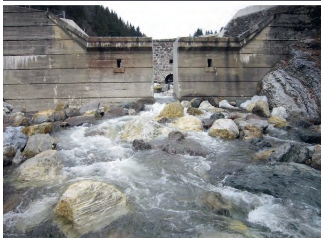
Abbildung 6: Umbau einer ehemals kronengeschlossenen kleindoligen Sperre in eine sohloffene Schlitzsperre [Schöttlbach, Bezirk Murau, 2019]
