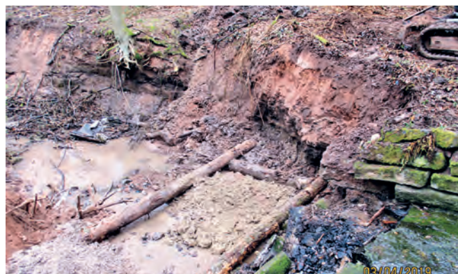
Abbildung 32: Befüllung der Sperre 1 mit Lehm Figure 32 : Remplissage du barrage 1 avec de l'argile
