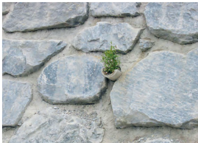
Abbildung 1: Detailansicht eines in einem Betonrohr verlegten Weidensteckholzes. Erfolgreicher Austrieb in der Vegetationsperiode nach Einbau.
