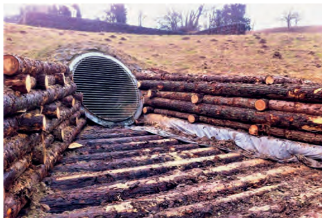
Abbildung 25: Fertiger Einlaufbereich Figure 25 : Zone d'entrée terminée
