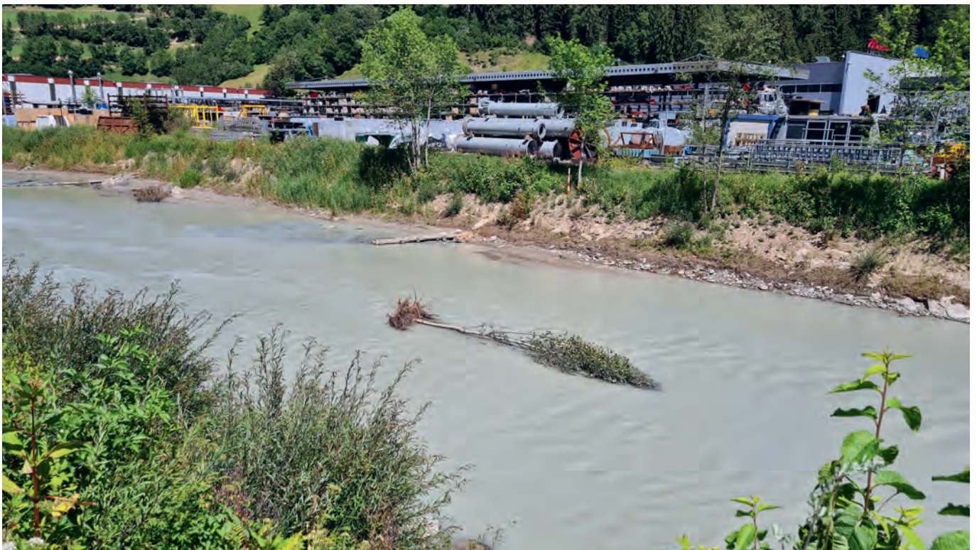
Abbildung 9: Das von den Sedimentablagerungen geräumte Bachbett des Mareiter Baches entlang der Gewerbezone Unterackern mit Holzbuhnen und Flussholzanzahlungen.
