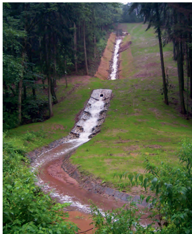
Abbildung 2: Steilstrecke als Raubbettgerinne aus Beton und Wasserbausteine [Zweibrücken] Figure 2 : Trançon escarpé comme lit rugueux en béton et enrochement [Zweibrücken]
