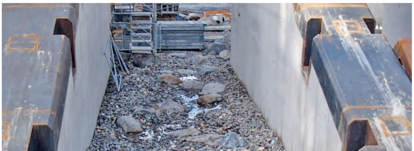
Abbildung 5: Ausgestaltete, strukturierte Sohle im Sperrenbereich während der Bauphase [Schöttlbach, Bezirk Murau, 2018/19]
