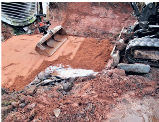
Abbildung 23: Herstellung des Planums für den Schwerboden Figure 23 : Réalisation de la surface plane pour le sol lourd
