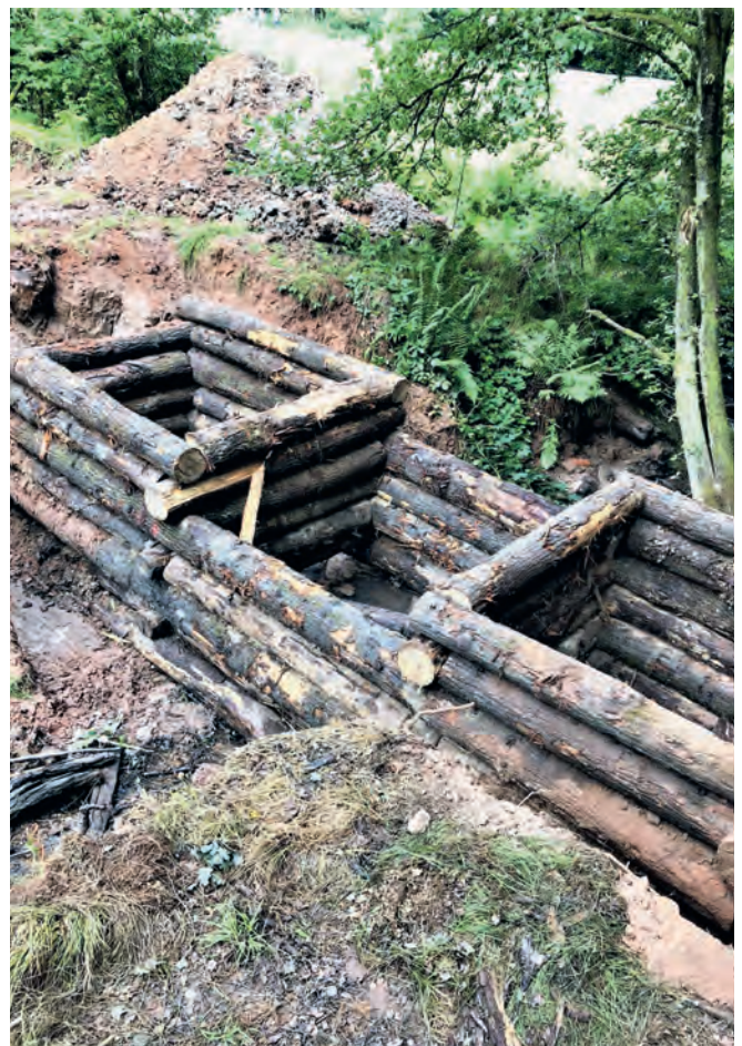
Abbildung 30: Anlegen der Sperre 4 als doppelte Holzkastensperre Figure 30 : Mise en place du barrage 4 sous forme de barrage double en caissons de bois
