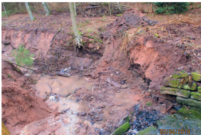
Abbildung 27: Einleitstelle E3 Tiefenerosion an der Einleitstelle E3 Figure 27 : Point de déversement E3 Erosion en profondeur au point de déversement E3
