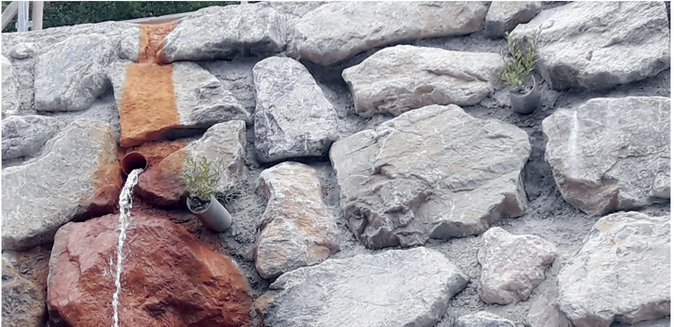
Abbildung 6: Die Weiden treiben kurze Zeit nach dem Versetzen der Rohre bereits aus. Figure 6 : Les saules bourgeonnent déjà peu de temps après la pose des tuyaux.
