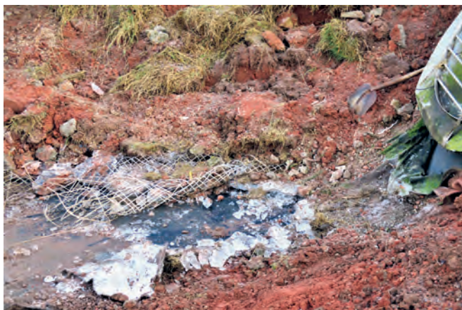
Abbildung 22: Rückbau des beschädigten Einlaufbereiches Figure 22 : Démolition de la zone d'entrée endommagée
