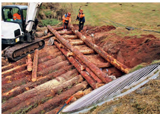
Abbildung 24: Aufbau der seitlichen Holzkasten auf dem Schwerboden Figure 24 : Montage des caissons latéraux en bois sur le sol lourd
