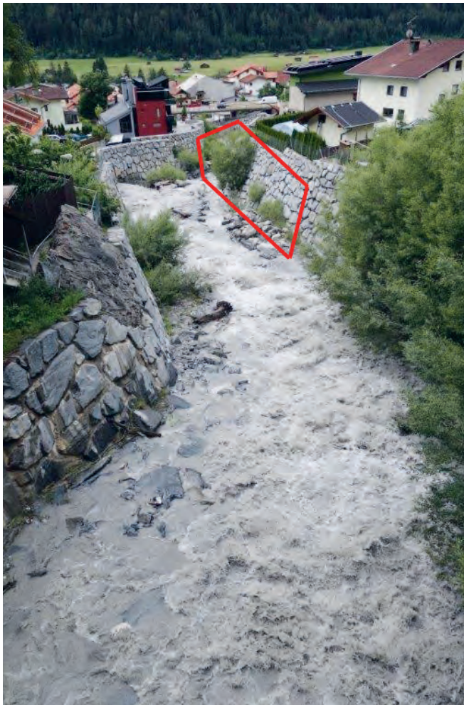
Abbildung 2: Verbauster Stubenbach im Orstgebiet von Pfunds. Die mit dieser Methode eingebauten Weiden sind rot markiert. Foto Sommer 2022.
