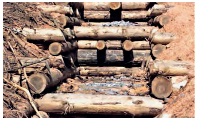
Abbildung 16: Detail der fertiggestellten Holzkastensperre Bild 9 Figure 16 : Détail du barrage de caissons en bois terminée Image 9
