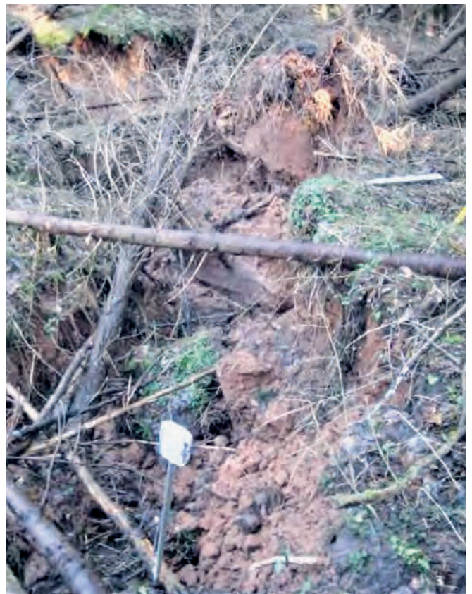
Abbildung 4: Erosionen im Steilhang Figure 4 : Erosions dans une pente raide
