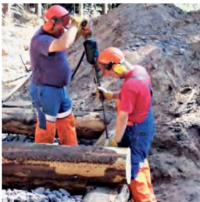
Abbildung 9: Vernageln der Kreuzungsstellen Figure 9 : Clouage des intersections
