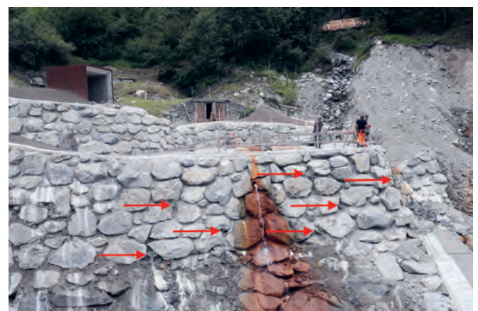
Abbildung 5: Die verlegten Weidensteckhölzer mit roten Pfeilen markiert.
