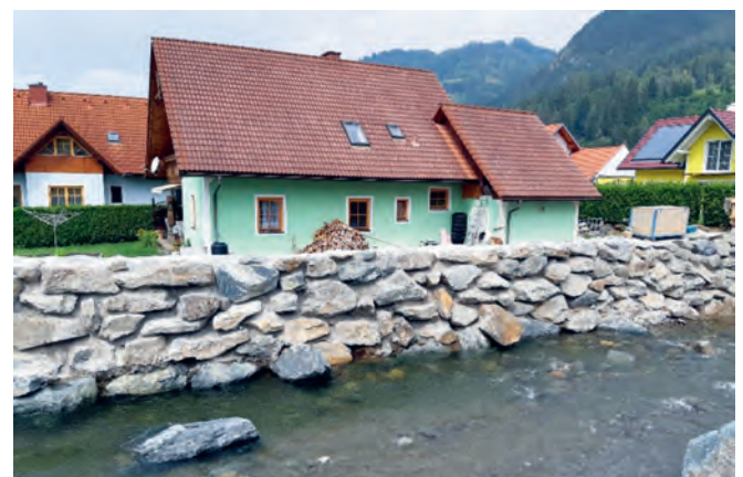
Abbildung 3: Zyklopenmauer mit Strukturierungsmassnahmen in der Wasserwechselzone Figure 3 : Mur cyclopéen avec mesures de structuration dans la zone soumise aux variations de débit
