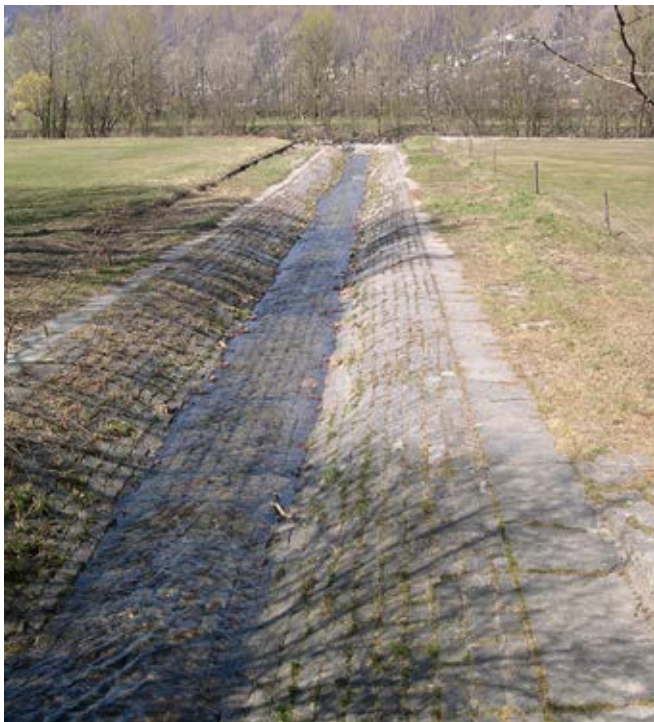
Fig. 15: Situazione ante operam 2017. Fig. 15 : Situation en 2017 avant le début des travaux. Abb. 15: Situation 2017 vor Beginn der Bauarbeiten.
