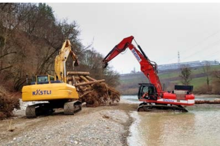
Abbildung 4: Links: Transport vorgefertigtes ELJ-Element zum Einbauort. Rechts: Einbau des ersten Elements (Fotos: Emch+Berger AG). Figure 4 : À gauche : Transport d'un élément ELJ préfabriqué au lieu d'installation. A droite : installation du premier élément (photos : Emch+Berger AG).
