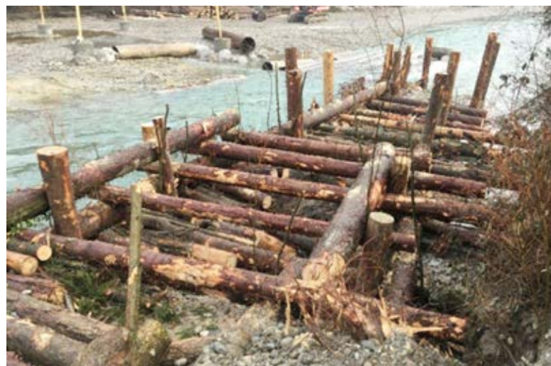
Abbildung 5: Links: Verankerung ELJ-Elemente mit Holzpfählen, Ausfachung mit Füllholz. Rechts: Beginnende Verfüllung mit Flusskies (Fotos: Emch+Berger AG). Figure 5 : À gauche : Ancrage des éléments ELJ avec des pieux en bois, remplissage avec du bois de remplissage. A droite : début du remplissage avec du gravier de rivière (photos : Emch+Berger AG).
