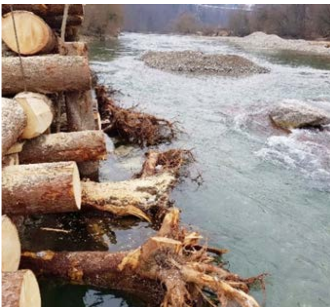
Abbildung 6: Die strömungsexponierte ELJ-Front wurde im Löchligut projektspezifisch ausgebildet: unten schaffen Wurzelteller gute Fischhabitate, oben bringt ein relativ glatter Stammverbund die nötige Sicherheit für Schwimmende/Kleinboote [Fotos: Emch+Berger AG].
