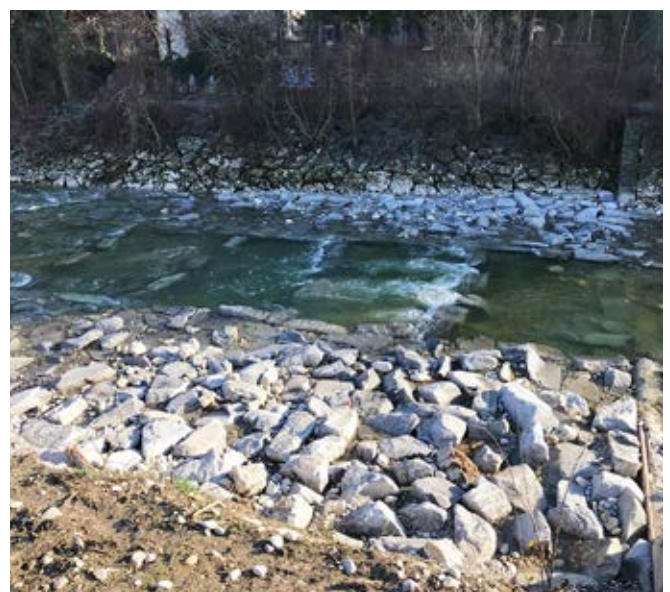
Abbildung 3: Fischgängige Rampe mit Niedrigwassergerinne in Riegel-Becken-Struktur [GEWISS-km 4.542]. Fliessrichtung von rechts nach links; Foto: IUB Engineering AG.
