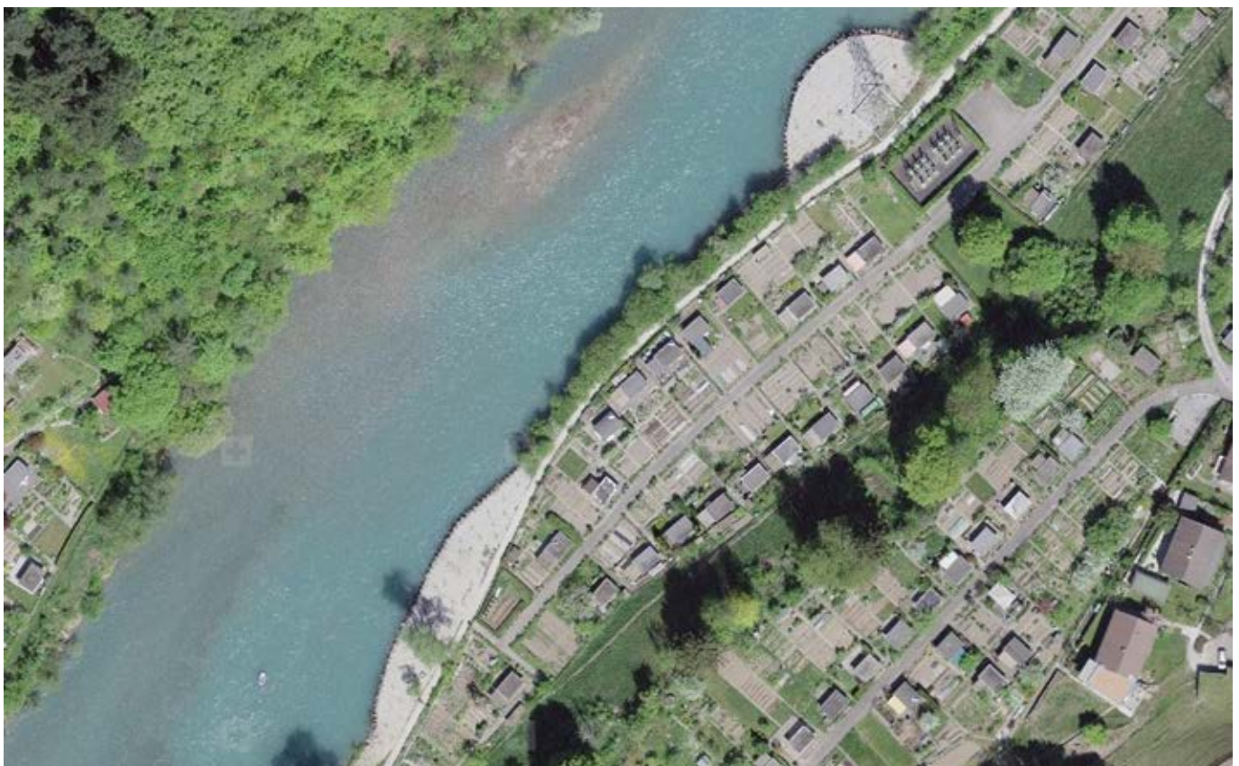
Abbildung 8: ELJ-Verbau im Löchligut aus der Vogelperspektive mit Uferlängsverbau und Kanzel (Foto: Luftaufnahme swisstopo, 2018). Figure 8 : L'aménagement ELJ dans le Löchligut vu du ciel avec l'ouvrage longitudinal des rives et la plateforme (photo : photographie aérienne swisstopo, 2018).
