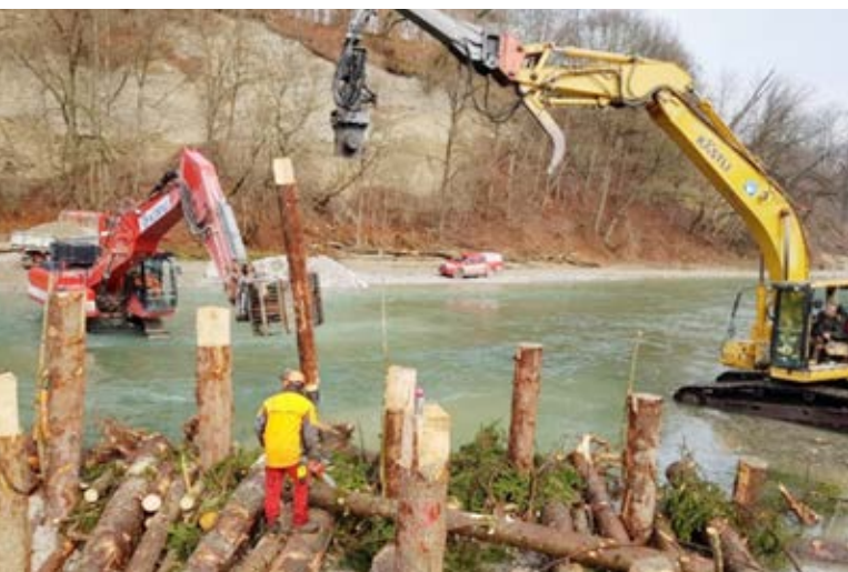
Abbildung 5: Links: Verankerung ELJ-Elemente mit Holzpfählen, Ausfachung mit Füllholz. Rechts: Beginnende Verfüllung mit Flusskies (Fotos: Emch+Berger AG). Figure 5 : À gauche : Ancrage des éléments ELJ avec des pieux en bois, remplissage avec du bois de remplissage. A droite : début du remplissage avec du gravier de rivière (photos : Emch+Berger AG).
