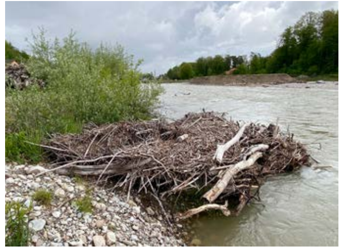
Abbildung 4: Gruppe lebender Abweiser [klein / mittel] zur Uferstrukturierung [links]. b) Ein grosser lebender Abweiser wirkt als Schwemmholzfänger und Fischunterstand [rechts]; Fotos: IUB Engineering AG.
