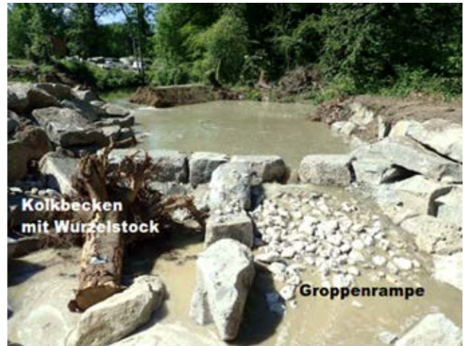
Abbildung 3: Links: Zustand vor Bau Beckenpass. Rechts: Bauzustand mit Aufbau Becken-Kompartimentierung (Fotos: Emch+Berger AG).
