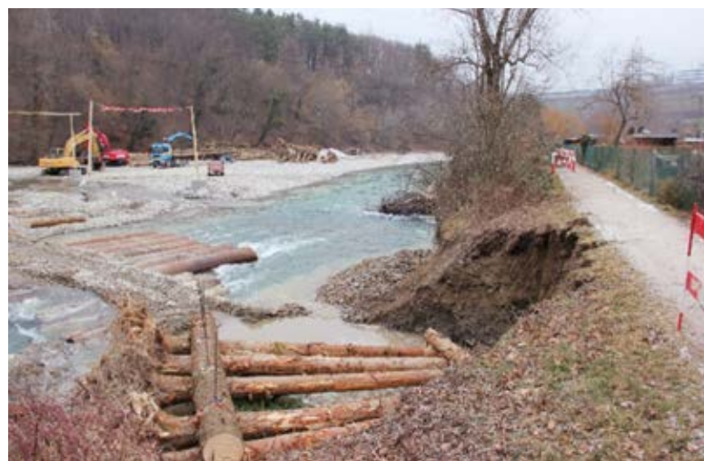
Abbildung 4: Links: Transport vorgefertigtes ELJ-Element zum Einbauort. Rechts: Einbau des ersten Elements (Fotos: Emch+Berger AG). Figure 4 : À gauche : Transport d'un élément ELJ préfabriqué au lieu d'installation. A droite : installation du premier élément (photos : Emch+Berger AG).
