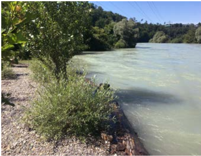
Abbildung 7: Der ELJ-Verbau bei Hochwasser im Juli 2021 mit Schwarzerlen und Weiden im Wachstum (Foto: Emch+Berger AG). Figure 7 : L'aménagement ELJ en période de crue en juillet 2021 avec des aulnes noirs et des saules en croissance (photo : Emch+Berger AG).
