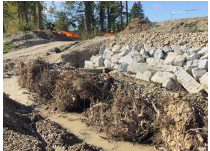
Abbildung 5: Blocksatz mit ingenieurbioologischer Begrünung [BMU, Ufertyp 2] kurz nach Fertigstellung [links]. b) Verstärkung des BMU-Fusses mit Wurzelstämmen [Bauzustand, rechts]; Fotos: IUB Engineering AG.
