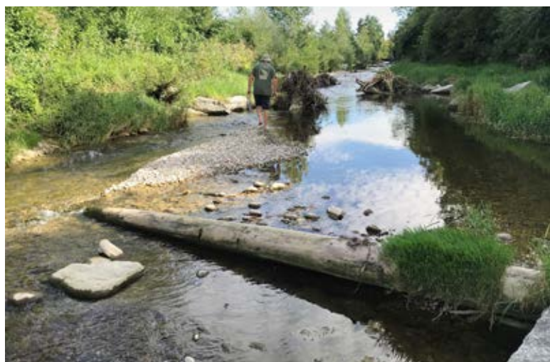
Abbildung 5: Gerinne mit Instream-Totholzstrukturen (Baumbuhnen, Wurzelstämme) zusätzlich zu bestehenden Steinstrukturen. Die Totholzstrukturen erhöhen die Strukturvielfalt der Sohle und steigern Fließgeschwindigkeits- und Tiefenvariabilität [Foto: Aquabios GmbH]. Figure 5 : Canal avec structures en bois mort Instream (épis d'arbres, troncs de racines) en plus des structures en pierre existantes. Les structures en bois mort augmentent la diversité structurelle du lit et accroissent la variabilité de la vitesse d'écoulement et de la profondeur [photo : Aquabios GmbH].
