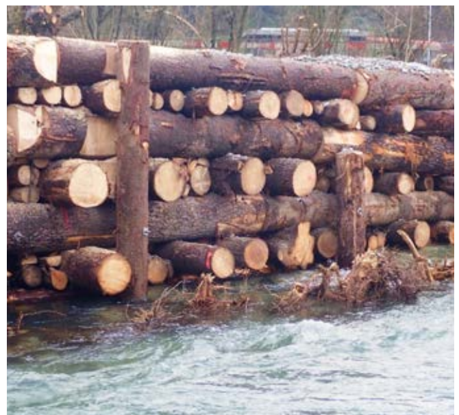
Abbildung 6: Die strömungsexponierte ELJ-Front wurde im Löchligut projektspezifisch ausgebildet: unten schaffen Wurzelteller gute Fischhabitate, oben bringt ein relativ glatter Stammverbund die nötige Sicherheit für Schwimmende/Kleinboote [Fotos: Emch+Berger AG].
