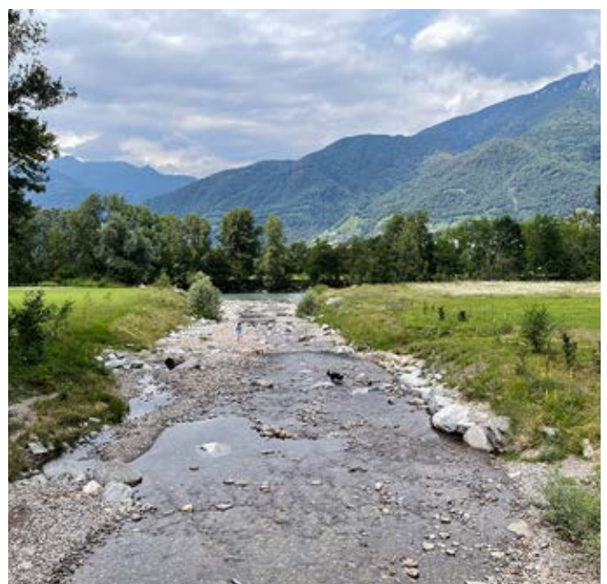
Fig. 18: Situazione 3 anni dopo la realizzazione [2021]. Fig. 18 : Situation 3 ans après l'achèvement des travaux [2021]. Abb. 18: Situation 3 Jahre nach Abschluss der Arbeiten [2021].
