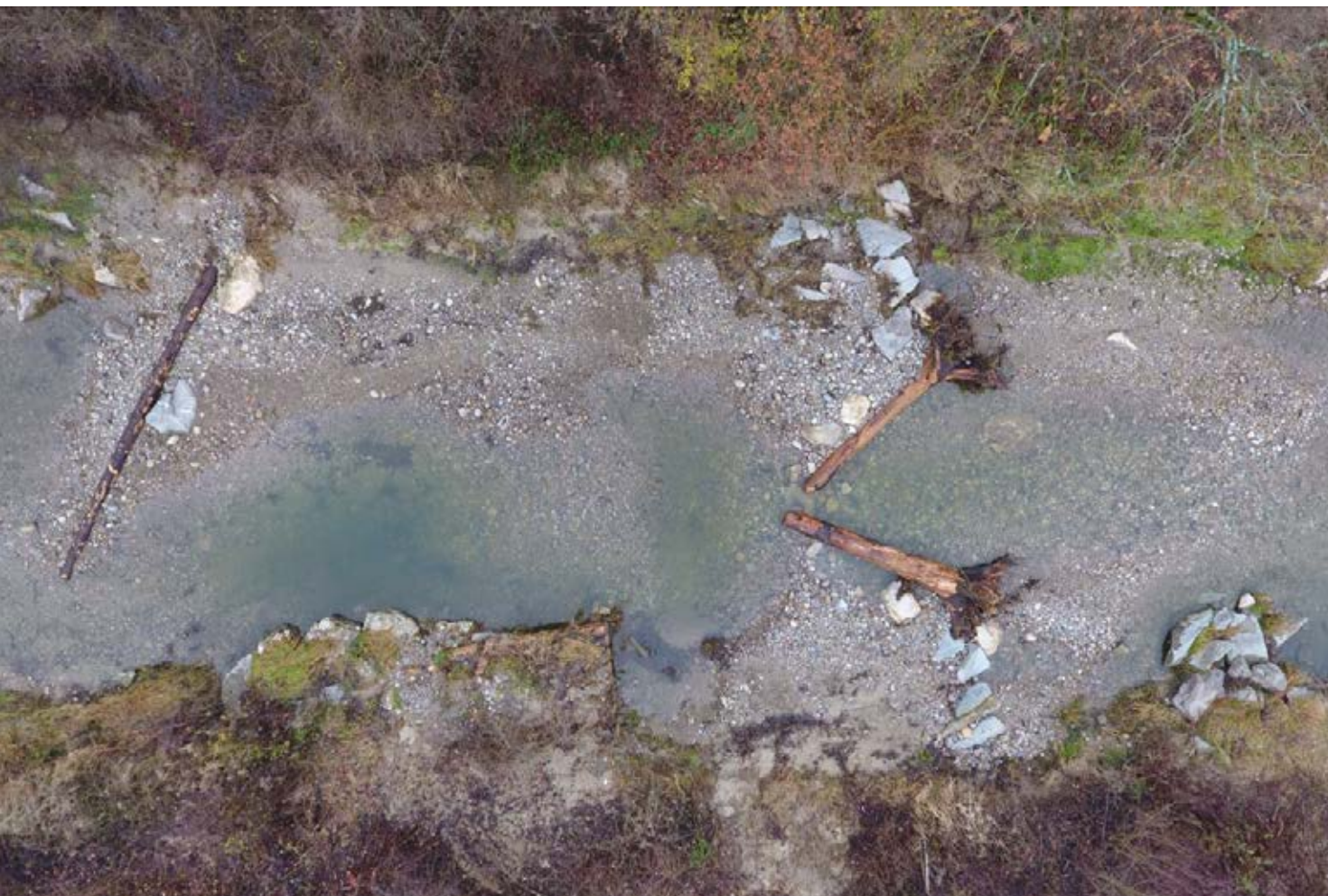
Abbildung 4: Luftaufnahme von Instream-Totholzstrukturen (Baumbuhnen, Wurzelstämme) zusätzlich zu bestehenden Steinstrukturen. Die Totholzstrukturen wurden mittels Stahlstäben an vergrabenen Blocksteinen verschraubt [Foto: Aquabios GmbH]. Figure 4 : Vue aérienne de structures en bois mort Instream (épis d'arbres, troncs de racines) en plus des structures en pierre existantes. Les structures en bois mort ont été vissées à des murs en blocs enterrés au moyen de tiges en acier [photo : Aquabios GmbH].
