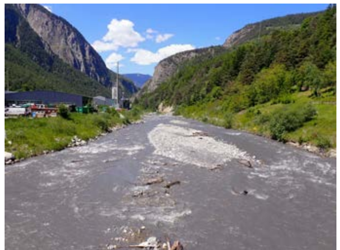
Photo 4: Secteur des Trappistes. Etat 2021, 4 ans après les travaux. Foto 4: Trappisten-Abschnitt. Zustand 2021, 4 Jahre nach den Arbeiten.
