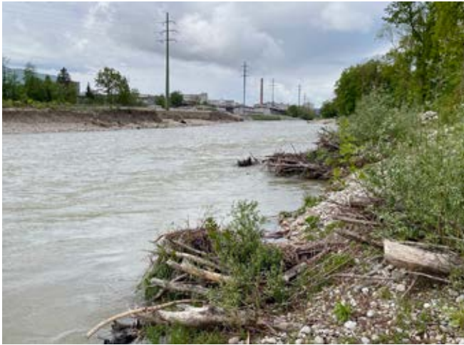
Abbildung 4: Gruppe lebender Abweiser [klein / mittel] zur Uferstrukturierung [links]. b) Ein grosser lebender Abweiser wirkt als Schwemmholzfänger und Fischunterstand [rechts]; Fotos: IUB Engineering AG.
