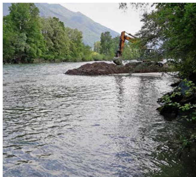
Fig. 12: Formazione di banchi di materiale alluvionale erodibile all'imbocco della foce. Fig. 12 : Formation de bancs alluviaux érodables à l'embouchure. Abb. 12: Bildung von erodierbaren Schwemmbänken an der Mündung.
