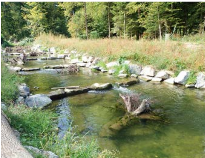
Abbildung 4: Fertiggestellter Raugerinne-Beckenpass in der Bibera (Foto: Emch+Berger AG).
