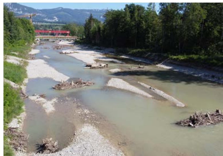
Abbildung 7: Entwicklung vielfältiger Strömungsmuster und Strukturen durch den Einbau von Totholzinseln, deren Wirkung sich durch zurückgehaltenes Schwemmholz verstärkt; Foto: IUB Engineering AG.
