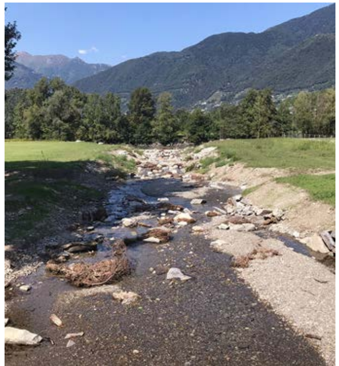
Fig. 16: Situazione 1 anno dopo la realizzazione [2018]: primi elementi di dinamica naturale [depositi, erosioni controllate e strutture acquatiche e terrestri]. Fig. 16 : Situation 1 an après la construction [2018] : premiers éléments de la dynamique naturelle [dépôts, érosion contrôlée et structures aquatiques et terrestres]. Abb. 16: Situation 1 Jahr nach dem Bau [2018]: erste Elemente der natürlichen Dynamik [Ablagerungen, kontrollierte Erosion und aquatische und terrestrische Strukturen].
