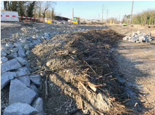
Abbildung 5: Blocksatz mit ingenieurbioologischer Begrünung [BMU, Ufertyp 2] kurz nach Fertigstellung [links]. b) Verstärkung des BMU-Fusses mit Wurzelstämmen [Bauzustand, rechts]; Fotos: IUB Engineering AG.
