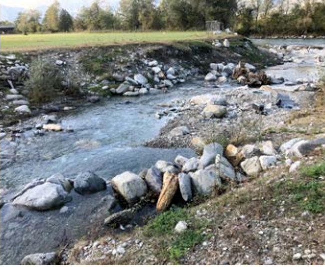
Fig. 13: Situazione 1 anno dopo la fine dei lavori. Fig. 13 : Situation 1 an après l'achèvement des travaux. Abb. 13: Situation 1 Jahr nach Abschluss der Arbeiten.
