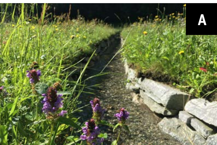
Abbildung 4: A: Ökologisch aufgewertete Variante des traditionellen Bergeller Wasserkanals mit treppenförmiger Uferbefestigung anstatt vertikal gestellter Steinplatten und durchlässiger Sohle; B: Gesamtbild des oberen Bachabschnitts (I) entlang der Reihe lokaltypischer Ställe. Figure 4 : A : Variante écologiquement revalorisée du lit traditionnel du Val Bregaglia, avec une stabilisation des berges en escalier au lieu de dalles de pierre posées verticalement et un lit perméable ; B : Vue générale du tronçon supérieur du ruisseau (I) le long de la rangée d'étables typiques locales.
