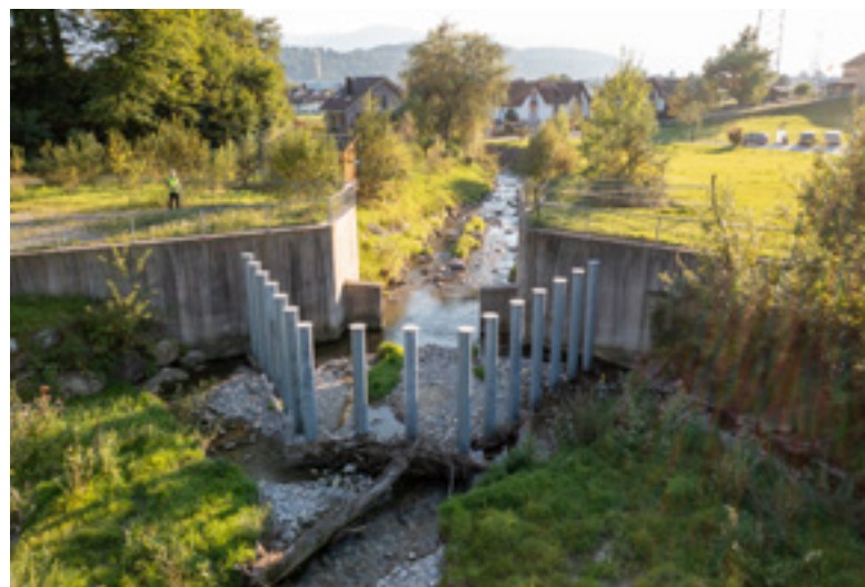
Abbildung 9: Geschiebeablagerungsplatz Ernetschwilerbach in Uznach: Verengungsbauwerk mit Pfahlrechen. | Figure 9 : Emplacement de dépôt des sédiments Ernetschwilerbach à Uznach : ouvrage de rétrécissement avec râteau à pieux.
