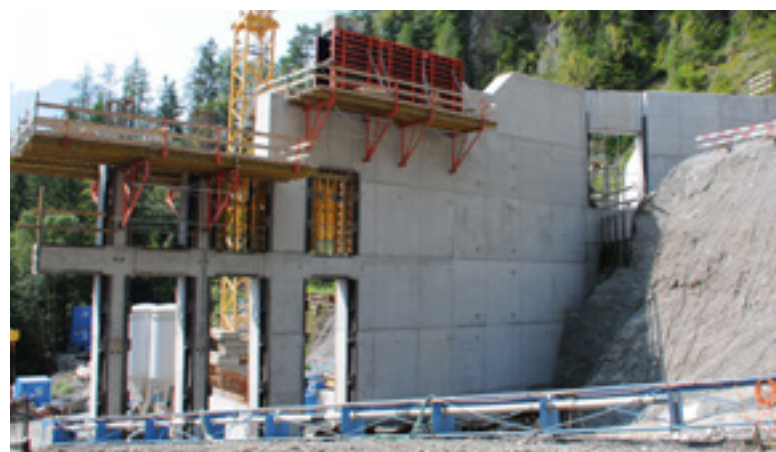
Abbildung 10: Abschlussbauwerk Roossi im Bau, Sommer 2021. Figure 10 : Ouvrage de fermeture Roossi en construction, été 2021.
