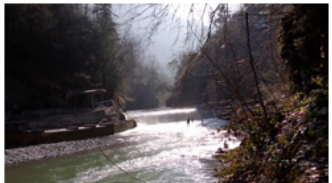
Abbildung 34: Schwall-Situation. Foto: Fredy Elber, AquaPlus AG. | Figure 34 : Effet d'éclosée [débit plancher]. Photo : Fredy Elber, AquaPlus AG.
