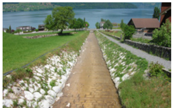
Abbildung 28: Gepflästerte Sohle. Foto: Fredy Elber, AquaPlus AG. | Figure 28 : Fond pavé. Photo : Fredy Elber, AquaPlus AG.
