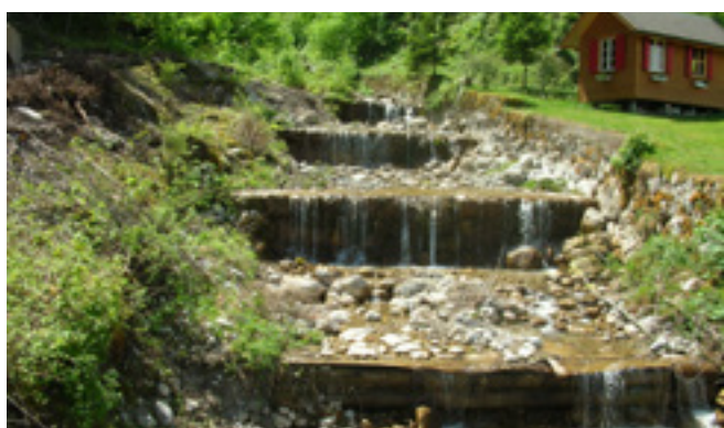
Abbildung 30: Sohlentreppe. Foto: Fredy Elber, AquaPlus AG. Figure 30 : Lit en escalier. Photo : Fredy Elber, AquaPlus AG.
