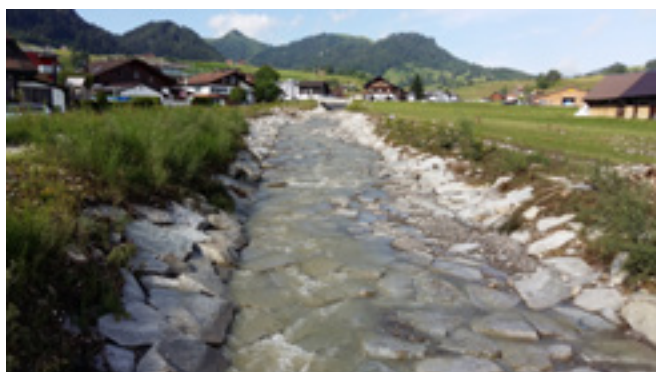
Abbildung 29: Raubett. Foto: Fredy Elber, AquaPlus AG. | Figure 29 : Lit rugueux. Photo : Fredy Elber, AquaPlus AG.
