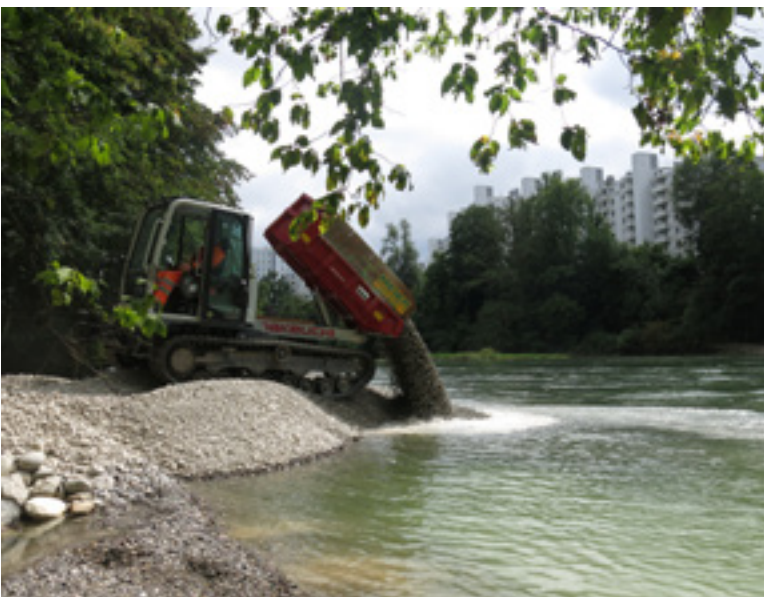
Abbildung 8: Kiesschüttung an der Limmat bei Wettingen im Jahr 2021. Foto: Manuel Nitsche | Figure 8 : Couche de gravier sur la Limmat à Wettingen en 2021. Photo : Manel Nitsche
