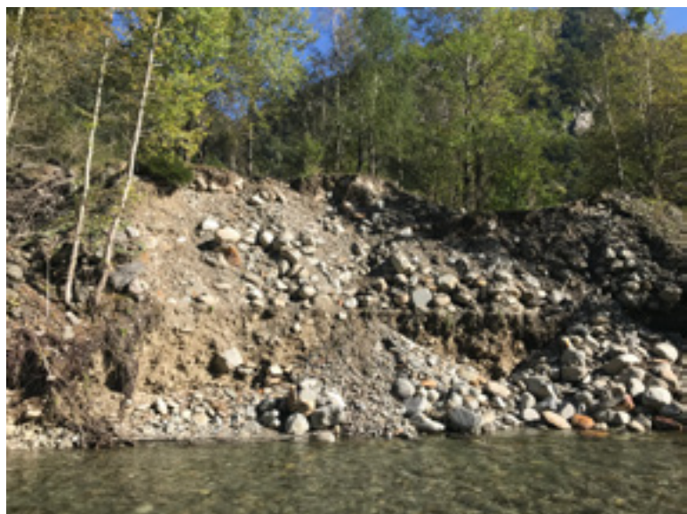
Abbildung 2: Seitenerosion im verzweigten Abschnitt der Moesa bei Cabbio [Foto: VAW] | Figure 2 : Érosion latérale dans la section ramifiée de la Moesa près de Cabbio [Photo : VAW].
