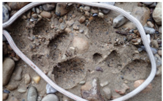
Abbildung 24: Kolmatisierte Gewässersohle, entfernte Deckschicht. Foto: Mathieu Camenzind, AquaPlus AG. | Figure 23 : Lit de cours d'eau affouillé, couche superficielle enlevée. Photo : Mathieu Camenzind, AquaPlus AG.
