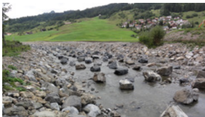
Abbildung 31: Sohlenanreicherung mit Blöcken / Blockbelegung. Foto: Fredy Elber, AquaPlus AG. | Figure 31 : Enrichissement du fond avec des blocs / revêtement en blocs. Photo : Fredy Elber, AquaPlus AG.
