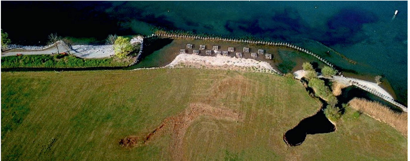
Abbildung 3: Der Blick auf den umgestalteten Projektbereich zeigt deutlich den von Süden (links) nach Norden (rechts) zunehmenden Bereich des flacheren Seegrunds, der mit Wellen interagiert. Quelle: Schelbert AG, Muotathal.
