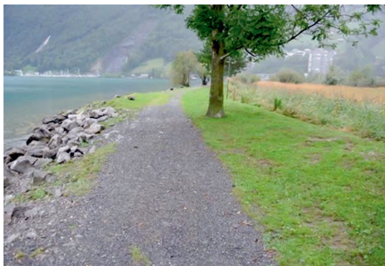
Abbildung 1: Künstlich geschütteter Damm zwischen Flachmoor und Vierwaldstättersee mit Blocksteinschüttung.
