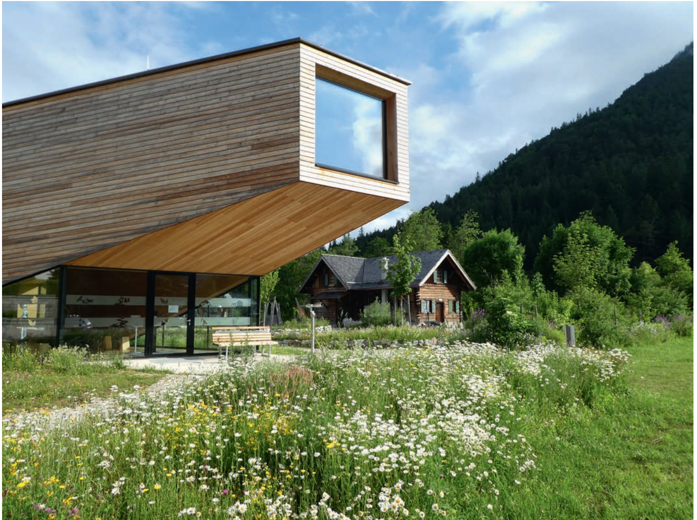
Abbildung 3: Blühstreifen zur Abgrenzung zum Parkplatz vor dem Naturpark-Infozentrum Scharnitz [Foto: Anton Heufelder]. Figure 3 : Bande fleurie pour délimiter le parking devant le centre d'information du parc naturel de Scharnitz [photo : Anton Heufelder].
