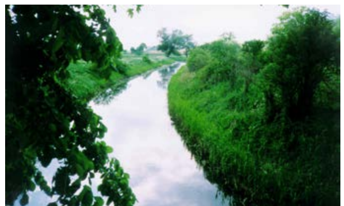
Abb. 3: Spontaner Gehölzwuchs an der Peene wird mit dem Ziel der Renaturierung nicht entfernt.
