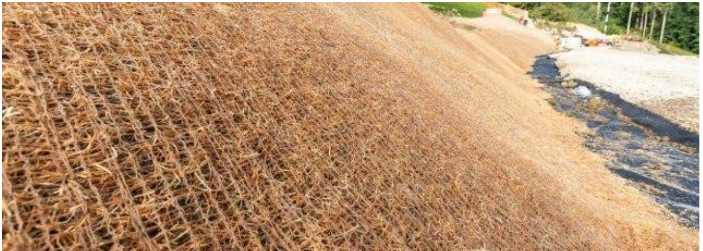
Abb. 8: Mit schweizer Holzwollevliesen belegte Böschung in der Ostschweiz (vorher). Fig. 8 : Talus recouvert de nattes en laine suisse de bois en Suisse orientale (avant).
