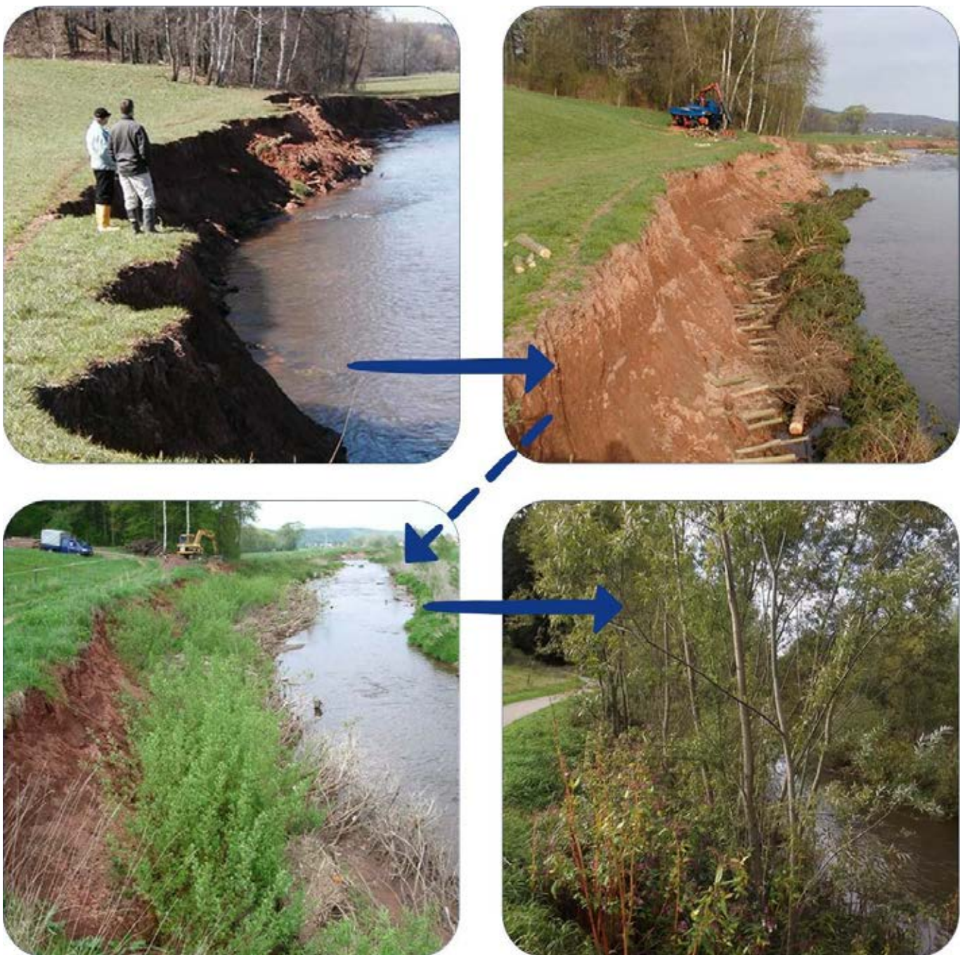
Abb. 2: Einbau und Entwicklung von Raubbäumen in Kombination mit Weidensetzstangen am Beispiel des Lungwitzbaches zwischen St. Egidien und Niederlungwitz [links oben 2005, rechts unten 2012].
