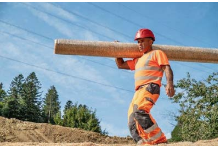
Abb. 2: Schweizer Holzwollevliesen ab Rolle. Fig. 2 : Nattes de laine suisse de bois en rouleau.
