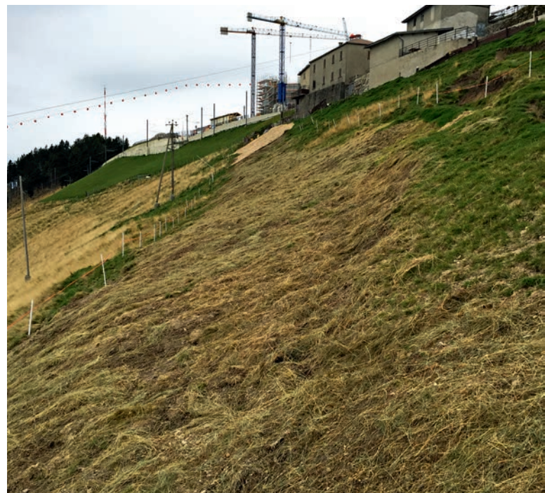
Figura 16: inerbimento diretto con fieno proveniente da prati donatori adiacenti allo scavo. | Abbildung 16: Direktbegrünung mit Heu von Spenderwiesen neben der Baugrube.
