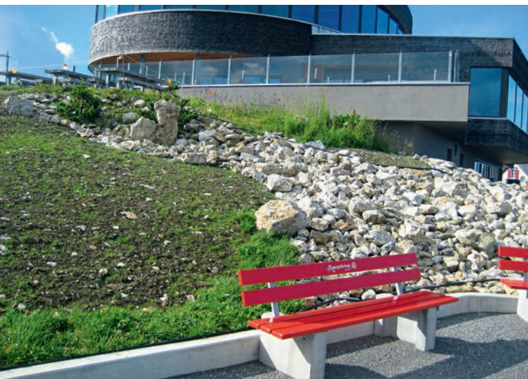
Abb. 15: Angesäte Wiese mit verlegten Raseniegeln und Kalk-Schutthalde oberhalb des Europa-Rundwegs am 6. August 2016. | Fig. 15 : Prairie ensemencée avec des mottes de gazon transplantées et un pierrier calcaire en amont du circuit de l'Europe le 6 août 2016.
