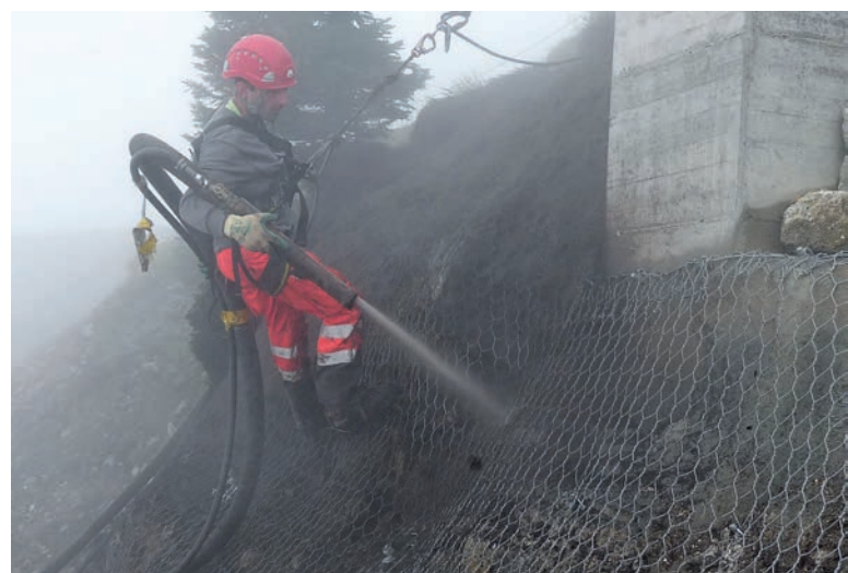
Abb. 12: Die steilen Stellen wurden mit einem Drahtnetz überzogen, das mit einem Substrat bespritzt wurde [8. Oktober 2015]. | Fig. 12 : Les zones abruptes ont été recouvertes d'un treillis métallique, aspergé avec un substrat [8 octobre 2015].
