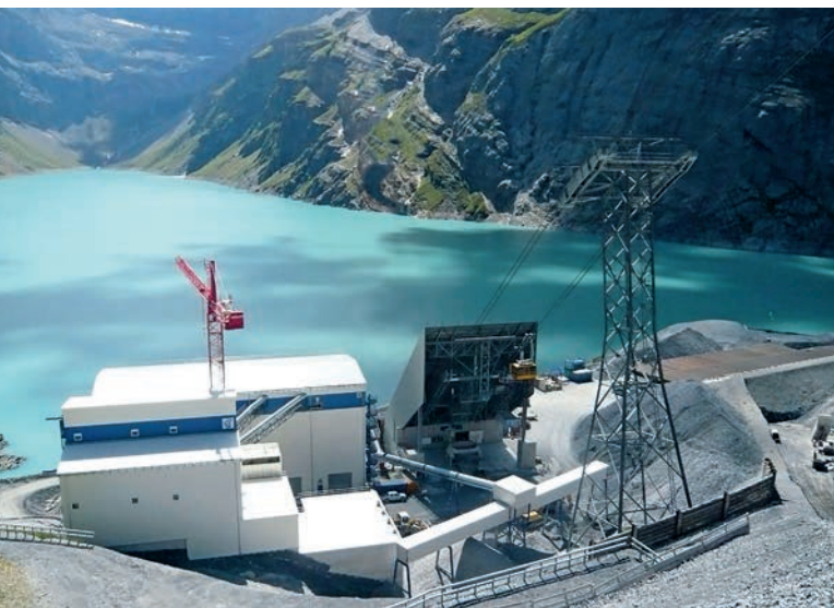
Abbildung 23: Kieswerk Ochsenstäfeli und Talstation Bauseilbahn 2 von oben im Jahr 2011. | Figure 23 : Gravière d'Ochsenstäfeli et station inférieure du téléphérique de chantier 2 vue d'en-dessus en 2011.
