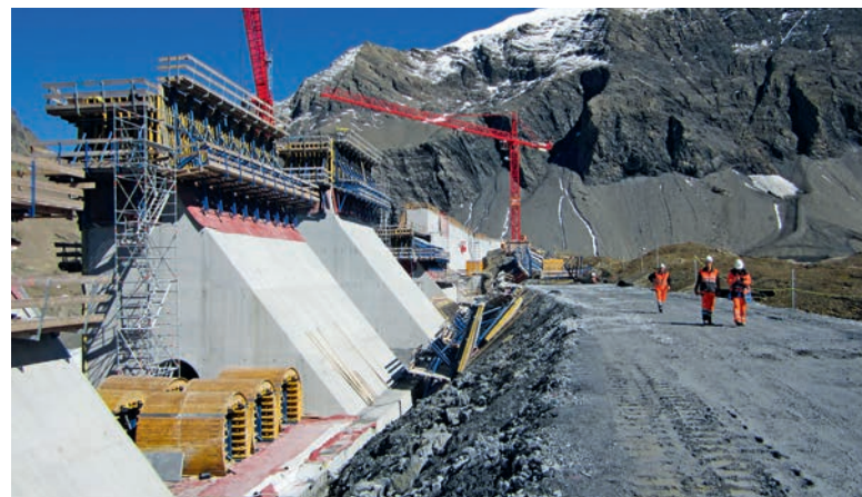
Abbildung 11: Staumauer Muttsee von der Luftseite mit der temporären Baupiste und der Absperrung der Schutzzone Muttan. | Figure 11 : Barrage du Muttsee du côté aval avec la piste de construction temporaire et l'interdiction d'accès à la zone de protection de Muttan.
