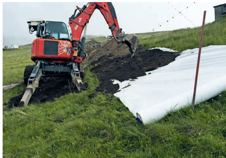
Figura 9: posa di geotessile per la protezione delle superfici erbose. | Abbildung 9: Verlegung von Geomatten zum Schutz von Vegetationsflächen.
