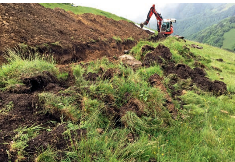
Figura 12: separazione delle zolle da trapianto durante lo scavo. | Abbildung 12: Trennung der Schollen zur Rekultivierung während dem Aushub.
