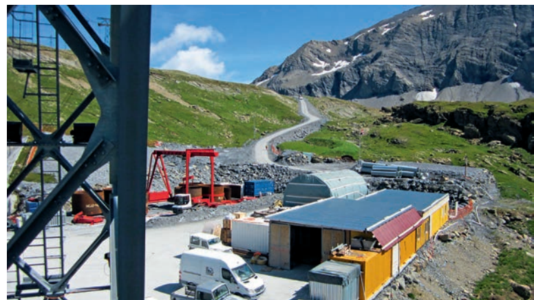
Abbildung 25: Installationsplatz Fensterstellen mit Baupiste zum Muttsee im Hintergrund im August 2012. | Figure 25 : Site d'installation de la galerie d'accès avec la piste de construction vers le Muttsee en arrière-plan en août 2012.
