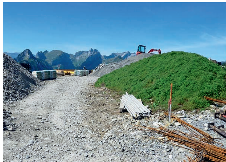
Abb. 5: Die Bodendepots wurden mit Büschelblume [ Phacelia tanacetifolia Benth.] begrünt (Erosionsschutz). Die Foto zeigt das Oberbodendepot am 27. August 2015. | Fig. 5 : Les dépôts de terre ont été végétalisés à l'aide de phacélies à feuilles de tanaïs [ Phacelia tanacetifolia Benth.] (protection contre l'érosion). La photo montre le dépôt de terre végétale le 27 août 2015.
