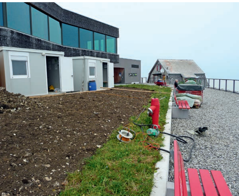
Abb. 10: Zurückverlegte Rasenziegel, humusierte Flächen und bodenschonende Vorkehrungen, um zu den Containern zu gelangen [29. Juni 2016]. | Fig. 10 : Mottes de gazon replacées, zones recouvertes d'humus et dispositions pour préserver le sol afin d'accéder aux conteneurs [29 juin 2016].
