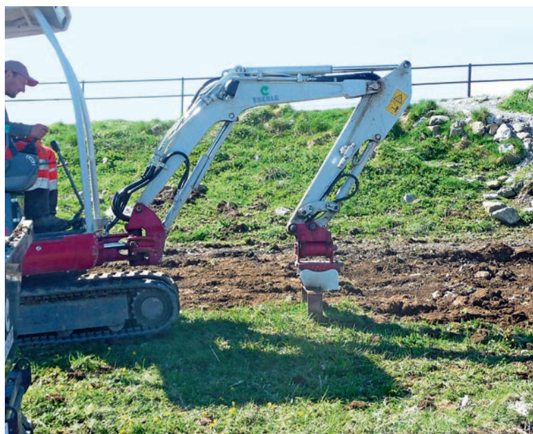
Abb. 8: Um die Rasenziegel entfernen zu können, hat die Eberle Landschaftsbau und Grüntechnik AG eine Spezialvorrichtung geschaffen. Der leichte Raupenbagger mit der Spezialvorrichtung steht auf der Grasnarbe [28. Mai 2015]. | Fig. 8 : Afin de pouvoir retirer les mottes de gazon, Eberle Landschaftsbau und Grüntechnik AG a créé un dispositif spécial. La pelle mécanique légère avec le dispositif spécial se tient sur la couche végétale [28 mai 2015].
