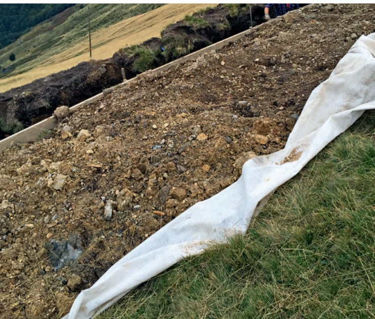
Figura 11: trincea di scavo con separazione degli orizzonti A e B+C. L'orizzonte A, composto dalle zolle inerbite è situato a valle dello scavo, gli orizzonti B+C sono situati a monte dello scavo. | Abbildung 11: Baugrube mit Trennung der A- und B+C-Horizonte. Der A-Horizont, bestehend aus den grasartigen Ziegeln, befindet sich talabwärts des Grabens, die B+C-Horizonte befinden sich bergseitig.
