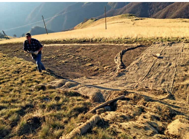
Figura 19: posa di biostuoia a protezione delle superfici inerbite. | Abbildung 19: Verlegung von Bio-Matten zum Schutz der Rasenflächen.
