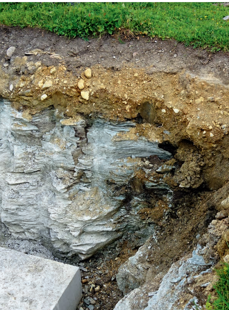
Abbildung 5: Bodenprofil bei einer Baugrube im Gebiet Alp Surlej. | Figure 5 : Profil pédologique lors d'une excavation dans la région de l'Alp Surlej.
