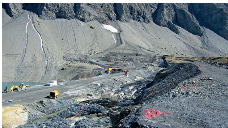
Abbildung 7: Baustelle Muttsee mit dem bereits sichtbaren Graben für das Fundament der Staumauer. | Figure 7 : Chantier du Muttsee avec la tranchée déjà visible pour les fondations du barrage.
