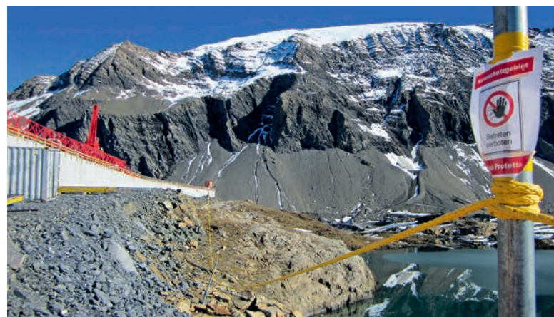
Abbildung 12: Absperrung der Schutzzone Muttan auf der Luftseite der Staumauer. | Figure 12 : Interdiction d'accès à la zone de protection de Muttan sur le côté aval du barrage.
