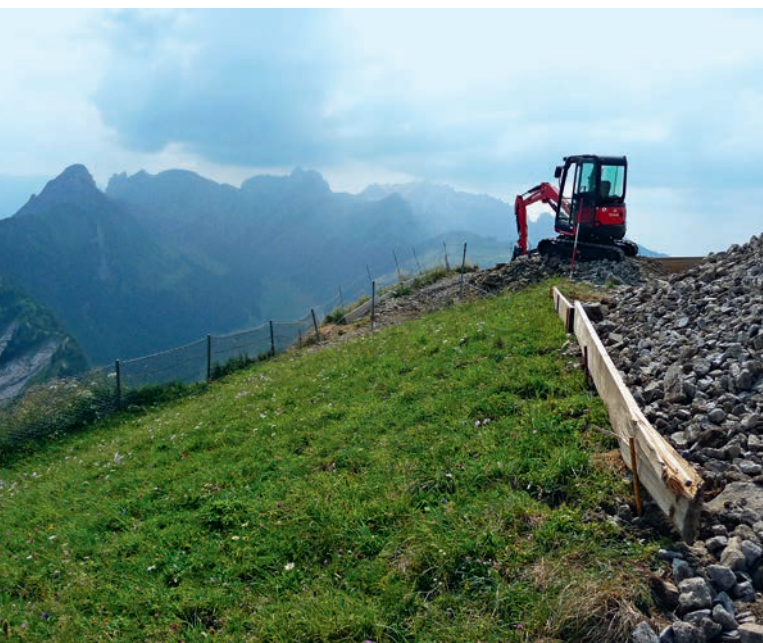
Abb. 7: Die Wiesen wurden in einem Arbeitsgang, also direkt, verlegt [16. Juli 2015]. | Fig. 7 : Les prairies ont été posées en une seule opération, c'est-à-dire directement [16 juillet 2015].
