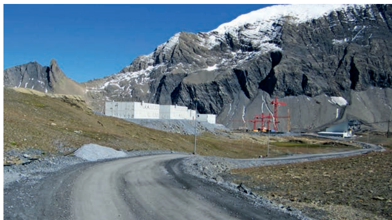
Abbildung 6: Baupiste Fensterstallen - Muttsee mit dem Camp Muttsee (links), der Baustelle der Staumauer (Kräne in der Mitte) und der Bergstation der Bauseilbahn 2 (ganz rechts). | Figure 6 : Piste de construction de la galerie d'accès au lac Muttsee avec le camp de Muttsee (à gauche), le chantier de construction du barrage (grues au milieu) et la station supérieure du téléphérique de chantier 2 (tout à droite).
