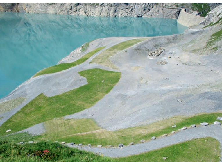
Abbildung 24: Bereich des rückgebauten Kieswerks und Talstation der Bauseilbahn 2 im Ochsenstäfeli im Juli 2019. | Figure 24 : Zone de la gravière démantelée et station inférieure du téléphérique de chantier 2 à Ochsenstäfeli en juillet 2019.
