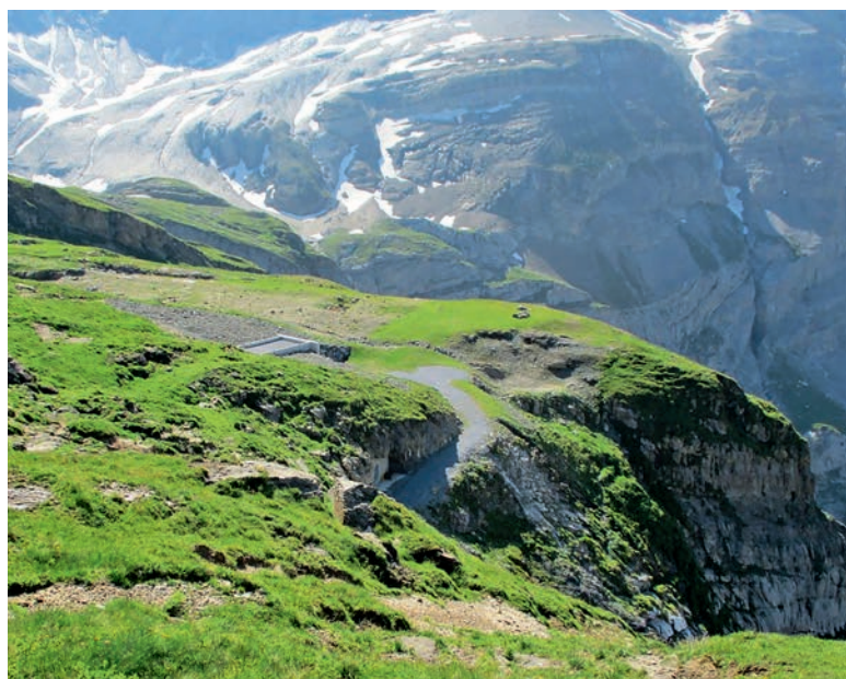
Abbildung 32: Rekultivierter Installationsplatz Fensterstallen im Juli 2019 von oben. | Figure 32 : Site d'installation de la galerie d'accès remise en culture en juillet 2019, vu d'en-dessus.
