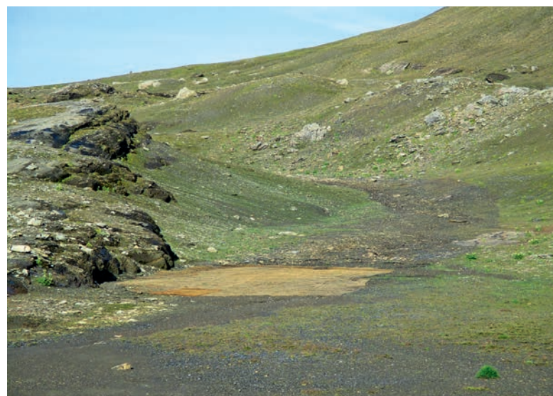
Abbildung 22: Rückgebauter und bereits angepflanzte bzw. angesäte und teilweise mit Kokosmatten abgedeckte Fläche der Baupiste Fensterstollen – Mutsee im August 2018. | Figure 22 : Surface de la piste de construction galerie d'accès - Mutsee démontée et déjà plantée, resp. ensemencée et partiellement recouverte de nattes de coco en août 2018.
