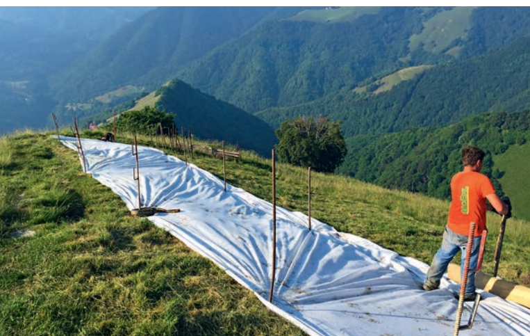
Figura 8: lavori preparatori manuali di sfalcio e protezione delle superfici erbose. | Abbildung 8: Manuelle Vorbereitungsarbeiten zum Mähen und Schützen von Vegetationsflächen.
