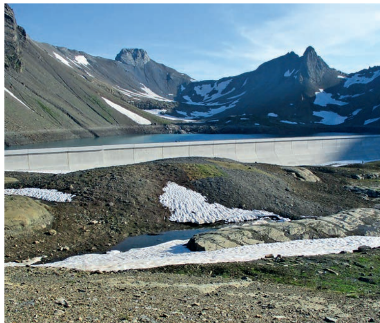
Abbildung 34: Staumauer Muttsee mit dem Bereich der rekultivierten Bergstation der Bauseilbahn 2 (links im Bild) im Juli 2019. | Figure 34 : Barrage de Muttsee avec la zone de la station supérieure du téléphérique 2 remise en culture (à gauche) en juillet 2019.
