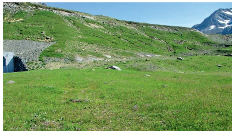
Abbildung 26: Installationsplatz Fensterstellen mit der rückgebauten Baupiste (rechts oben) im Juli 2019. | Figure 26 : Site d'installation de la galerie d'accès avec la piste de construction démantelée (en haut à droite) en juillet 2019.
