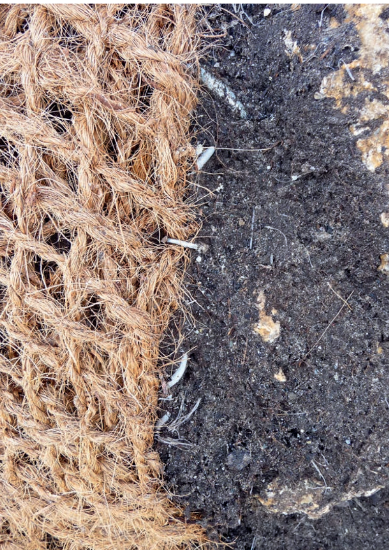
Abb. 13: Drahtnetz und Substrat wurden dann mit einem Kokosfaser-Netz überdeckt [24. Oktober 2015]. | Fig. 13 : Le treillis et le substrat ont ensuite été recouverts d'un filet en fibre de coco [24 octobre 2015].
