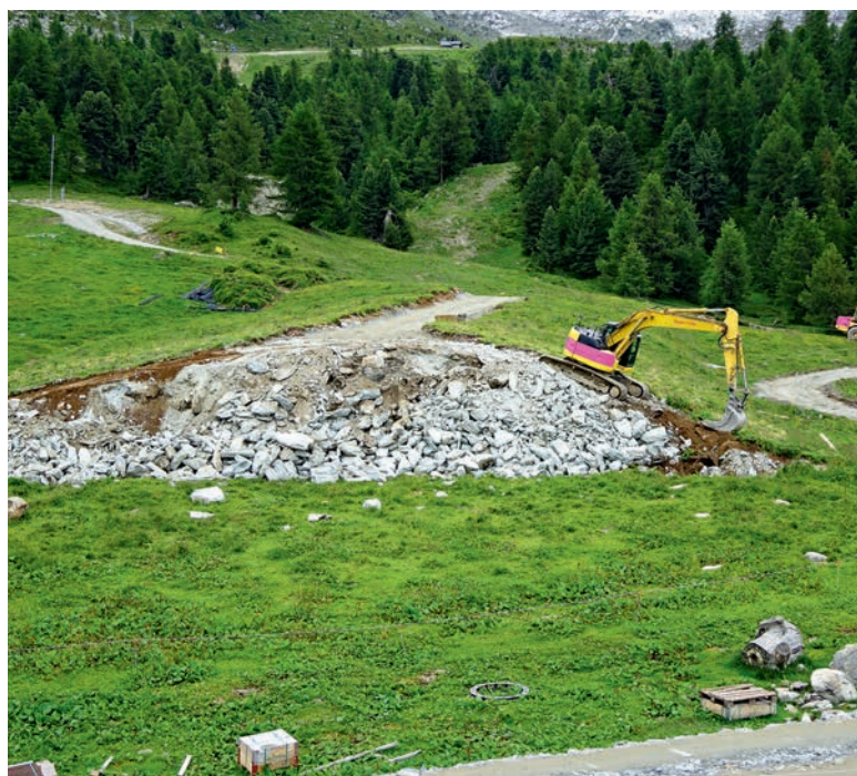
Abbildung 6: Bauarbeiten im Gebiet, hier Einbau des Felsausbruchs und Direktumlagerung von Rasenziegeln. | Figure 6 : Travaux de construction dans la région, ici mis en place de la roche extraite et transposition directe des plaques de gazon.
