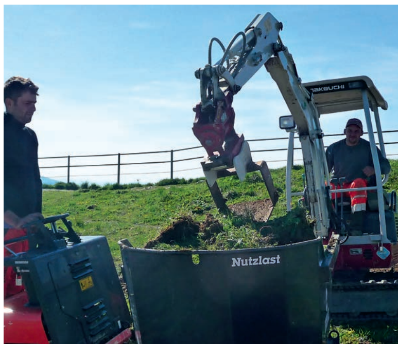
Abb. 9: Mit der Spezialvorrichtung der Eberle Landschaftsbau und Grüntechnik AG können die Rasenziegel in einer Mächtigkeit von 10 cm abgetragen werden [28. Mai 2015]. | Fig. 9 : Avec le dispositif spécial de Eberle Landschaftsbau und Grüntechnik AG, les mottes de gazon peuvent être enlevées jusqu'à une épaisseur de 10 cm [28 mai 2015].
