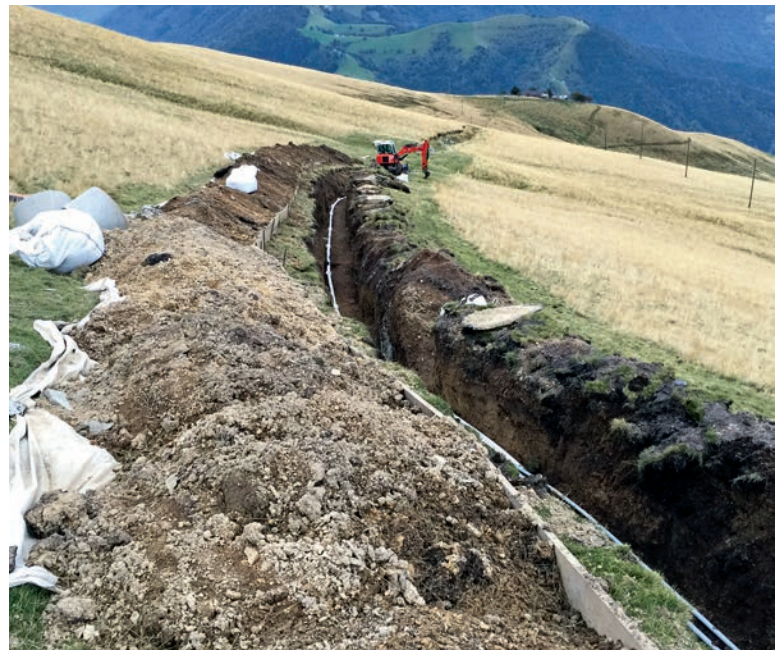
Figura 10: trincea di scavo con separazione degli orizzonti A e B+C. | Abbildung 10: Baugrube mit Trennung der A- und B+C-Horizonte.
