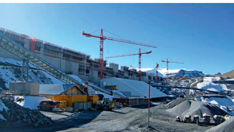
Abbildung 10: Staumauer Muttsee von der Seeseite. | Figure 10 : Le barrage de Muttsee depuis le côté lac.
