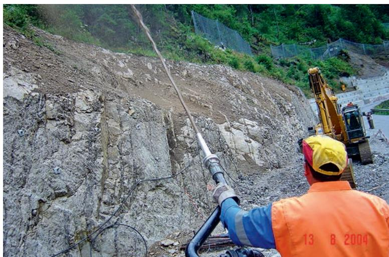
Abbildung 27: Nasssaat-Verfahren [Bild: T. Schmid] | Figure 27 : Procédure de végétalisation avec semis hydraulique [photo : T. Schmid].
