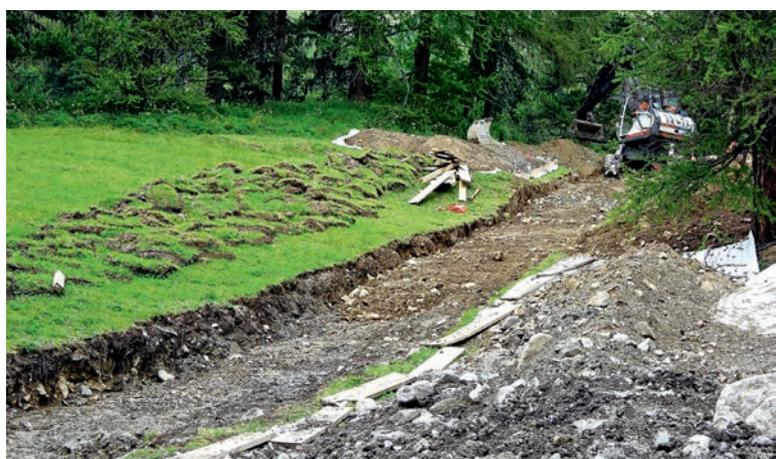
Abbildung 19: Kurzfristige Lagerung von Soden direkt auf der bestehenden Vegetation. Die Bodendepots werden auf Trennfliess geschüttet [Foto: K. Edelkraut]. | Figure 19 : Stockage à court terme des plaques de gazon directement sur la végétation existante. Les dépôts de terre sont versés sur un revêtement de séparation [photo : K. Edelkraut].
