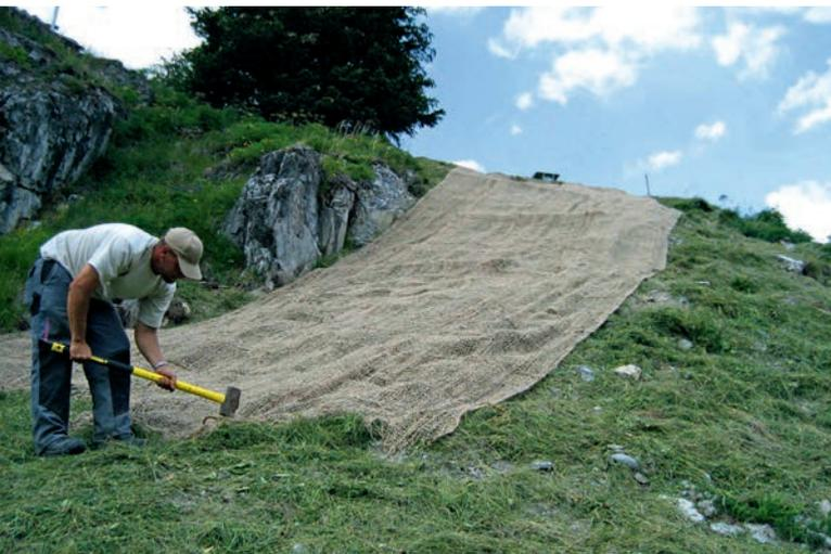
Abbildung 30: Befestigung der Geotextilien mit Holznägeln. Dabei ist auf durchgehenden Bodenkontakt zu achten, insbesondere bei engmaschigen Geweben und Matten [Foto: M. Schwager]. | Figure 30 : Fixation des géotextiles avec des clous en bois. Il faut veiller à assurer un contact continu avec le sol, en particulier avec les toiles et les nattes à mailles serrées [photo : M. Schwager].
