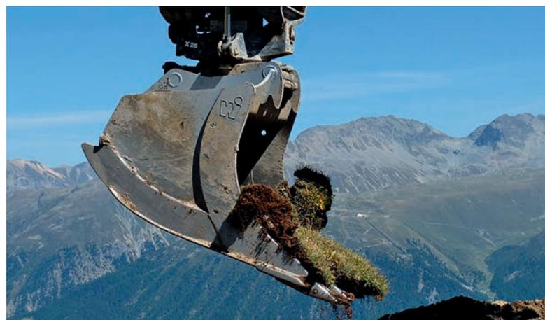
Abbildung 17: Soden werden sorgfältig mit der Baggerschaufel abgeschält (Foto: T. Schmid). | Figure 17 : Les mottes sont soigneusement robotées à l'aide de la pelleuse (photo : T. Schmid).
