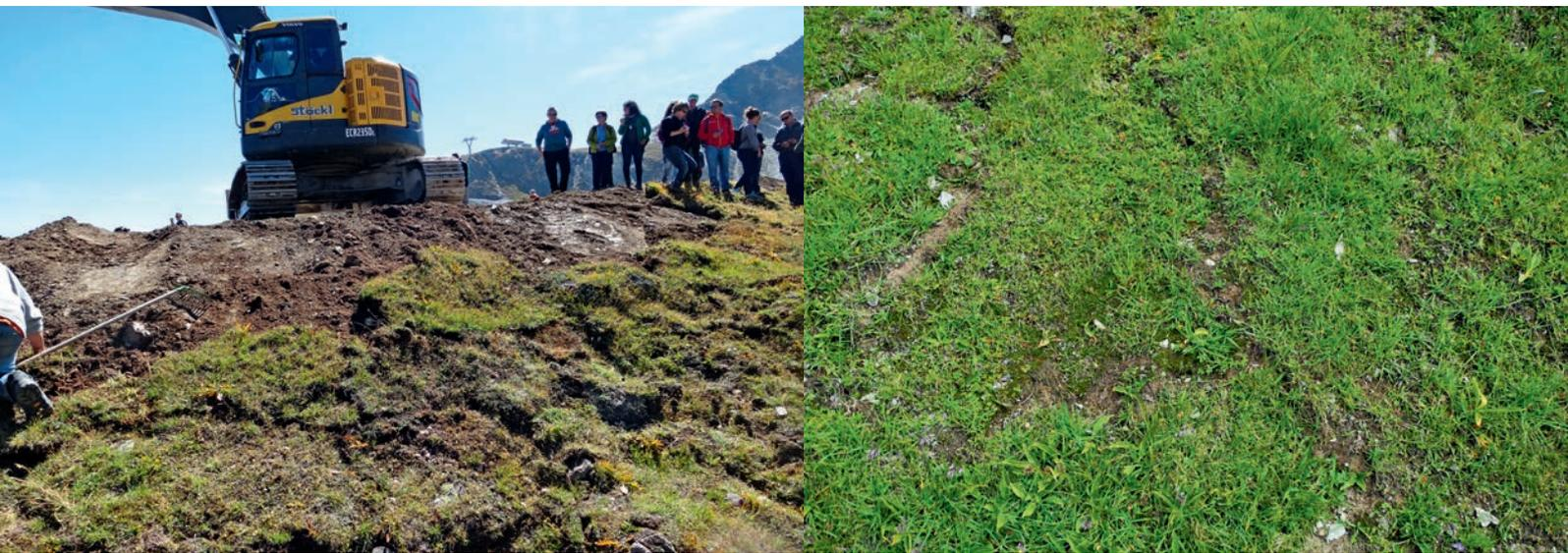
Abbildung 24: Beim Sichern und Setzen der Soden sind Bagger- und Handarbeit gefragt (Foto: B. Krüsi). Später ist der Eingriff kaum bis gar nicht mehr zu sehen (Foto: K. Edelkraut). | Figure 24 : La fixation et la pose des plaques de gazon nécessitent une pelleteuse et du travail manuel (photo : B. Krüsi). Par la suite, l'intervention n'est pratiquement plus ou pas visible du tout (photo : K. Edelkraut).
