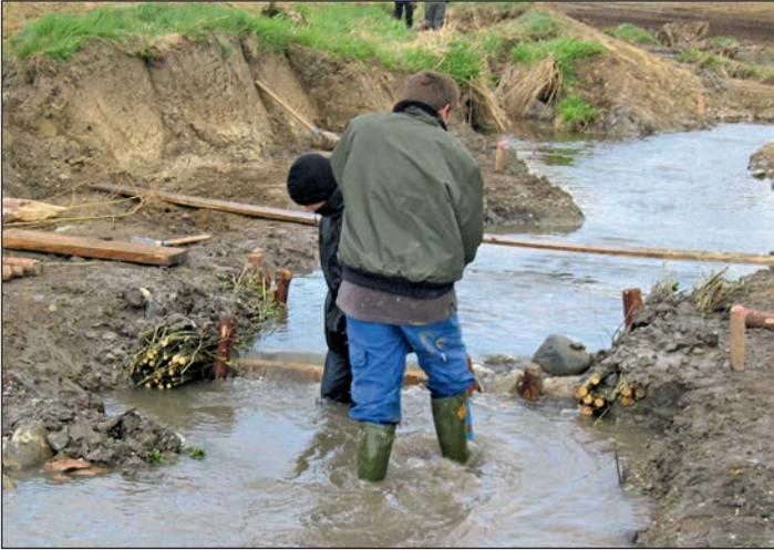
Abbildung 10: Holzschwelle mit seitlichem Erosionsschutz
