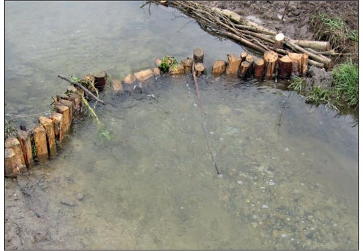
Abbildung 11: Schwelle: Ausbuchtung gegen die Strömung. Mitte etwas abgesenkt, dass Kolk nicht aussen ist seitlicher Uferschutz mit Faschinen
