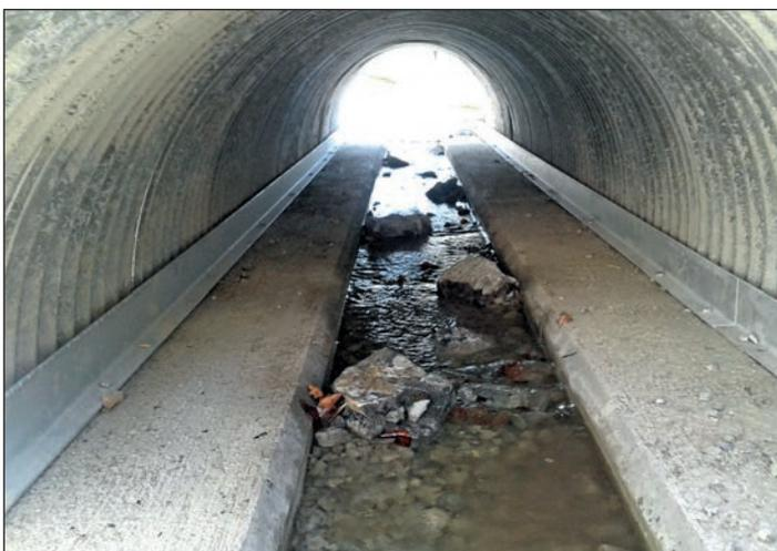
Foto 14: Die Fachstelle Naturschutz (Kt. ZH) empfiehlt, auf den Betonbanketten längs des Wellstahls ein Führungsblech für Amphibien einzubauen
