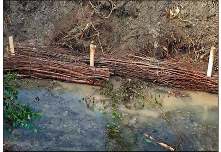
Abbildung 7: Faschinen ziegelartig eingebaut
