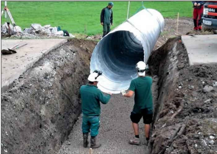
Foto 10: Einbau des Wellstahlrohrs zu Beginn des Nachmittags im Anschluss an die am Vormittag erfolgten Grabarbeiten
