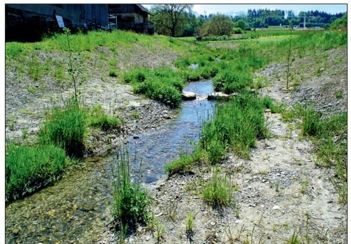
Foto 2: Beispiel einer Schwelle mit tiefer gesetztem Stein bei der Niederwasserrinne.
