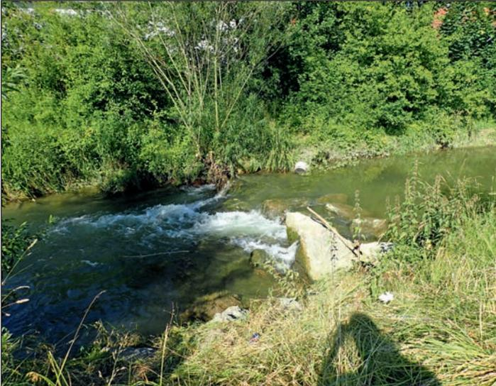
Abbildung 8: Teilweise offene Blockschwellen dienen der Sohlenfixierung und ermöglichen die freie Fischwanderung ohne Absturz
