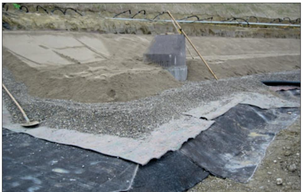
Bild 2: Eingebaute Bentonitmatte (schwarz), hier in einer Strassenabwasserbehandlungsanlage (SABA). Darüber Filterschichten
