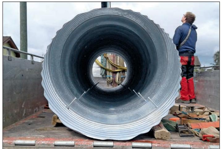
Foto 13: Wellstahlrohre können mit Verschraubungen für den Verbund der nachträglich einbetonierten Bankette versehen werden
