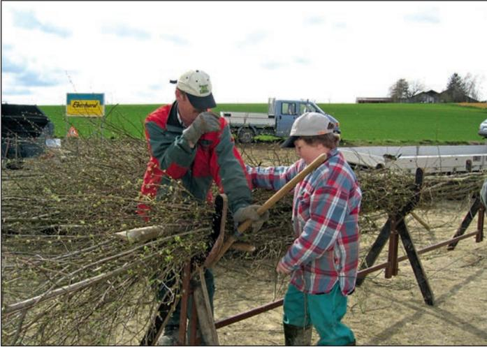
Abbildung 6: Faschinenbock mit Spannwägli
