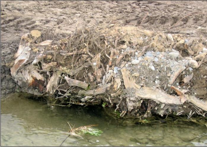
Abbildung 3: Wurzelstock mit Stamm, umgekehrt eingebaut
