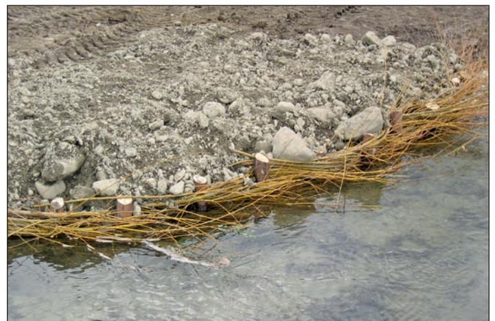
Abbildung 9: Fertig erstelltes und hinterfülltes Weidenflechtwerk
