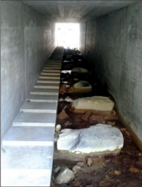
Foto 18: Beispiel eines Rechteckdurchlasses mit einseitigem Bankett und Niederwasserrinne mit (eher groben) Störsteinen. Dieser Rechteckdurchlass ist aufgrund der Höhe gut für Unterhaltspersonal zugänglich
