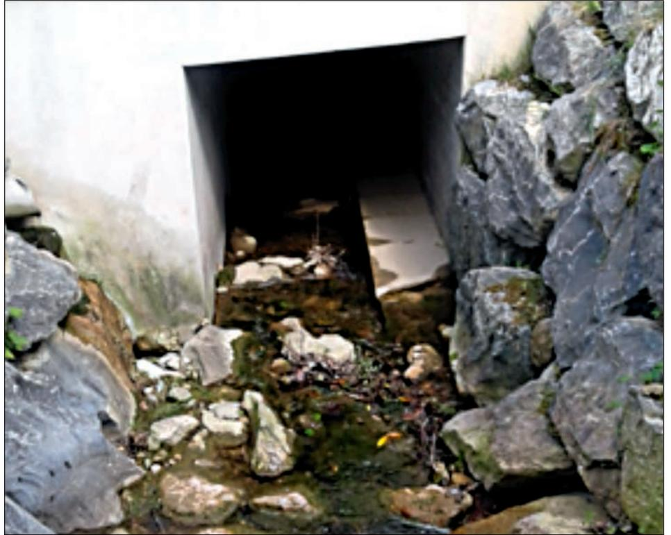
Foto 20: Das Bankett soll nicht nur durch den Durchlass hindurchgezogen werden, sondern auch beim Ein- und Auslauf eine Anbindung an die Umgebung aufweisen. Das ist hier nicht ideal gelungen
