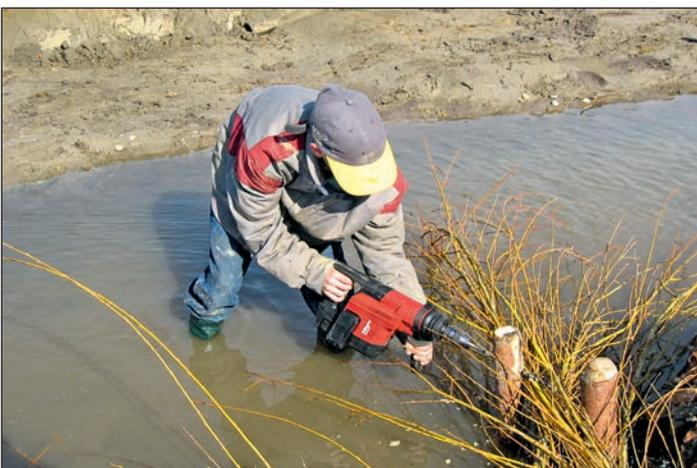
Abbildung 8: Bohren der Fichtenpfähle für Drahtbindung
