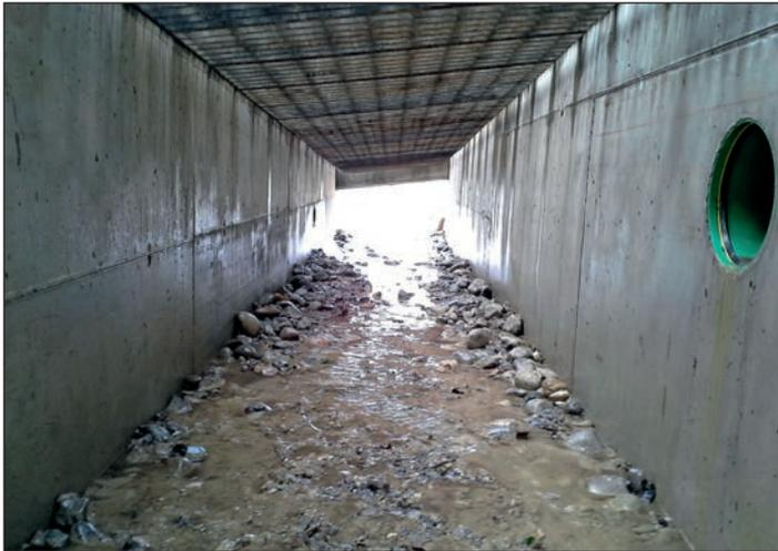
Foto 22: Blick in den Durchlass. Beim Beispiel wurde allerdings das Bankett nicht mit Beton oder Steinblöcken durchgezogen
