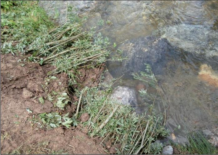
Abbildung 12: Uferanbindung einer Lenkbuhne mit Weidenbuschlagen (Fließrichtung von unten rechts nach oben links)
