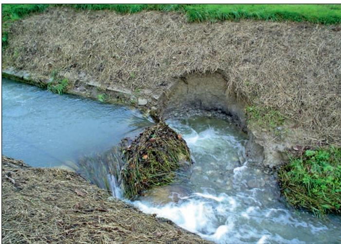
Foto 1: Beispiel einer aufgrund von liegendebliebenem Schwemmgut seitlich umspülen, zu wenig in die Böschung eingebundenen Schwelle
