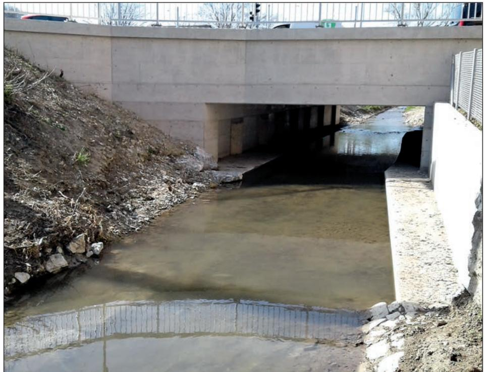
Foto 5a: Durchlass und anschliessender Abschnitt mit deutlich verbreiteter Sohle gegenüber den ober- und unterhalb liegenden Abschnitten und entsprechend feinkörnigen Ablagerungen
