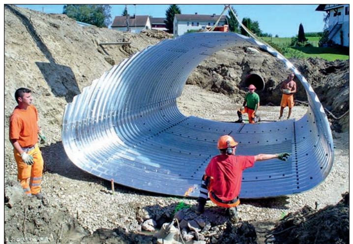
Foto 15: Beispiel des Einbaus eines Maulprofils
