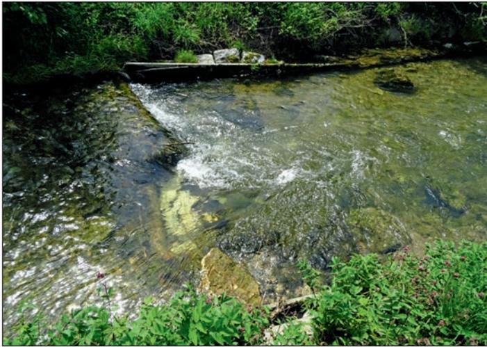
Abbildung 3: Beschädigte Sohlenschwelle (Q = 450 l/s)
