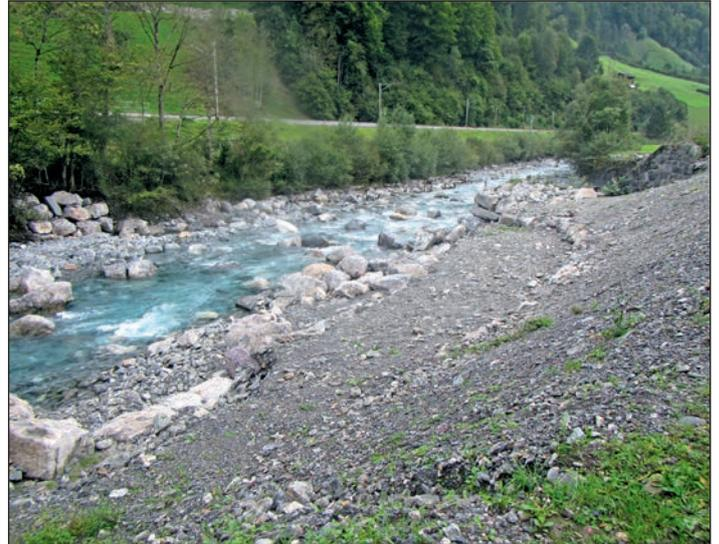
Abbildung 9: Ein ehemaliges Wehr in der Linth wurde abgebrochen und an dessen Stelle wird die Höhenstufe mit einer aufgelösten Blockrampe überwunden. Auch für Klein- und Jungfische ist dieser Abschnitt damit fischgängig
