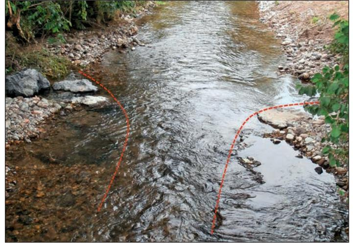
Abbildung 13: Strömungstrichter unterstrom der Brücke (GEWISS-km 9.790), im Bereich der ehemaligen Auflandungen (vgl. Abb. 6) mit Rot gestrichelt dargestellten Bühnhinterkanten (Blick in Fließrichtung,  $Q = 240 \text{ l/s}$ )
