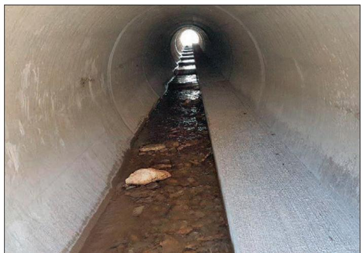
Foto 9: Beispiel mit einseitigem Bankett. Damit dessen Oberfläche nicht zu glatt ist, wird ein längslaufender Besenstrich empfohlen.
