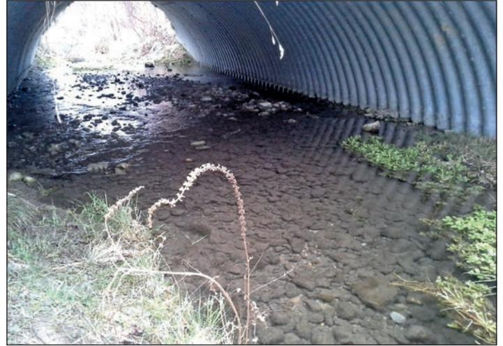
Foto 17: Beispiel, bei dem die durchgezogenen Böschungen durch Hochwasser ausgeschwemmt wurden. Dafür besteht eine durchgehend natürliche Sohle
