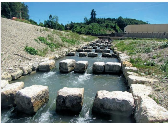
Abbildung 3: Ein naturnaher Raugerinne-Beckenpass erlaubt auch optisch ansprechende Lösungen zur Ermöglichung der freien Fischwanderung zu finden, im Bild das Umgehungsgewässer des neuen KW Hagneck BE
