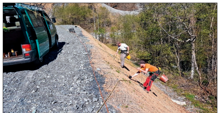
Abbildung 12: Bepflanzung mit Weidensteckhölzern und Ansaat (Ende April 2017). Die abgerutschten Stellen der Böschung wurden vorgängig wiederhergestellt. Die Bepflanzung mit Weidensteckhölzern erfolgte am Seil gesichert. Die Löcher für die Steckhölzer wurden vorgebohrt.
