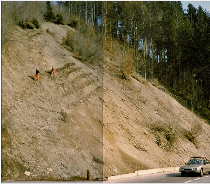
Abbildung 3: Beispiel 1. Oberflächenstabilisierung Heidenweidli, Simmentalstrasse: Einbau von Pickelrillen auf roher Oberfläche – Gesamtansicht (links) und Detail der Weidenstecklinge (rechts).
