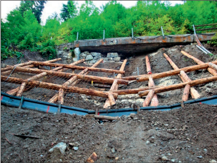
Abbildung 5: Mullernstrasse: Hangrost im Bau. Der fertig gestellte Hangrost abgestützt auf die Kanaldielenwand vor dem Einfüllen. Die vertikalen Rundhölzer sind hinter den Kanaldielen abgestützt.
