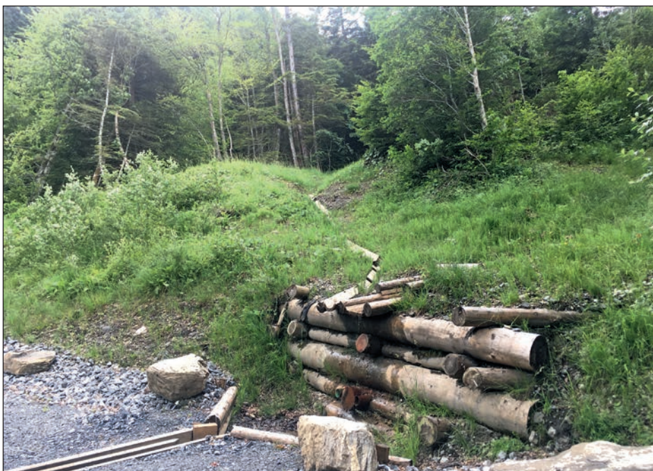
Abbildung 1: Modelliertes und bepflanztes Gelände zur gelenkten Wasserableitung und Stabilisierung (Foto: Ch. Spring).
