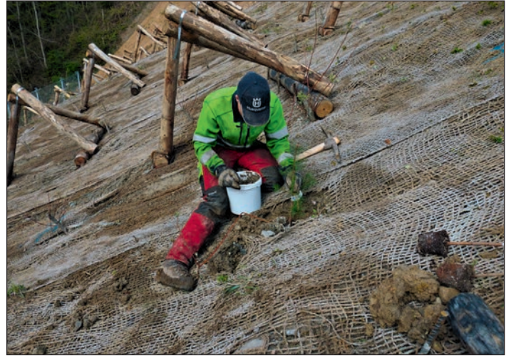
Abbildung 11: Hangstabilisierung Hergiswaldstrasse. Beigabe der Mykorrhiza-Präparate bei der Pflanzung.
