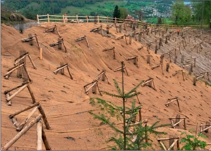
Abbildung 10: Hangstabilisierung Hergiswaldstrasse. Überblick nach Pflanzung.
