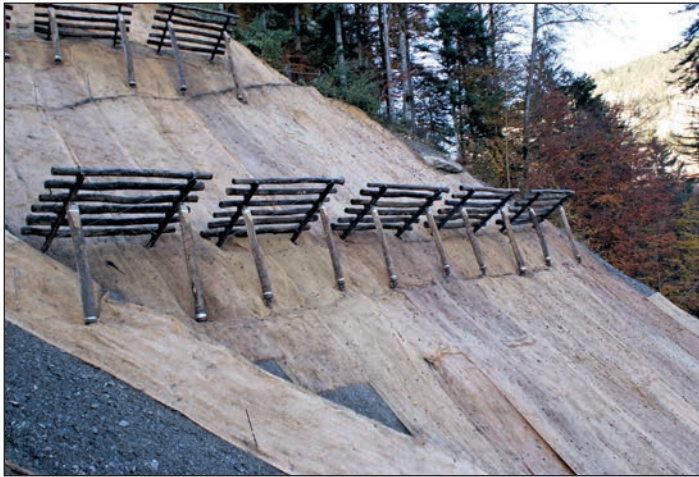
Abbildung 1: Holzwollevliese schützen den Hang beim neu erstellten Trassee der Stoos- Standseilbahn vor Erosion und begünstigen das schnelle Aufkommen des ausgebrachten Saatguts.
