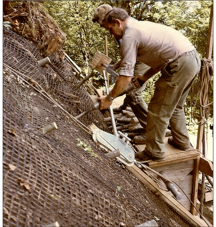
Abbildung 2: Versetzarbeit auf einem improvisierten Arbeitspodest.
