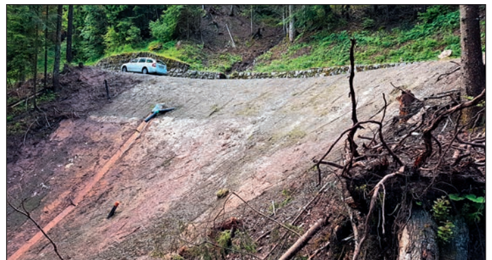
Abbildung 10: Fliessenstrasse: Drei Wochen nach Fertigstellung (Ende Juni 2016). Die beiden Holzkaisten sind vollständig eingedeckt und in der Böschung nicht mehr sichtbar. Das Wasser aus dem Durchlass wird mit einem V-Kännel über die Böschung geleitet. Die Ansaat hat bereits gekeimt und die Böschung begrünt sich.
