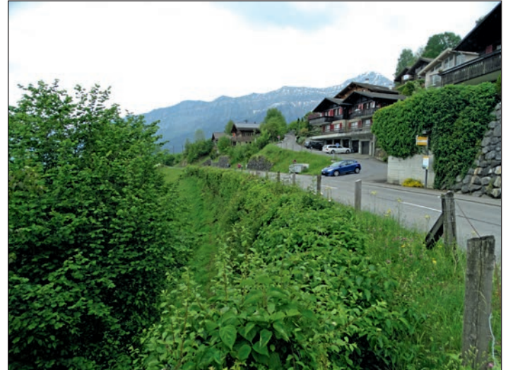
Abbildung 11: Beispiel 5. Bepflanzte Geotextilwände in Krattigen sind als Stützmauer kaum mehr zu erkennen. Figure 11: Exemple 5. Les parois végétalisées en géotextile à Krattigen sont à peine reconnaissables en tant que mur de soutènement.
