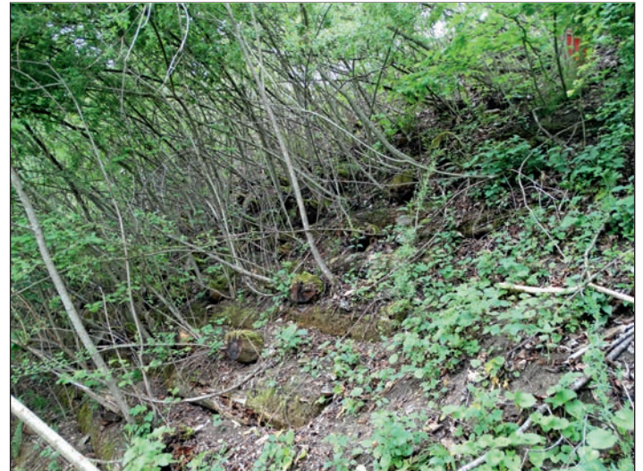
Abbildung 9: Beispiel 4. Heutiger Zustand im Friberig: Die Weiden sind noch recht dominant (links), die Holzkasten erfüllen ihre Funktion der tiefgreifenden Stabilisation (rechts).
