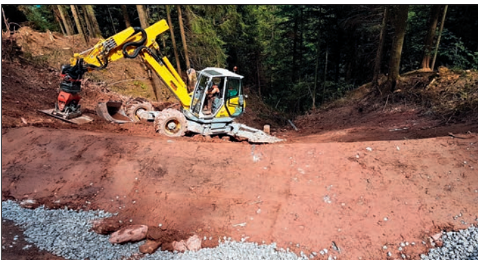
Abbildung 9: Fliessenstrasse: Verdichten mit Anbau-Plattenvibrator.
