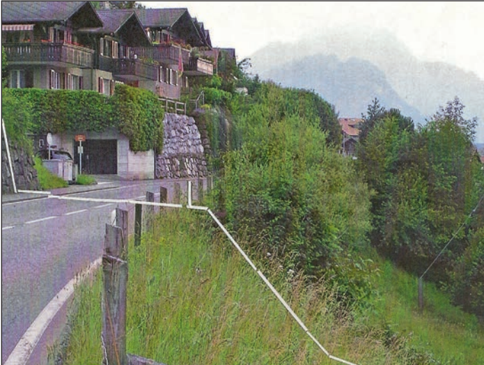
Abbildung 11: Beispiel 5. Bepflanzte Geotextilwände in Krattigen sind als Stützmauer kaum mehr zu erkennen. Figure 11: Exemple 5. Les parois végétalisées en géotextile à Krattigen sont à peine reconnaissables en tant que mur de soutènement.
