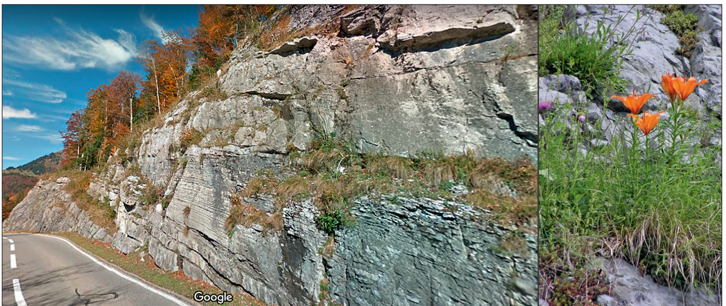
Abbildung 14: Beispiel 8. Felsabträge strukturieren (links) ergibt die Möglichkeit, um die vorhandene Vegetation wieder anzusiedeln (rechts). Zudem fügen sich solche Eingriffe viel besser in die Landschaft ein, als senkrecht abgeschrotete Wände. Figure 14: Exemple 8. Les déroctages structurés (à gauche) permettent le rétablissement de la végétation existante (à droite). De plus, ces interventions s'intègrent beaucoup mieux dans le paysage que des parois dégagées verticalement.
