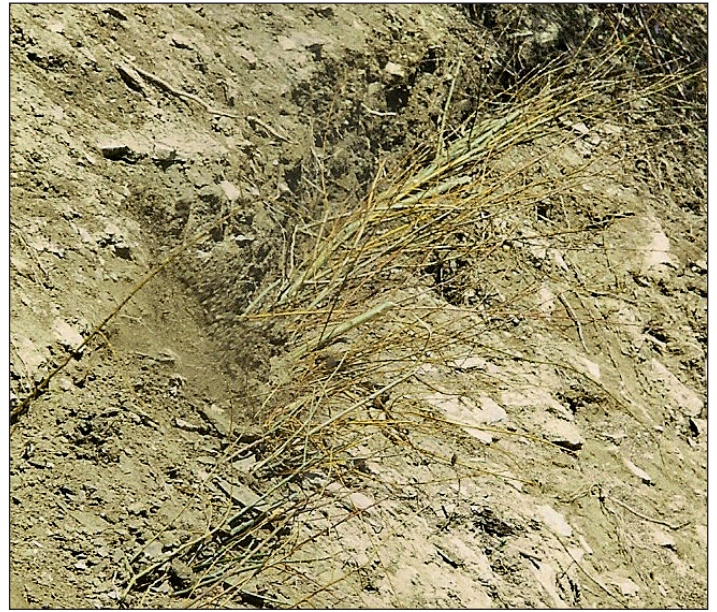
Abbildung 3: Beispiel 1. Oberflächenstabilisierung Heidenweidli, Simmentalstrasse: Einbau von Pickelrillen auf roher Oberfläche – Gesamtansicht (links) und Detail der Weidenstecklinge (rechts).
