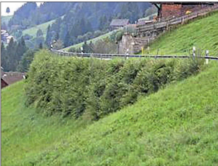
Abbildung 12: Beispiel 6. Geotextilwand Niedermatt Eriz (links): Die abgesackte und nachträglich stabilisierte Wand im rechten Bildteil ist nicht ersichtlich; das heisst: das ingenieurbioologische Stützbauwerk hat eine Sackung schadlos überstanden. Rechts: Schema der Sackungs-Instandstellung. Figure 12: Exemple 6. Paroi en géotextile à Niedermatt Eriz (à gauche): La paroi affaissée et stabilisée ultérieurement à droite de l'image n'est pas visible; cela signifie que la structure de soutènement en génie biologique a survécu sans dommage à un tassement. A droite: schéma de la remise en état du tassement.
