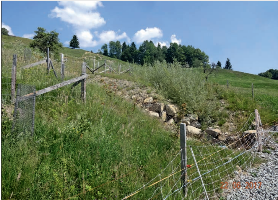
Abbildung 2: Entwässerungsgraben mit Steinsohle und ausgeschlagenen Lebendfaschinen im Gebiet Hintergraben, Sarnen (Foto: M. Hintermann).
