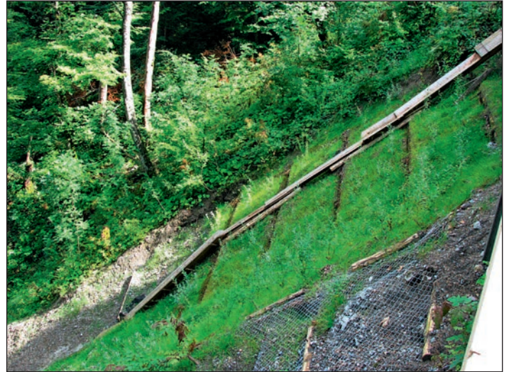
Abbildung 6: Mullernstrasse: Begrünter Hangrost ein Jahr nach Bauvollendung. Die Trockensaat ist gut angewachsen und die Weidensteckhölzer haben Triebe von ca. 0.5 – 1.0 Metern gebildet.
