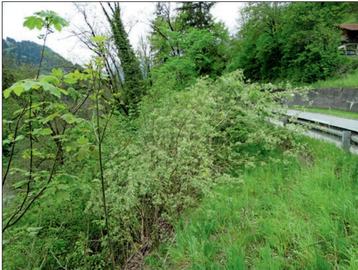
Abbildung 9: Beispiel 4. Heutiger Zustand im Friberig: Die Weiden sind noch recht dominant (links), die Holzkasten erfüllen ihre Funktion der tiefgreifenden Stabilisation (rechts).
