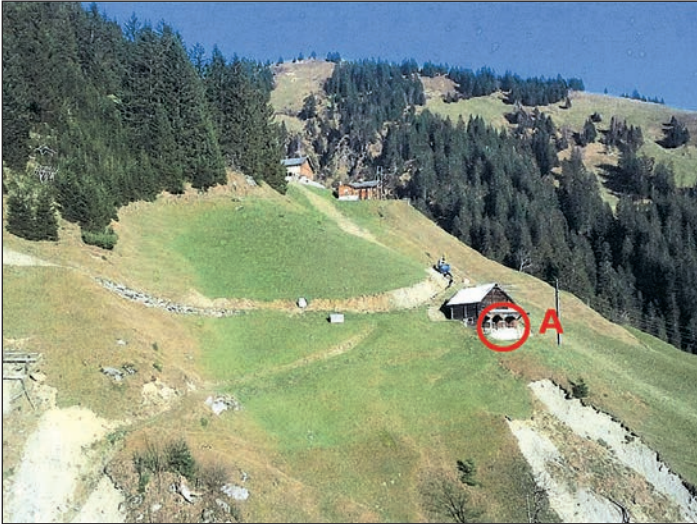
Abbildung 1: Der Rutschhang nach den Unwettern von 2005 und 2006. Figure 1: Pente en glissement après les intempéries de 2005 et 2006.
