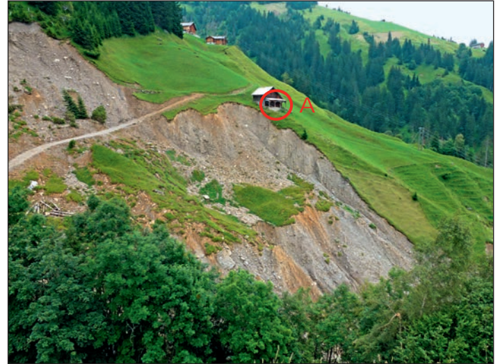
Abbildung 2: Rutschung nach dem Unwetter von 2013. Der landwirtschaftliche Güterweg wurde provisorisch instand gestellt. Figure 2: Glissement de terrain après les intempéries de 2013. Le chemin de service agricole a été temporairement réparé.
