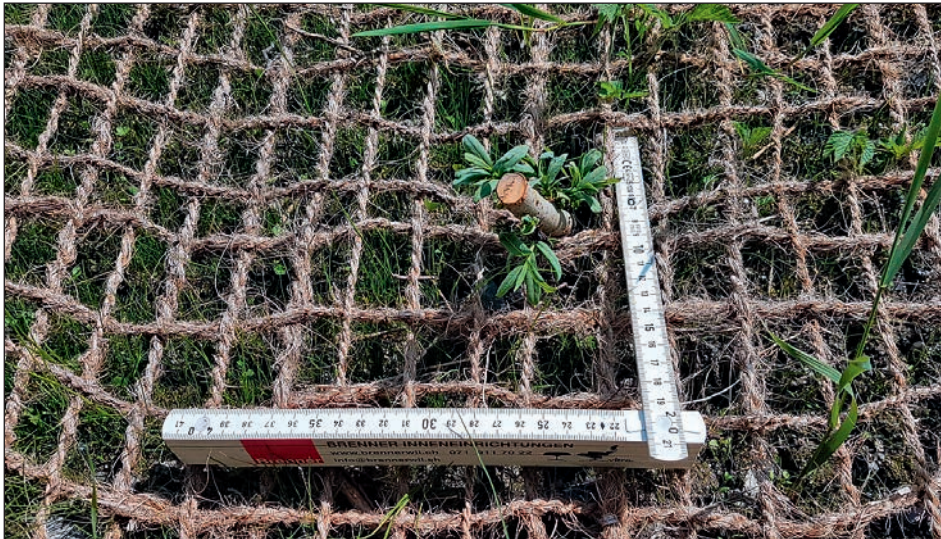
Abbildung 13: Anwuchs nach einem Monat (Ende Mai 2017). Die Weidensteckhölzer haben neue Triebe gebildet und die frische Ansaat ist zwischen den Maschen des Jutegewebes ebenfalls sichtbar. Figure 13: Jeunes pousses après un mois (fin mai 2017). Les boutures de saule ont formé de nouvelles pousses et les semis sont également visibles entre les mailles de la toile de jute.
