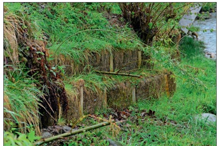
Abbildung 4: Faschinen aus Holzwolle haben sich bei der Ufersicherung gut bewährt.
