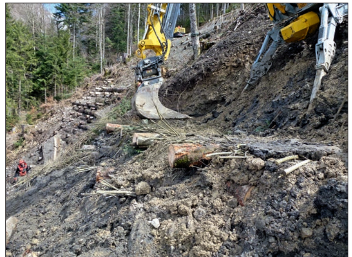
Abbildung 6: Einbau von Weidenbuschlagen in Holzkasten für die Entwässerung und Begrünung (April 2013).
