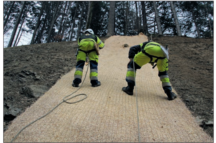
Abbildung 2: Zwei Arbeiter befestigen an einem steilen Hang in Wattwil Holzwollevliese, um eine schnelle Begrünung zu ermöglichen.
