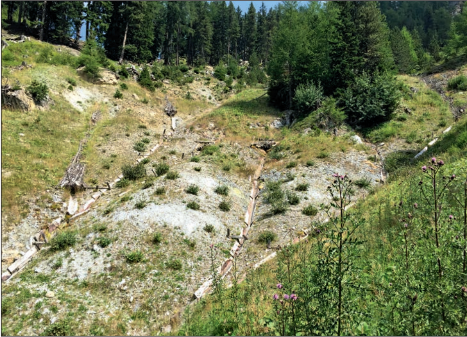
Abbildung 3: Baumfaschinen und Kännel leiten das Wasser ab (Val Schais, Sta. Maria. Foto: fobatec). Figure 3: Des fascines et des canaux évacuent l'eau (Val Schais, Sta Maria. Photo: fobatec).
