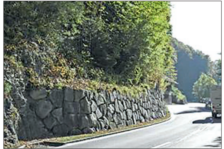
Abbildung 13: Beispiel 7. Stützmauer Staldi, Haslibergstrasse: Bruchsteinmauerwerk reduziert auf minimal notwendige Partien zugunsten des Landschaftsbildes. Figure 13: Exemple 7. Mur de soutènement à Staldi, Haslibergstrasse: le mur de moellons réduit au minimum les parties nécessaires en faveur du paysage.
