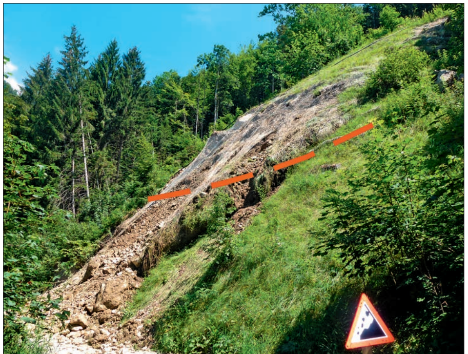
Abbildung 4: Der verschüttete untere Strassenabschnitt nach der Absackung im Juli 2012. Im 2009 als Provisorium eingebauten verankerten Drahtnetz ist oberflächliches Rutschmaterial aufgestaucht und teilweise ausgebrochen. Die Gleiffläche verläuft im Bereich der roten Linie (Foto: GEOTEST AG). Figure 4: La partie inférieure enfouie de la route après l'affaissement en juillet 2012. En 2009, le treillis métallique ancré de manière provisoire a été comblé par des matériaux de glissement en surface et a été partiellement brisé. Les surfaces de glissement se prolongent dans la zone de la ligne rouge (photo: GEOTEST AG).
