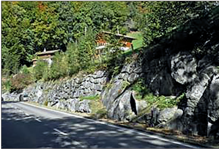
Abbildung 13: Beispiel 7. Stützmauer Staldi, Haslibergstrasse: Bruchsteinmauerwerk reduziert auf minimal notwendige Partien zugunsten des Landschaftsbildes. Figure 13: Exemple 7. Mur de soutènement à Staldi, Haslibergstrasse: le mur de moellons réduit au minimum les parties nécessaires en faveur du paysage.
