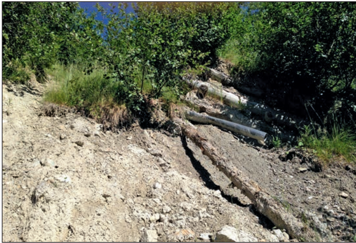
Abbildung 4: Überreste eines abgescherten Holzkastens und der Rohrentwässerung innerhalb des Kastens. Der linksseitige Teil des Kastens ist « verschwunden ». Foto Hansjörg Weber, Juli 2014.
