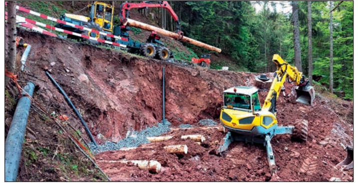
Abbildung 8: Fliessenstrasse: Einbau des oberen Holzkastens. Gut sichtbar an der hinteren Wand sind die Entwässerungsleitungen.
