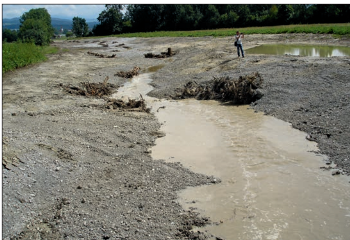
Abb. 4: 8. August 2014: Unmittelbar nach der Umleitung fliesst der Schwarzbach (noch als braune Brühe) in Richtung Giesse. Gut erkennbar sind die zahlreichen Wurzelstöcke direkt am Gewässerrand. Die Uferbestockung fehlt noch.
