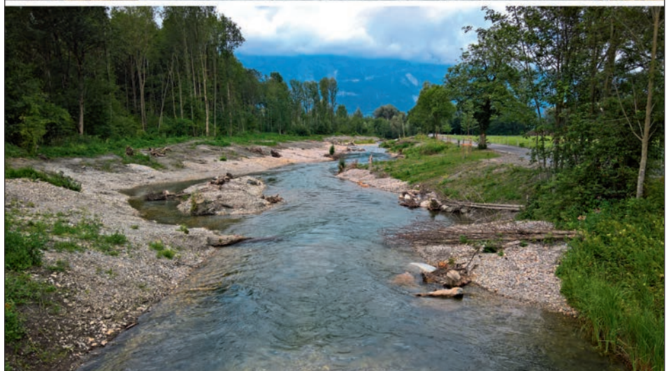
Abb. 4: Neues Gerinne im untersten Abschnitt zu Beginn (oben) sowie nach Abschluss (unten) der Bauarbeiten (Quelle: Amt für Wasser und Energie, St.Gallen) Fig. 4: Nouveau lit dans la partie inférieure au début (en haut) et après (en haut) les travaux (source: Office de l'eau et de l'énergie, St.Gallen)
