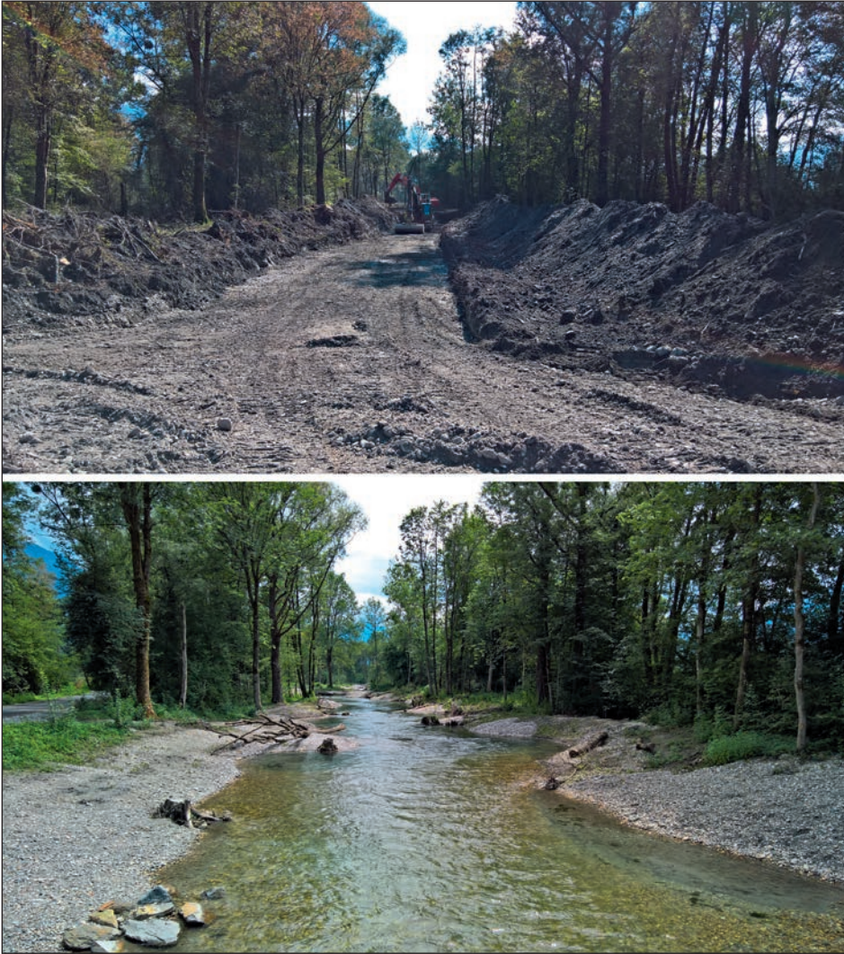
Abb. 5: Neues Gerinne im Bereich der Verlegungsstrecke zu Beginn (oben) sowie nach Abschluss (unten) der Bauarbeiten (Quelle: Amt für Wasser und Energie, St.Gallen)
