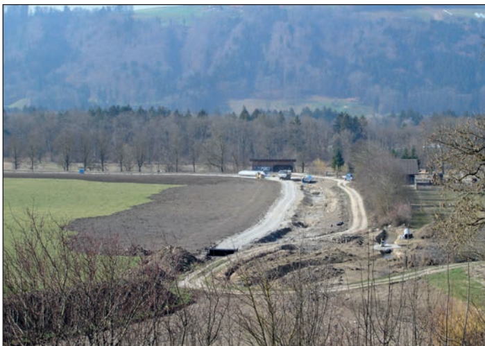
Abb. 2: 13. März 2014: Überblick auf den Schwandbach vom Bahndamm aus. Der grösste Teil des Humus ist bereits verteilt. Die bereits vormontierten Bachdurchlässe aus Wellstahl sind ebenfalls erkennbar.
