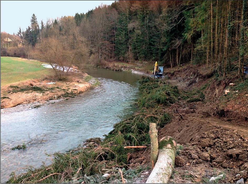
Abbildung 2: Die Bäume werden flussaufwärts eingebaut.
