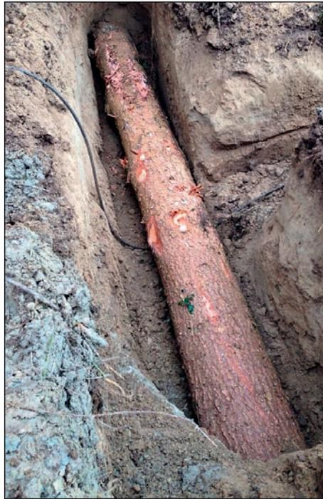
Abbildung 5: Totmannanker (Erdanker) zur Befestigung der Wuhrbäume.
