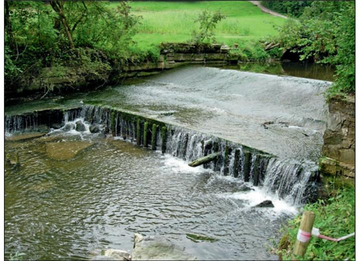
Abbildung 2: Oberes Stauwehr Isenhammer: Ein Betonwehr von 1,8 m Höhe verhindert seit etwa 150 Jahren die Wanderung von Fischen flussaufwärts.
