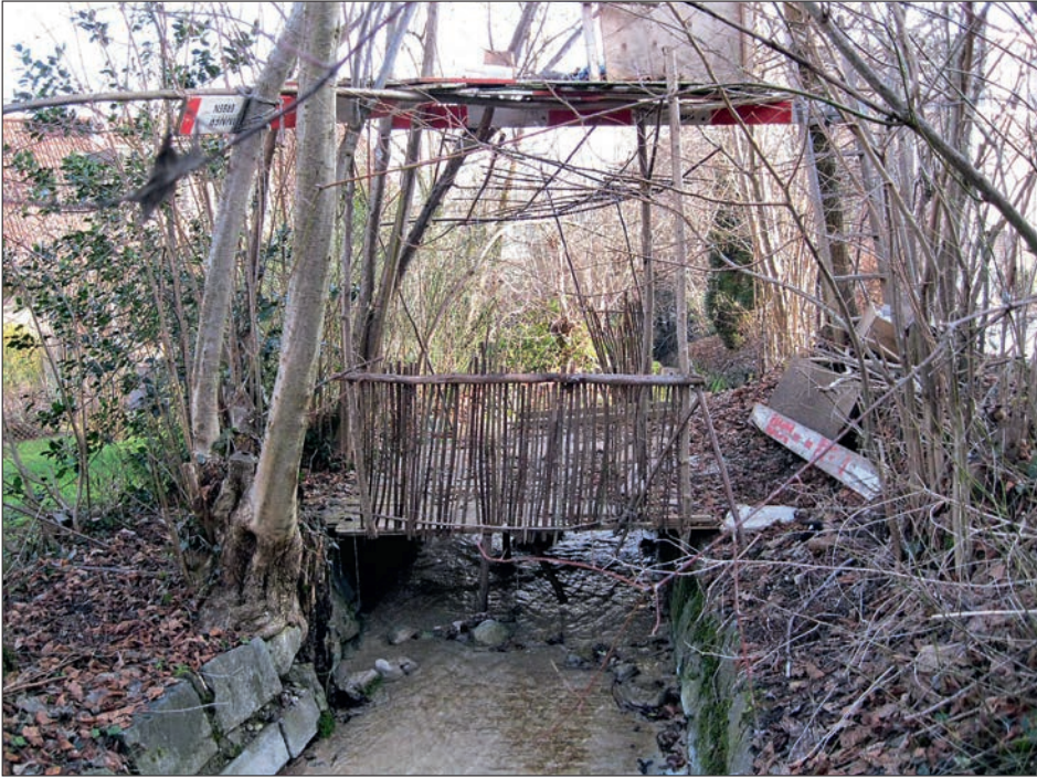
Abb. 8: «Private Verbauungen» an Gewässern sind häufig anzutreffen und werden vom Bachwart entfernt. (Foto: U. Loritz)
