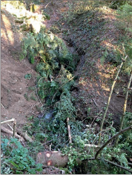
Abb. 4: Rauhbaum im Zwiselbach. [Foto 4: U. Harder, AfU] Fig. 4: Arbre en épi dans le Zwiselbach.
