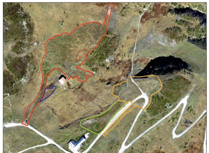
Abb. 5: Ein Jahr nach dem Bau der Pistenkorrektur Reinalter und zwei Jahre nach dem Bau der Pistenkorrektur Rominger. Orange: Pistenkorrektur Rominger. Grün: Materialzwischenlager. Blau: Umgesiedeltes Moor. Rot: Pistenkorrektur Reinalter mit Baustellenzufahrt (Luftbild: Geogrischa, 2015).
