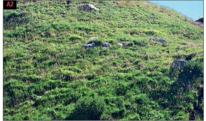
Abb. 11: In der steilen Böschung der Untersuchungsfläche A2 sind die Ziegel fest verankert. Die in den Boden eingelagerten Blockschuttfelsen verleihen der Begrünung zusätzliche Stabilität. Fig. 11: Dans la forte pente de la zone d'expérimentation A2, les mottes sont bien ancrées. Les roches d'éboulis entreposés offrent une stabilité supplémentaire pour la végétalisation.
