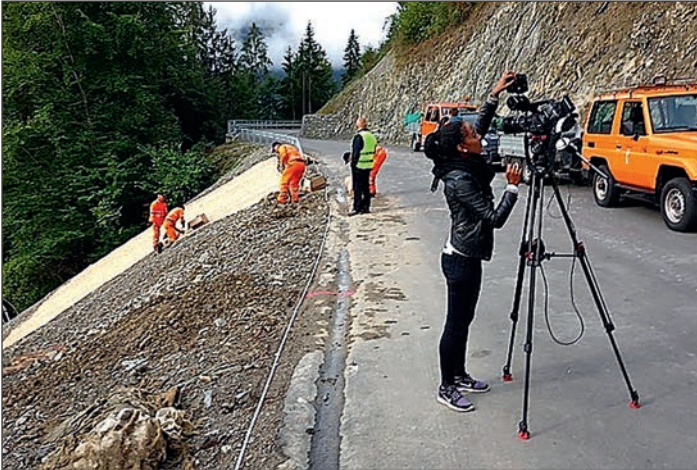
Abb. 3: Anlage von KTI-Versuchsflächen zur Optimierung des Erosionsschutzes unter erschwerten Bedingungen.
