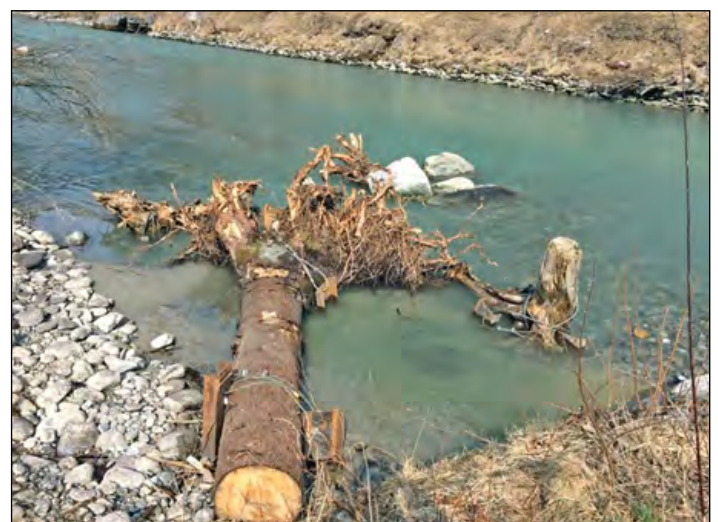
Abbildung 5: massiv mit Stahlseilen und gerammten Stahlprofilen gesicherter Stamm, Foto: K. Inäbnit, KWO. Fig. 5: Tronc consolidé avec des câbles d'acier massifs et des profils en acier. Photo: K. Inäbnit, KWO.
