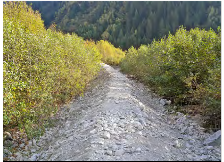
Bild 3: Geschiebedotierung 2009. Links: Laster bringt Geschiebe unterhalb des heutigen Geschiebesammlers ein, rechts: Mit Geschiebe dotierte Sohle des Gadmerwassers direkt unterhalb des Geschiebesammlers – bereits einen Monat später hat ein kleineres Hochwasser das deponierte Material vollständig abgetragen.
