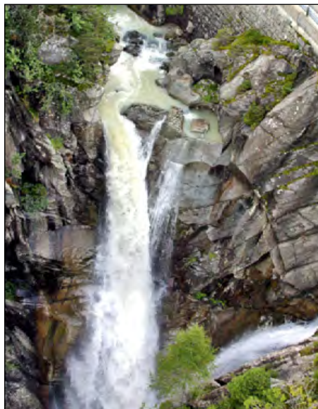
Bild 7: Handeckfall – oben: ohne zusätzliche Dotierung vom Räterichsbodensee, unten: mit Dotierung (500 l/s) von trübem Wasser aus dem Räterichsbodensee (Herbst 2008).
