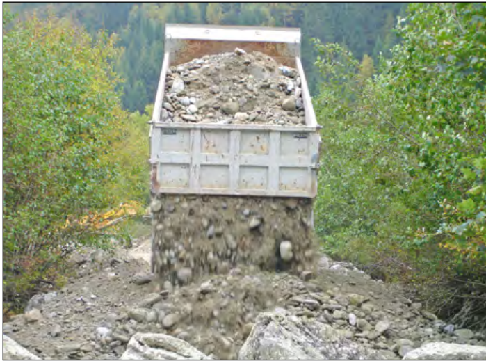
Bild 3: Geschiebedotierung 2009. Links: Laster bringt Geschiebe unterhalb des heutigen Geschiebesammlers ein, rechts: Mit Geschiebe dotierte Sohle des Gadmerwassers direkt unterhalb des Geschiebesammlers – bereits einen Monat später hat ein kleineres Hochwasser das deponierte Material vollständig abgetragen.
