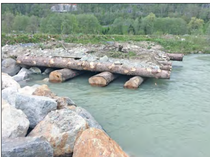
Abbildung 4 Erstmals nach dem Bau teilweise gefluteter Holzkasten, Foto: K. Inäbnit, KWO. Fig. 4: Caisse en bois partiellement inondée pour la première fois. Photo: K. Inäbnit, KWO.
