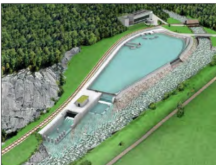
Bild 7: Illustration des künftigen Beruhigungsbeckens in Innertkirchen. Fig. 7: Illustration du futur bassin d'amortissement à Innertkirchen.
