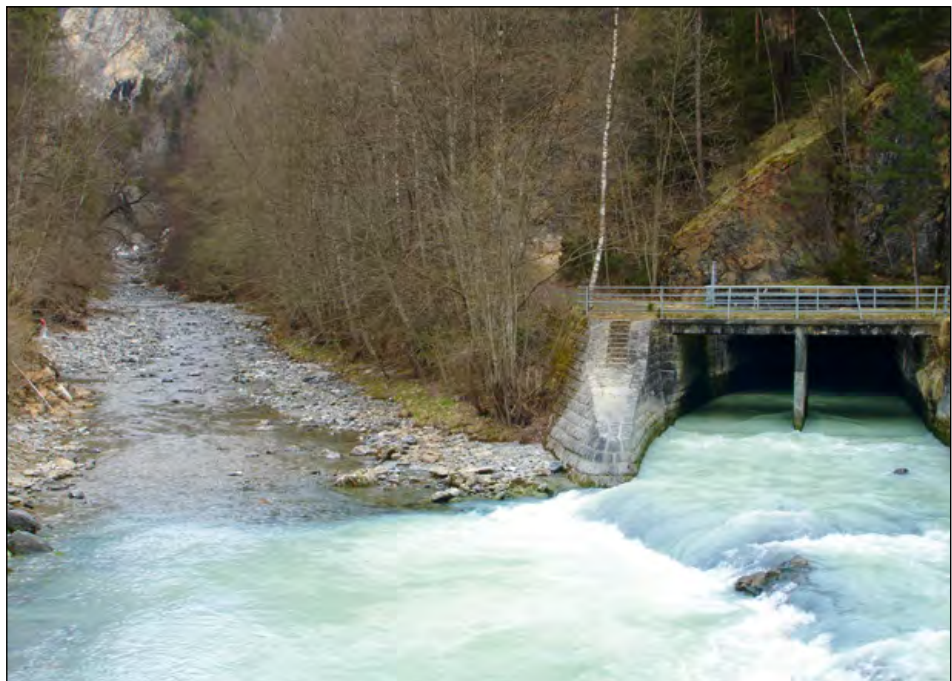
Bild 3: Unteres Gadmerwasser bei der Wasserrückgabe vom Kraftwerk Innertkirchen 1. Mit der künftigen Verlegung der Wasserrückgabe (unter dem Gadmerwasser hindurch) und einer weiteren Erhöhung der Restwassermenge steht dieser Gewässerabschnitt (links im Bild) künftig als Laichstrecke für die Seeforelle wieder zur Verfügung.
