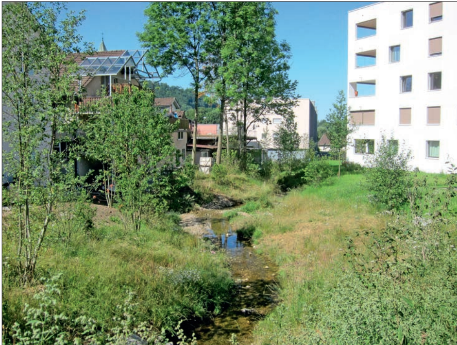
Abb. 7: Im Jahr 2012 hochwassersicher ausgebauter und gleichzeitig revitalisierter Schlipfbach in Wald, Kanton Zürich. Das Beispiel zeigt, dass auch im Siedlungsraum durch revitalisierte Bäche ein Mehrwert für die Ökologie und Erholung geschaffen werden kann.
