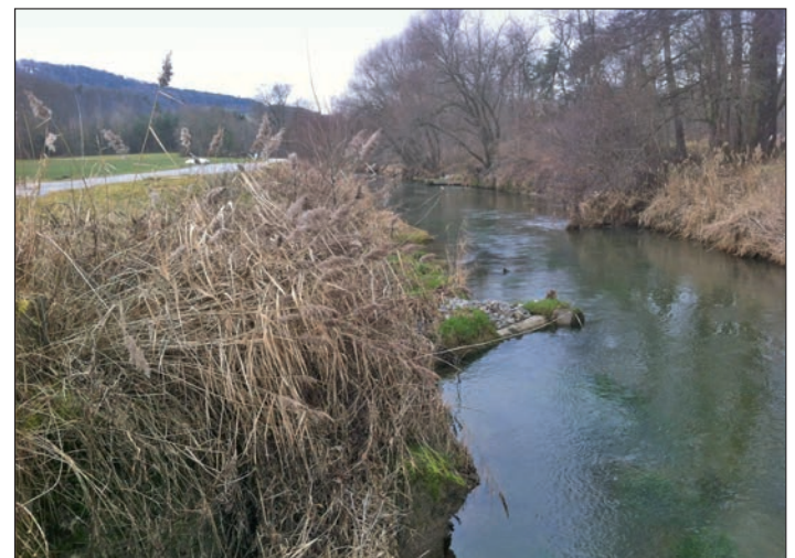
Abb. 7: Punktuelle Erosionssicherung. Fig. 7: mesures ponctuelles de lutte contre l'érosion.
