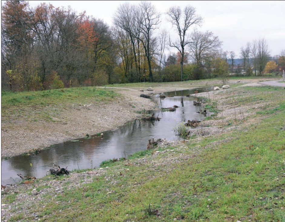
Abb. 3: Gewässer direkt nach dem baulichen Eingriff zur Renaturierung. Fig. 3: Cours d'eau directement après l'intervention technique visant à la revitalisation.
