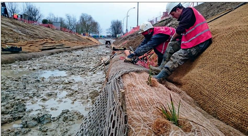
Fig. 8 : Installation d'un filet anti-érosion de berges en polyéthylène associé à des éléments naturels – Vallée de la Bièvre.
