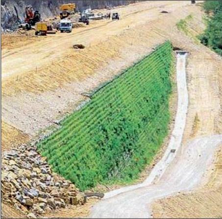
Fig. 1 : Végétalisation de talus routier à l'aide d'un géofilet associant fibres synthétiques et naturelles.
