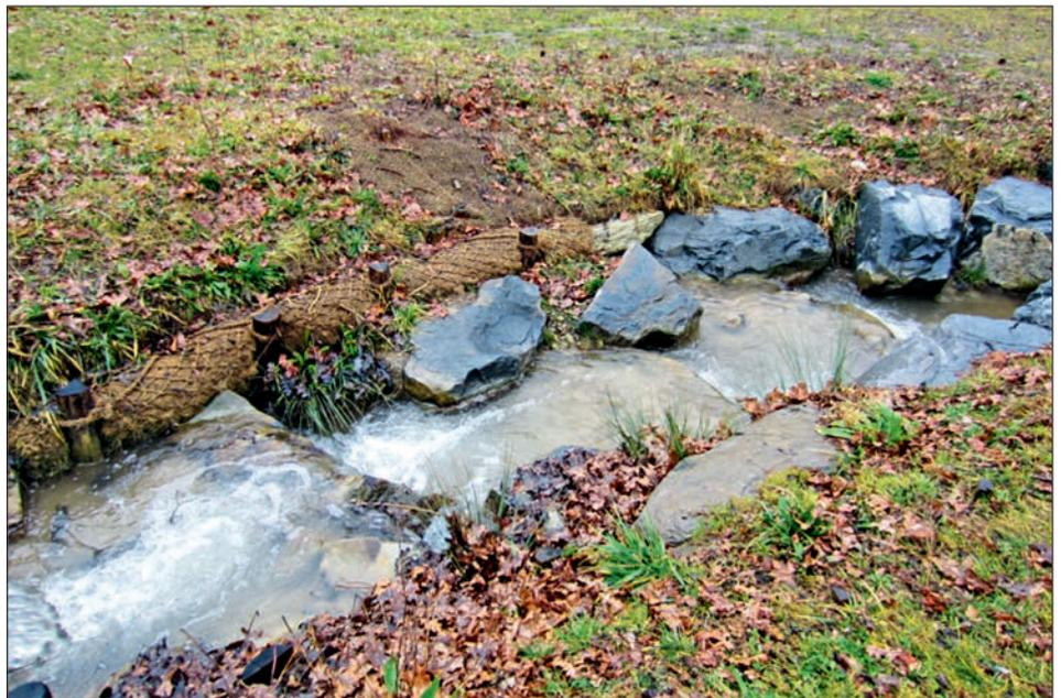
Figure 1 : Aménagement de génie végétal associant seuils, géofilet biodégradable et végétaux.
