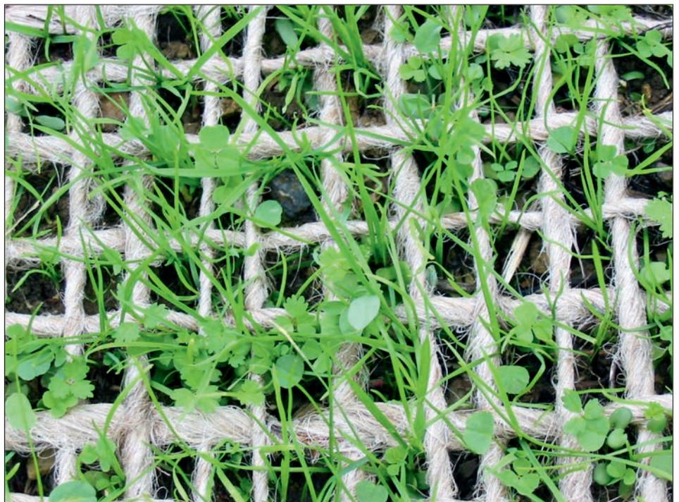
Après germination des semences, le couvert végétal s'implante progressivement, aidé par la présence d'un géofilet biodégradable fixé au sol.
