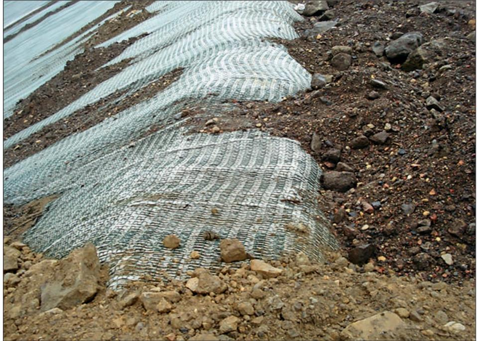
Fig. 2 : Dispositif de protection et accroche-terre sur grande pente (couverture d'un centre de stockage de déchets).
