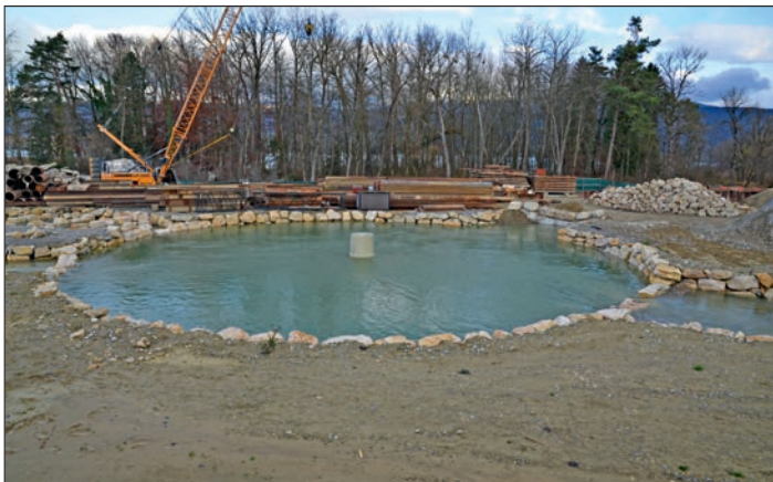
Abb. 6: Verteilbecken d = 23 m (Stand Dezember 2014) (Foto: BKW)
