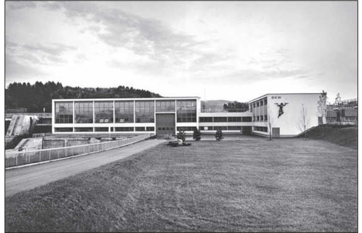
Abb. 10: Gesamtansicht mit Reliefplastik von Bildhauer W. Schnegg, Bern, aus dem Jahre 1969 (von links nach rechts: Wehr, Maschinenhaus, Werkstatt, Relaisgebäude) (Foto: BKW) Fig. 10: Vue d'ensemble avec la sculpture en relief du sculpteur W. Schnegg, à Berne, depuis 1969 (de gauche à droite: le barrage, la salle des machines, l'atelier, le bâtiment de relais) (photo: BKW)
