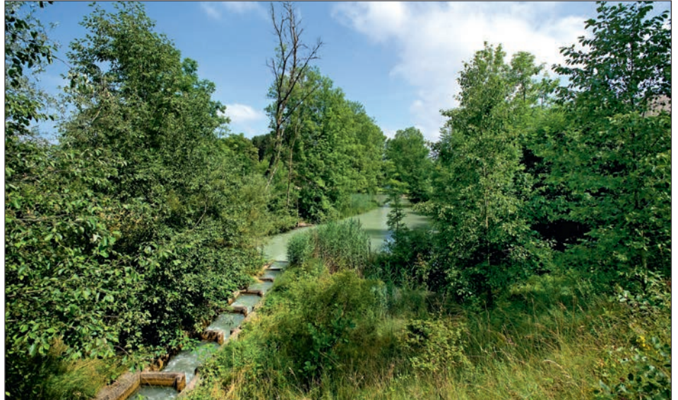
Abb. 13: Bibergängiger Fischpass ab der Alten Aare (Foto: BKW) Fig. 13: Passe à poissons accessible aux castors depuis la Vieille Aar (photo: BKW)
