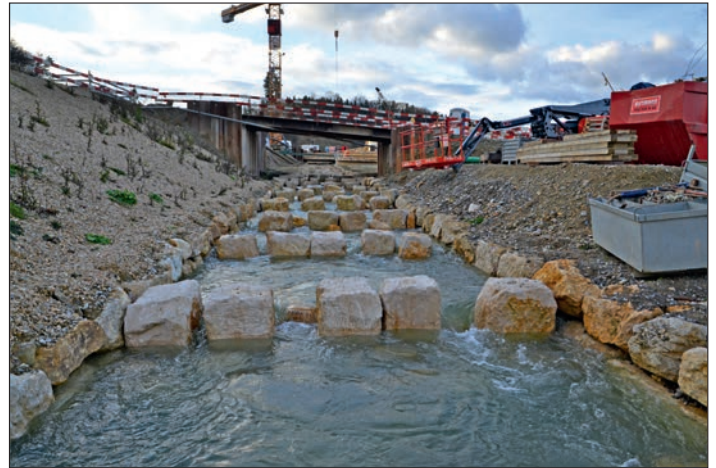
Abb. 5: Umgehungsgerinne kurz nach Inbetriebnahme im Dezember 2014 (Foto: BKW)
