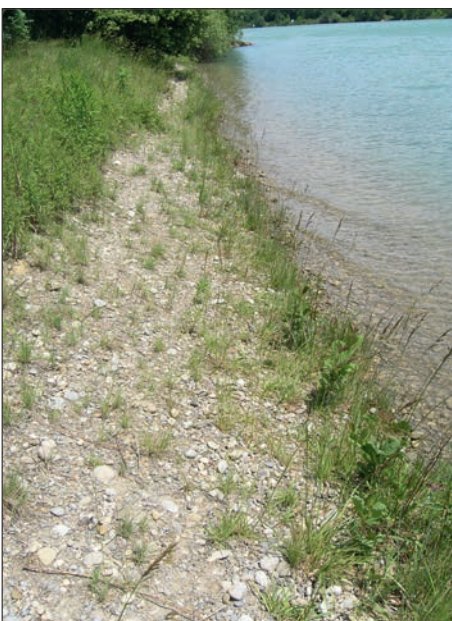
Abb. 13: Kiesschüttung auf Dammböschung (Foto: F. Leiser) Fig. 13: Remblais en gravier sur le talus de la digue (photo: F. Leiser)
