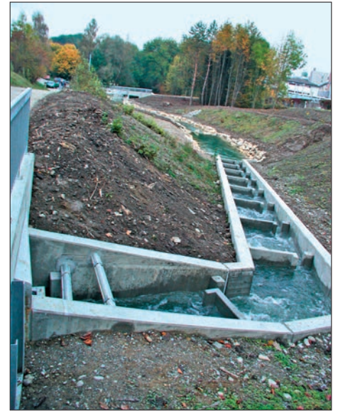
Abb. 2: Fischpass nach Bauabschluss 2002 (Foto: P. Hässig)
