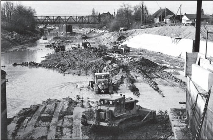
Abb. 9: Unterwasserausbaggerung mit trockengelegter Aare (Foto: BKW) Fig. 9: Dragage des eaux souterraines avec l'Aar asséchée (photo: BKW)
