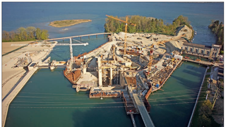
Abb. 11: Sicht auf Baustelle (Stand April 2014) (Foto: BKW)
