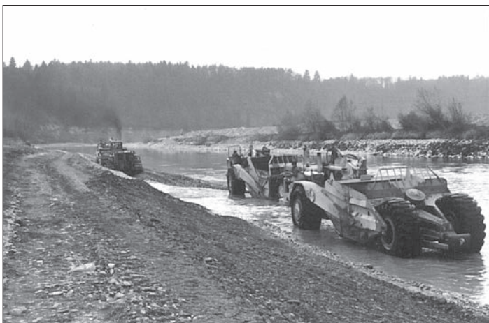
Abb. 7: Kanalisierung der Aare mit schwerem Gerät im ehemaligen Auengebiet (Foto: BKW) Fig. 7: Canalisation de l'Aar à l'aide d'engins lourds dans l'ancienne zone alluviale (photo: BKW)
