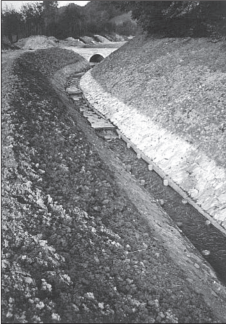
Abb. 12: Umlegung Salzbach 1967, heute Renaturierungsprojekt des BKW Ökofonds (Foto: BKW) Fig. 12: Transfert du ruisseau Salzbach en 1967, aujourd'hui un projet de renaturation du fonds écologique des BKW/BKW (photo: BKW)
