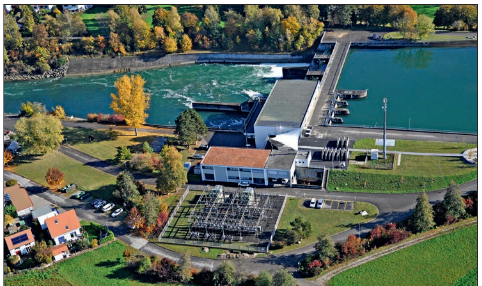
Abb. 1: Gesamtübersicht Kraftwerk Aarberg (Foto: BKW)
