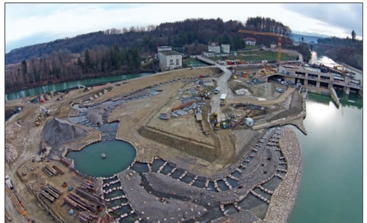
Abb. 7: Sicht auf Umgehungsgerinne (Drohnenaufnahme vom Januar 2015) (Quelle: Geoplanteam, Nidau)
