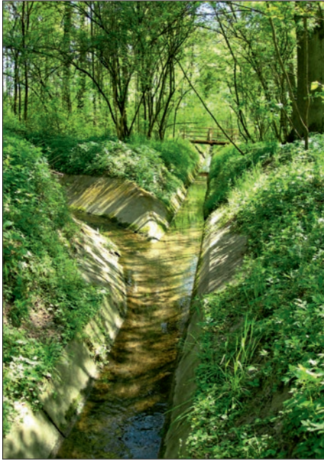
Abb. 7: Gummenbach in Betonhalbschale (Foto: F. Leiser) Fig. 7: Le ruisseau de Gummen dans son lit de béton en demi-coque (photo: F. Leiser)
