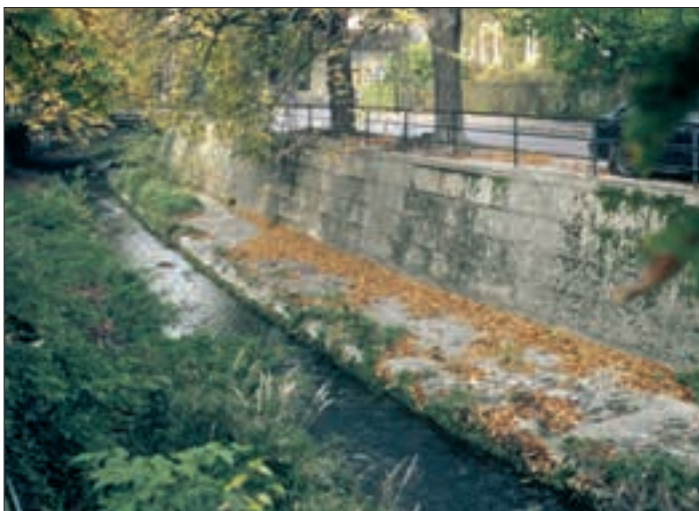
Abb. 15: Detail der betonierten Niederwasserrinne und des angrenzenden Bruchsteinmauerwerks im Bereich Bachgasse, Herbst 2005. Fig. 15: Détail du lit d'étiage en béton et du mur en pierres sèches dans le secteur de la Bachgasse, en automne 2005.
