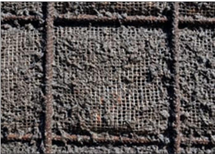
Abb. 5: Detail der Bewehrte-Erde-Konstruktion unmittelbar nach der Begrünung. Fig. 5: Détail de la structure de terre renforcée immédiatement après la plantation.
