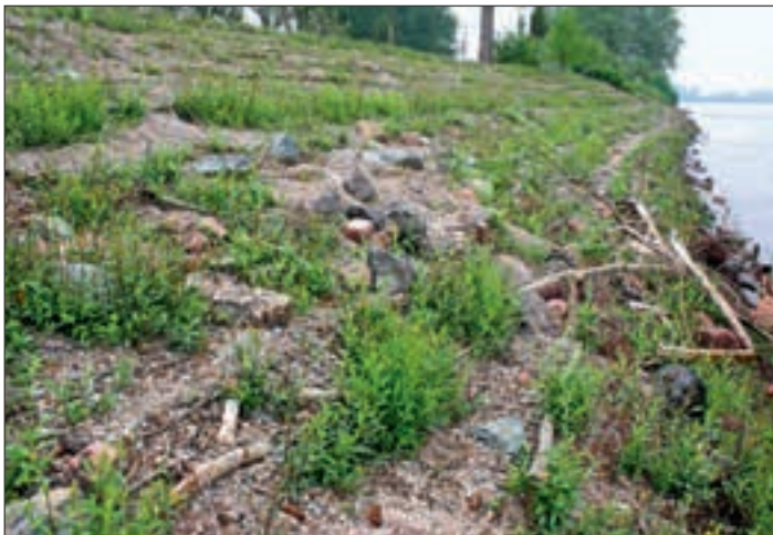
Abb. 3: Weidenspreitlage quer (Versuchsstrecke am Rhein bei Worms, 02.05.2012).
