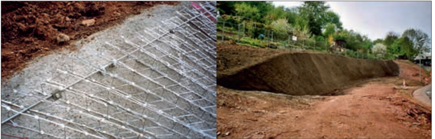
Abb. 5: Verlegte Gitterpaneele des 3-D-Stahlgitters mit Befestigung (links) und bereits mit Bodenmaterial verfüllter Aufbau (rechts) (Quelle: Fa. KRISMER, 2010). Fig. 5: Panneaux décalés de treillis d'acier 3D avec fixation (à gauche) et structure du sol déjà remplies (à droite) (source: Fa. Krismer, 2010).
