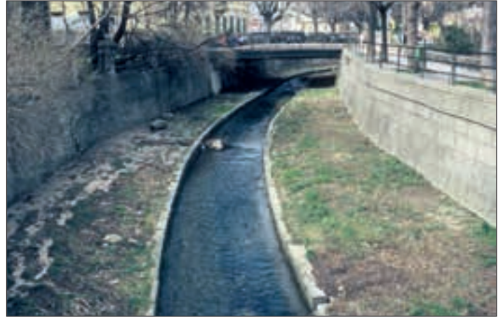
Abb. 6: Der hart verbaute Mödlingbach vor den Revitalisierungsarbeiten im Bereich Viechtelgasse, 2004. Fig. 6: Le Mödlingbach aménagé en dur avant les travaux de revitalisation dans le secteur de la Viechtelgasse en 2004.
