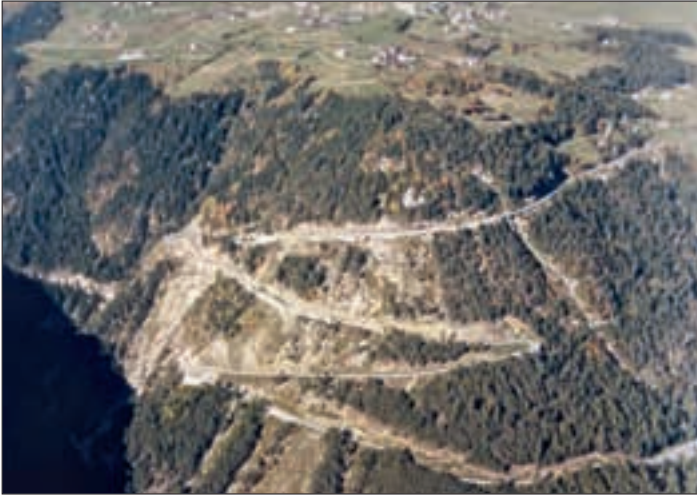
Abb. 3: Der wenig landschaftsschonende Bau der Strasse Mühlbach-Meransen, Südtirol, hat grosse Wunden hinterlassen und bedingte grosse Anstrengungen für die Begrünung und Bepflanzung der offenen Stellen.
