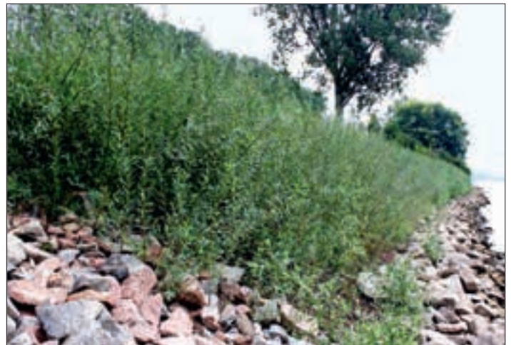
Abb. 4: Weidenspreitlage quer (Versuchsstrecke am Rhein bei Worms, 11.09.2012).
