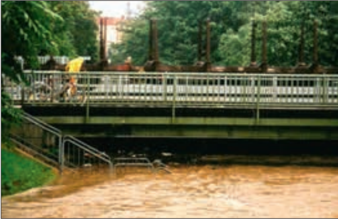
Abb. 5: 30-jährliches Hochwasser ( 29,5 \text{ m}^3/\text{s} ) am Mödlingbach unterhalb der Bahnbrücke, Juli 1997. Fig. 5: Crue trentennale ( 29,5 \text{ m}^3/\text{s} ) du Mödlingbach sous le pont de chemin de fer en juillet 1997.
