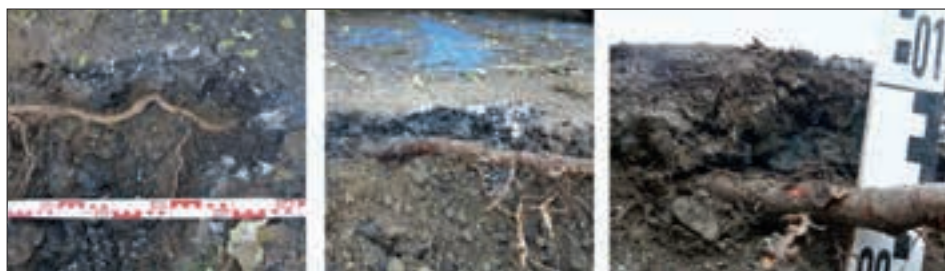
Abb. 6: Einwüchse der zum Schaden führenden Gehölzwurzeln zwischen Asphaltdeckschicht und oberer Tragschicht. Fig. 6: Croissance des végétaux ligneux menant à des dommages entre la surface de l'asphalte et la couche portante supérieure.
