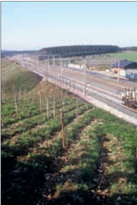
Abb. 5: Eine Riefenpflanzung an der neuen ICE-Strecke Würzburg-Kassel, Deutschland.
