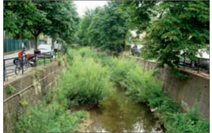
Abb. 18: Dieselbe Stelle nach 1 Jahr, Sommer 2008. Fig. 18: Même endroit 1 année après, en été 2008.
