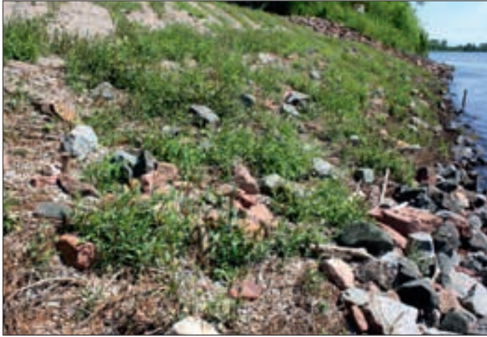
Abb. 1: Weidenspreitlage diagonal (Versuchsstrecke am Rhein bei Worms, 01.05.2012).
