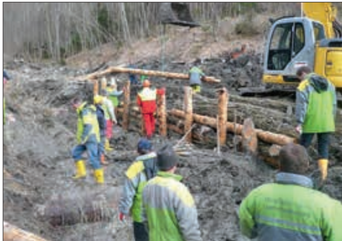
Abb. 6: Erstellung der Uferpfahlwand. Eigene Aufnahme. Fig. 6: Mise en place d'un mur pilot de rive vivant. Propre photographie.
