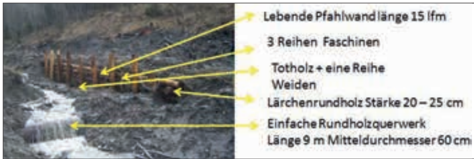
Abb. 5: Bauweise der lebenden Uferpfahlwand. Eigene Darstellung. Fig. 5: Construction d'un mur pilot de rive vivant. Propre représentation.
