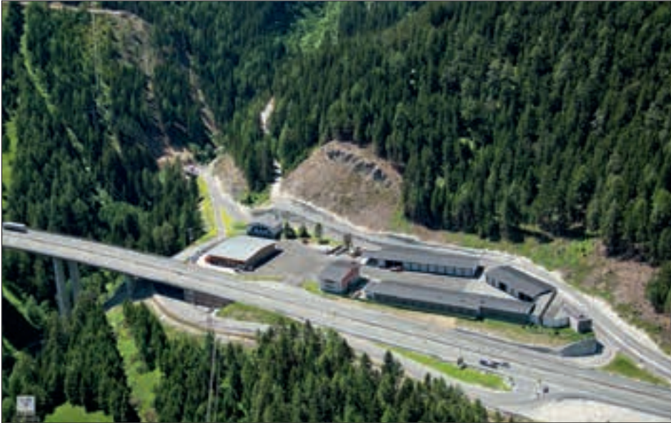
Abb. 2: Übersichtsfoto des Forschungsstandorts im Bereich Plon in Steinach am Brenner an der Brennerautobahn (Quelle: BBT-SE, 2011).
