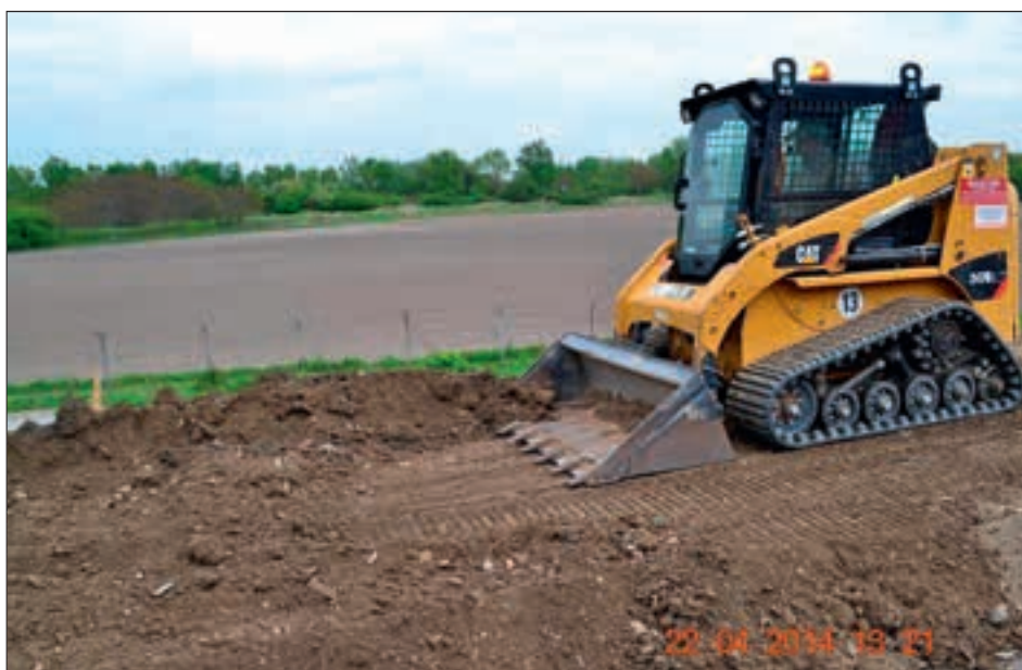
Abb. 8: Kettenbobcat zur Herstellung der Rekultivierungsschicht und «Asche-Schlacke-Betonkörper neu». Fig. 8: Bobcat chenillé pour la préparation de la couche de restauration et «nouveau remblai de cendre, de crasse et de béton».
