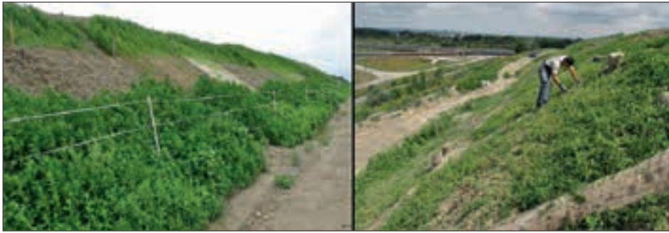
Abb. 3: Böschung am 21.6.2012 (links), im Bereich der Böschungsmitte (der Abschnitt mit 20% Kompost) kaum Vegetationsaufkommen. Böschung am 4.7.2012 (rechts) nach der Entfernung der nicht erwünschten Pflanzen, Deponie Rautenweg.
