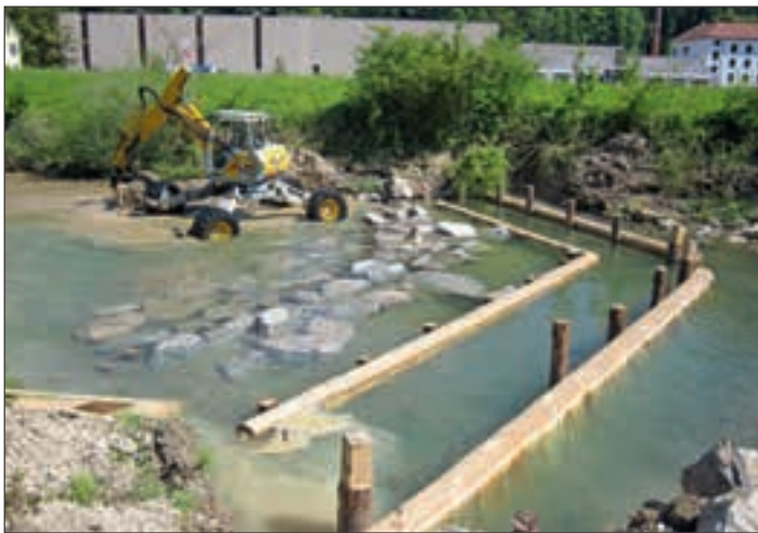
Abb. 4: Töss: Schwelle während Bau. Fig. 4: Töss: construction du seuil.
