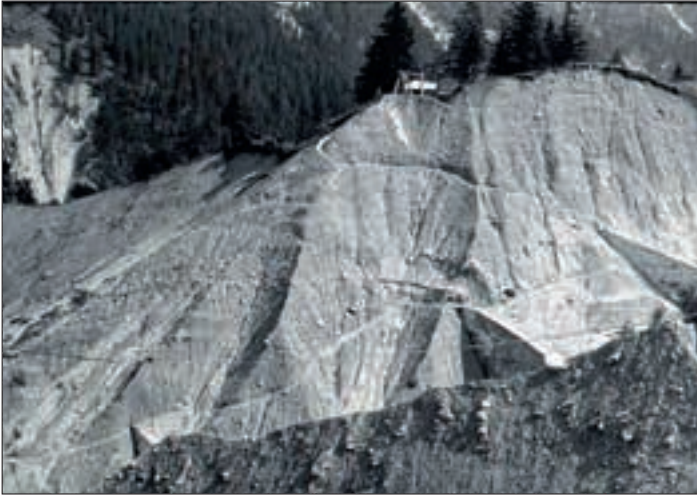
Abb. 8: Galina vor den Verbauungsmassnahmen. Fotoarchiv der WLW Vorarlberg. Fig. 8: La Galina avant les mesures d'aménagement. Archives du WLW Vorarlberg.
