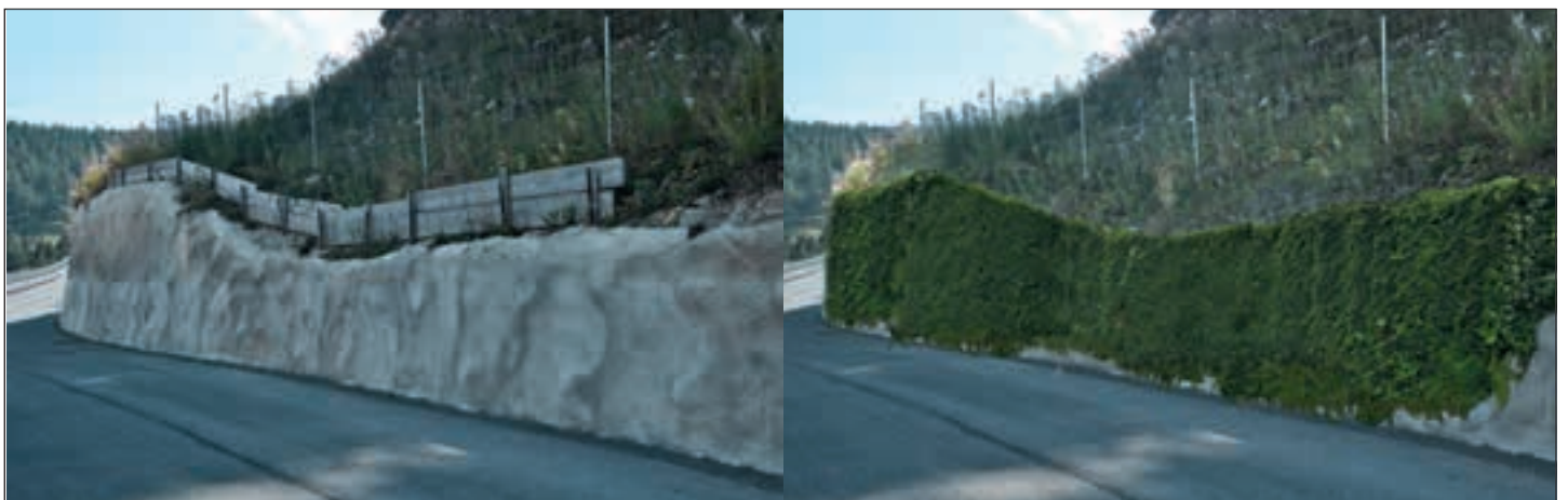
Abb. 7: Spritzbetonmauer im Ausgangszustand (links) und visualisiert nach einer Begrünung mit Kletterpflanzen (rechts) (Quelle: Florineth, 2013; bearbeitet durch: Medl, 2013). Fig. 7: Paroi en béton projeté à l'état initial (à gauche) et visualisée après la végétalisation avec plantes grimpantes (à droite) (source: Florineth, 2013; édité par: Medl, 2013).
