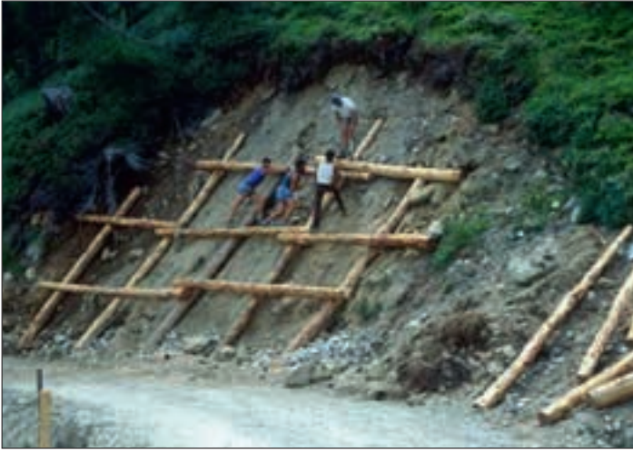
Abb. 6: Bau eines Hangrostes zur Sicherung der steilen bergseitigen Böschung am Almweg nach Oberplanegg, Südtirol. Fig. 6: Construction d'un treillis en bois pour la stabilisation d'une pente végétalisée à Almweg après Oberplanegg dans le Tyrol du Sud.
