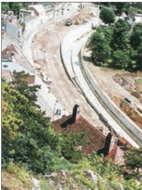
Abb. 4: Umbau der Brühlerstrasse oberhalb des Stadtgebietes mit der Verlegung und Betonierung des Mödlingbaches, 1975. Fig. 4: Transformation de la Brühlerstrasse en-dessus de la zone urbaine avec la pose et le bétonnage du Mödlingbach en 1975.
