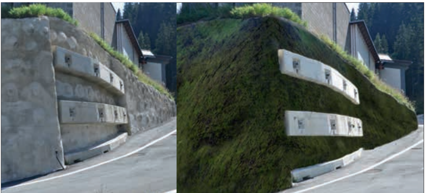
Abb. 6: Spritzbetonmauer im Ausgangszustand (links) und visualisiert nach einer Begrünung mit dem 3-D-Stahlgittersystem (rechts) (Quelle: Florineth, 2013; bearbeitet durch: Medl, 2013). Fig. 6: Paroi en béton projeté à l'état initial (à gauche) et visualisée après la végétalisation avec le système de grille en acier 3D (à droite) (source: Florineth, 2013; édité par: Medl, 2013).
