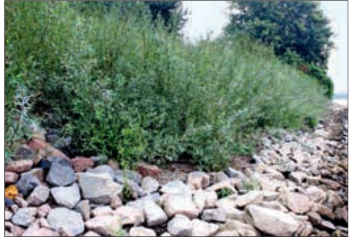
Abb. 2: Weidenspreitlage diagonal (Versuchsstrecke am Rhein bei Worms, 11.09.2012).
