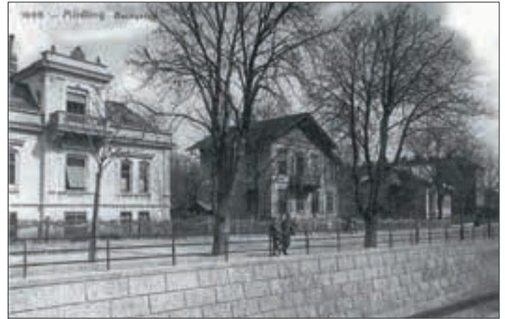
Abb. 3: Mödlingbach mit Uferschutzmauern und ausgebauter Bachsohle im Bereich Bachgasse, um 1911. Fig. 3: Le Mödlingbach avec des murs de rives et le lit du cours d'eau transformé dans le secteur Bachgasse vers 1911.
