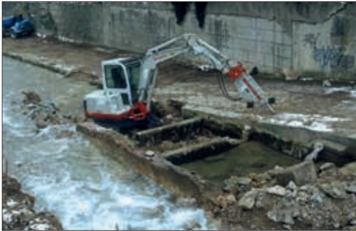
Abb. 11: Aufreissen der Fischtreppe und des angrenzenden Bruchsteinmauerwerks, Februar 2006. Fig. 11: Ouverture de l'échelle à poissons et du mur en pierres sèches adjacent en février 2006.
