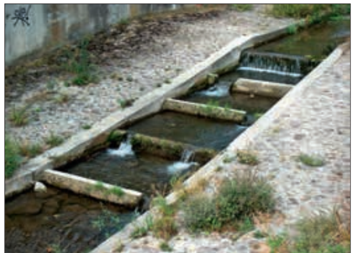
Abb. 10: Treppe für die nicht vorhandenen Fische zur Überbrückung einer Höhendifferenz von 1,20 m im Bereich Keimgasse, 2005. Fig. 10: Echelles pour les poissons non-présents afin de combler une différence de hauteur de 1,20 m dans le secteur de la Keimgasse en 2005.
