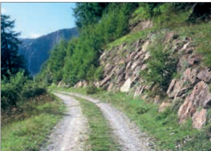
Abb. 16: Sicherung einer steilen bergseitigen Böschung des Zufahrtsweges zur Gadria/Schlanders, Südtirol, mit Blocksteinen aus der Umgebung, natürlicher Bewuchs und Hydrosaat nach 30 Jahren. Fig. 16: Consolidation d'une pente raide sur la route d'accès à Gadria/Silandro, Tyrol du Sud, avec des pierres en bloc de la région, une végétation naturelle et un ensemencement hydraulique 30 ans après.
