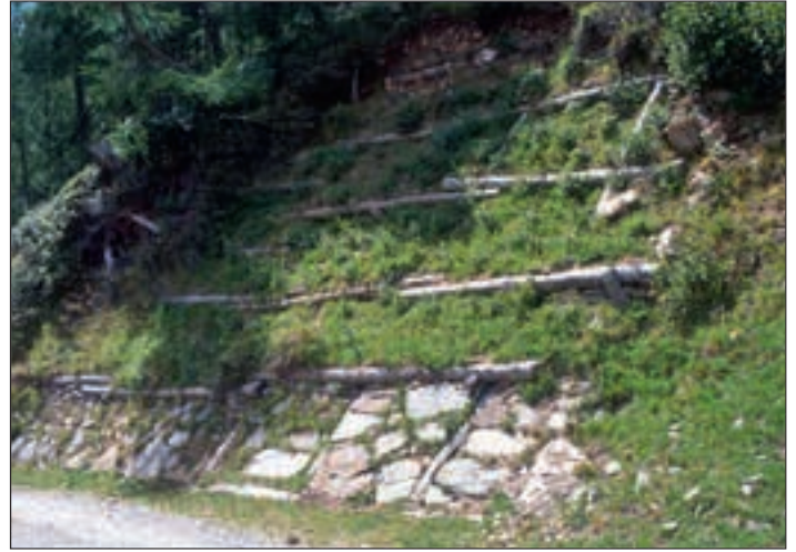
Abb. 7: Der bepflanzte Hangrost nach 3 Jahren. Fig. 7: Le treillis en bois végétalisé 3 ans après.
