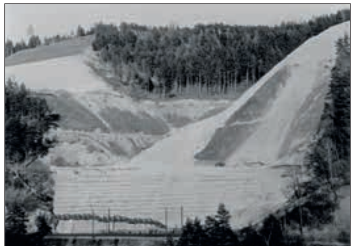
Abb. 11: Die Talschüttung und der Buschlagenbau soeben abgeschlossen, 1962 (Foto Schiechtl). Fig. 11: Le remblai de talus et le lit de plançons venant d'être terminés en 1962 (photo Schiechtl).
