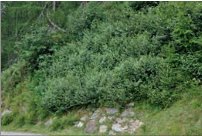
Abb. 8: Der bepflanzte Hangrost nach 19 Jahren. Fig. 8: Le treillis en bois végétalisé 19 ans après.
