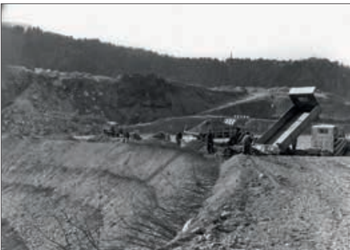
Abb. 10: Sicherung der Talschüttung für den Bau der Brennerautobahn am Ahrnberg durch Buschlagenbau, eine Pionierleistung von Hugo Meinhard Schiechtl, 1962 (Foto Schiechtl). Fig. 10: Consolidation du remblai pour la construction de l'autoroute du Brenner par la mise en place de lit de plançons à Ahrnberg, une œuvre pionnière par Hugo Meinhard Schiechtl en 1962 (photo Schiechtl).
