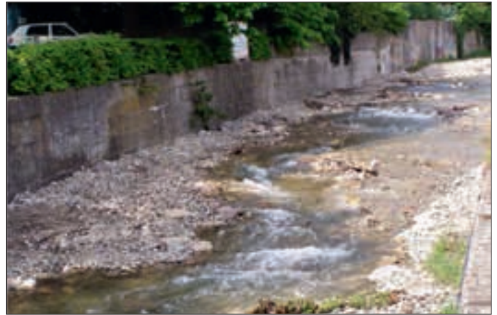
Abb. 12: Umgestaltung der Gefällstrecke mit einer Pendelrampe aus Blocksteinen und anschließender Holzpilotenreihe – das neue Gefälle beträgt 3%, März 2006. Fig. 12: Transformation de la pente avec une rampe pendulaire en pierres et avec une série de pilots en bois – la nouvelle inclinaison est de 3% en mars 2006.
