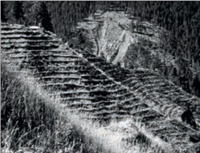
Abb. 10: Galina nach Fertigstellung der Bauwerke. Fotoarchiv der WLW Vorarlberg. Fig. 10: La Galina à la fin des travaux. Archives du WLW Vorarlberg.
