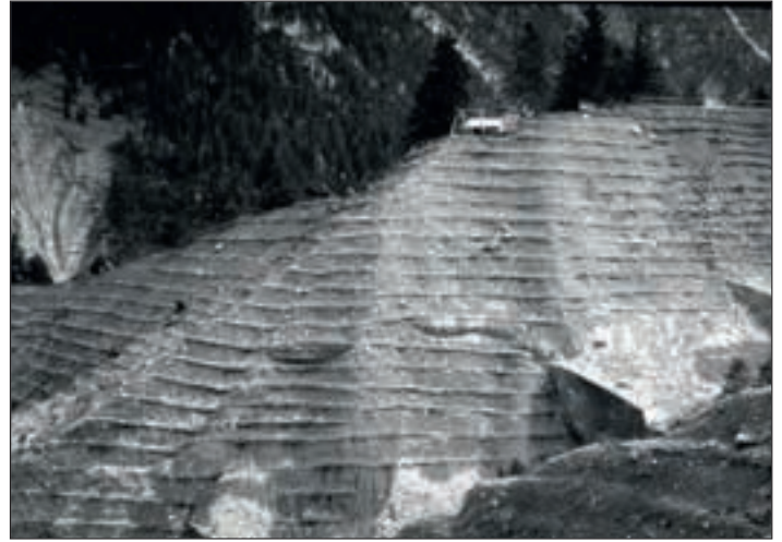
Abb. 9: Galina während der Umsetzung. Fotoarchiv der WLW Vorarlberg. Fig. 9: La Galina pendant les travaux. Archives du WLW Vorarlberg.
