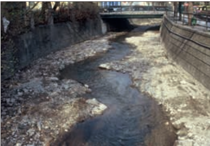
Abb. 7: Dieselbe Stelle nach dem Aufreißen der betonierten Sohle und Ufergestaltung, März 2005. Fig. 7: Même endroit après avoir enlevé le lit en béton et l'aménagement des berges en mars 2005.
