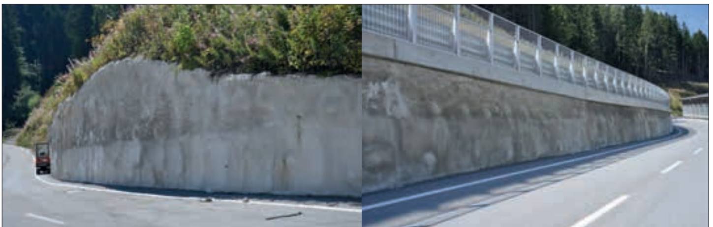
Abb. 1: Spritzbetonmauern am Forschungsstandort in Steinach am Brenner, Tirol (Quelle: Florineth, 2013).
