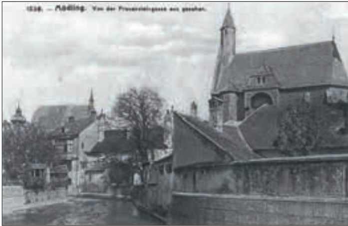
Abb. 2: Ausgebauter Mödlingbach mit Uferschutzmauern im Bereich Frauensteingasse, um 1909. Fig. 2: Le Mödlingbach modifié avec des murs de rive sur la Frauensteingasse vers 1909.
