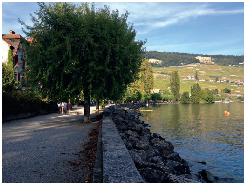
Figure 5. Photo d'une rive-type le long du lac (à Cully VD), la rive est réduite à un mur précédé d'enrochements (photo: Giovanni De Cesare). Abbildung 5. Foto einer typischen Küste am See entlang (in Cully VD), das Ufer reduziert sich zu einer Mauer, geschützt durch einen Blockwurf (Foto: Giovanni De Cesare).
