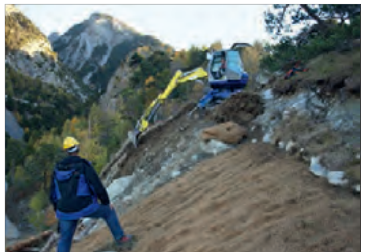
Abb. 6: Abflachung der Böschung und Hinterfüllung Holzroste; Ph. Müller Fig. 6: Aplatissage du talus et remplissage du treillage; Ph. Müller
