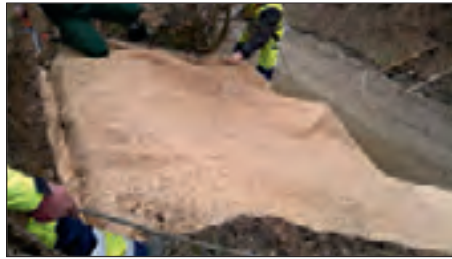
Abb. 10: Verankerung der Matten Abb. 10: Ancrage des nattes
