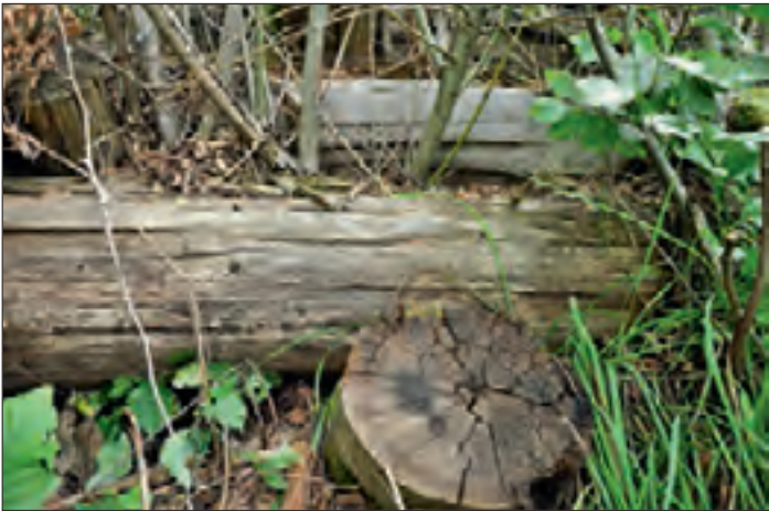
Abb. 24: Nahezu intakte Lärchenhölzer an der untersten Krainerwand des Zufahrtsweges zu den Widmayrhöfen, nach 20 Jahren, Sommer 2011. Fig. 24: Bois de mélèze presque intact sous le caisson protégeant le chemin d'accès pour Widmayrhöfen, 20 ans après son installation, été 2011.
