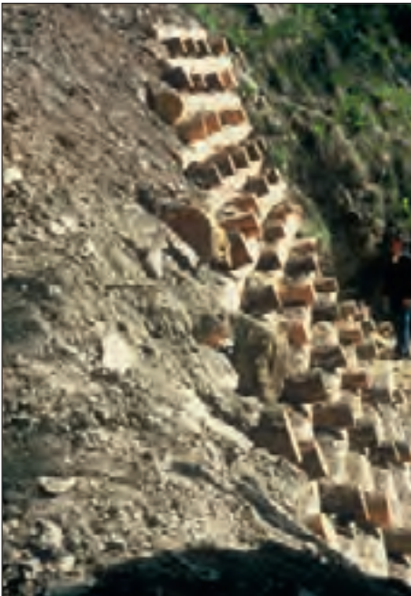
Abb. 14: Sicherung des abgebrochenen LKW-befahrenen Zufahrtsweges zum Pfannhorn/Toblach durch eine hohe und in das Wegeplanum hineinreichende Holzkrainerwand, Frühjahr 1984. Fig. 14: Protection du chemin d'accès endommagé par les camions dans la région de Pfannhorn/Toblach par l'installation d'un grand caisson en bois et par l'insertion de ce tronçon dans le plan directeur de circulation, printemps 1984.
