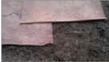
Abb. 12: Überlappung der Bahnen Fig. 12: Chevauchement entre les bandes
