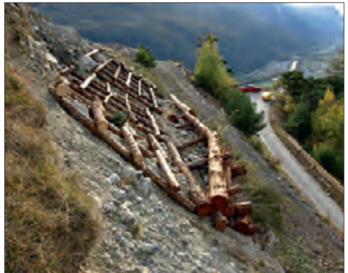
Abb. 11: Holzkasten und Holzroste während des Baus; Ph. Müller Fig. 11: Caissons et armature en bois pendant la construction; Ph. Müller
