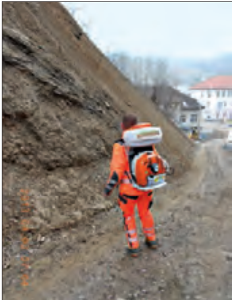
Abb. 8: Einbringen der Samen unter das Vlies, Bild Kurt Hollenstein Fig. 8: Introduction des semis sous le géotextile, image Kurt Hollenstein
