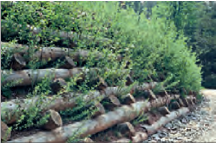
Abb. 22: Die Holzkrainerwand nach einem Jahr, Frühjahr 1992. Fig. 22: La paroi en bois après une année, printemps 1992.
