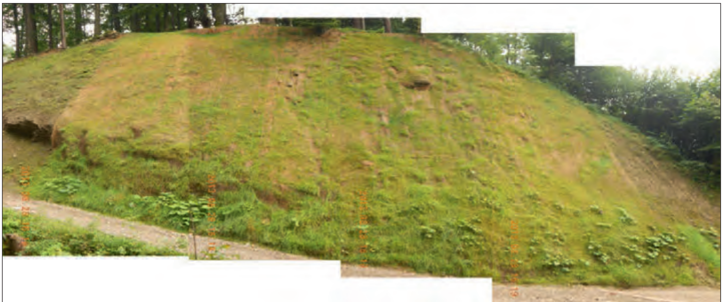
Abb. 26: Zustand der Versuchsfläche knapp fünf Monate nach dem Einbau, Bild Kurt Hollenstein
