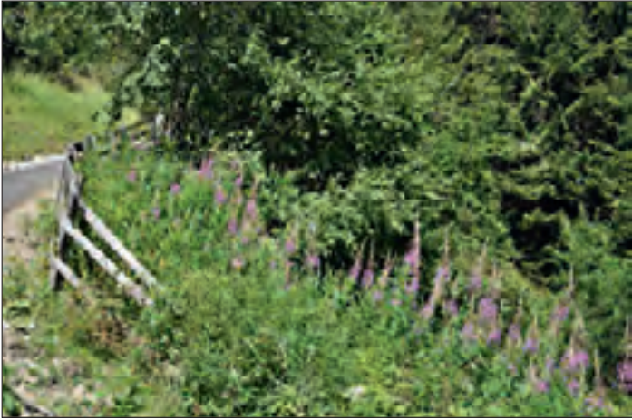
Abb. 16: Die bepflanzte Holzkrainerwand am Zufahrtsweg zum Pfannhorn/Toblach nach 27 Jahren, Sommer 2011.
