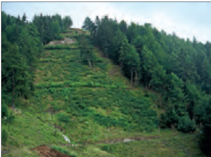
Abb. 11: Die Runer-Mure nach der Bepflanzung mit Grünerlen und Ebereschen, 7 Jahre nach den Sicherungsarbeiten, Sommer 1994.
