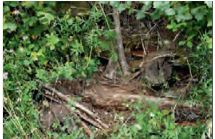
Abb. 25: Teilweise vermorschter Splint (unten) und bereits beginnende Fäulnis des Kernholzes (oben), was auf eine unterschiedliche Qualität der Lärchen-Rundhölzer schliessen lässt, Sommer 2011. Fig. 25: Aubier partiellement vermoulu (dessous) et début du pourrissement du noyau (dessus), permettant de conclure sur la différente qualité des rondins en mélèze, été 2011.
