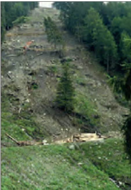
Abb. 8: Sicherung der Runer-Mure bei Matsch mit einer Blocksteinmauer am Fuss und vier bepflanzten Holzkrainerwänden. Im Bau ist (von oben gesehen) die 3. Holzkrainerwand, Frühjahr 1987. Fig. 8: Protection contre les coulées de boue de la Run au niveau de Matsch avec un mur en blocs et quatre caissons implantés. Le troisième caisson est ici en construction (vue du dessus), printemps 1987.
