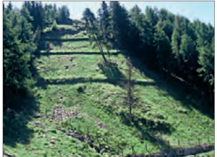
Abb. 10: Die gesicherte Runer-Mure nach 4 Jahren, Sommer 1991.
