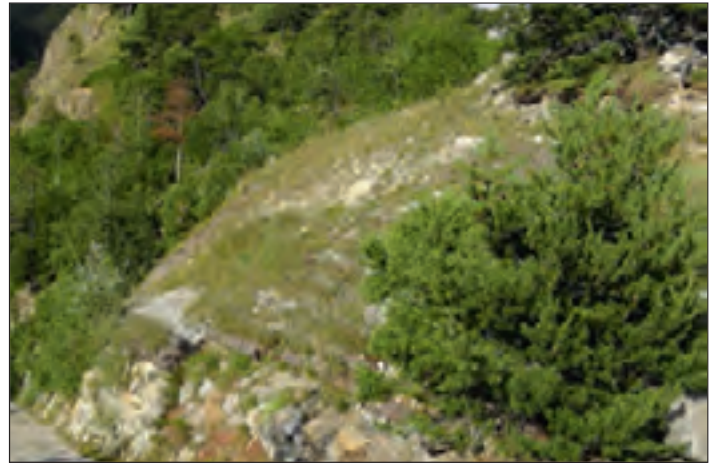
Abb. 2: Böschungsverbauung Juli 2012; Ph. Müller Fig. 2: L'ouvrage de stabilisation en juillet 2012; Ph. Müller
