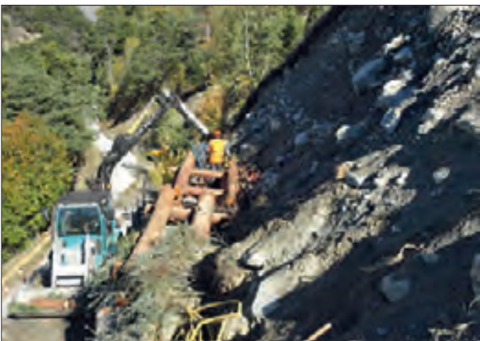
Abb. 5: Bau zweihäuptiger Holzkasten durch Forstgruppe; Ph. Müller Fig. 5: Construction des deux principaux caissons en bois par le groupe forestier; Ph. Müller
