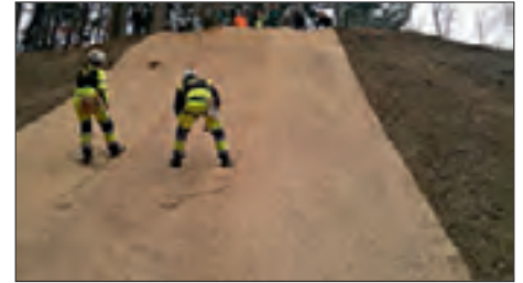
Abb. 13: Fortsetzung der Installation Fig. 13: Suite de l'installation
