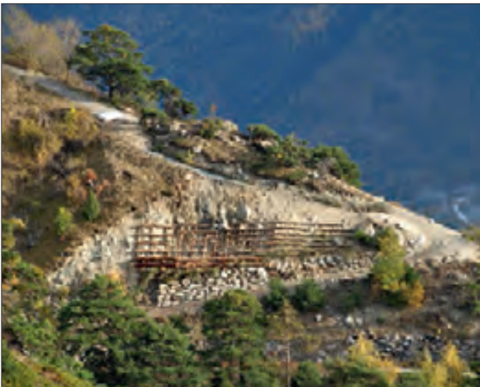
Abb. 10: Holzkasten und Holzroste während des Baus; Ph. Müller Fig. 10: Caissons et armature en bois pendant la construction; Ph. Müller
