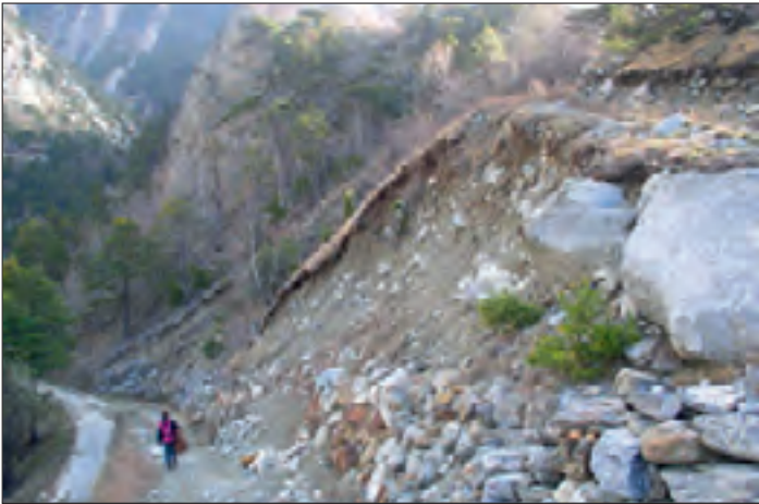
Abb. 1: Erosionshang 2005; Ph. Müller Fig. 1: Le versant d'érosion en 2005; Ph. Müller
