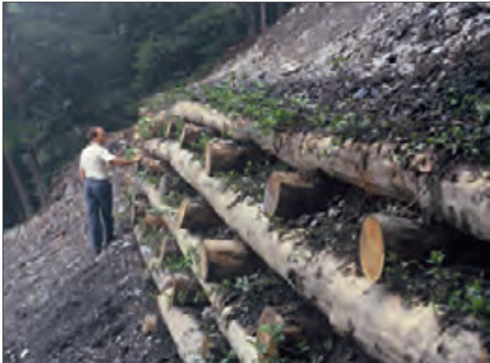
Abb. 9: Eine fertig gestellte Holzkrainerwand mit der Einlage von bewurzelten Laubgehölzen und dem kritischen Blick von Christian Göldi, Frühjahr 1987.
