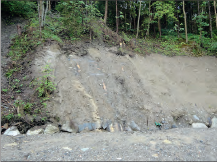
Abbildung 16: Das Deckmaterial rutschte ins Gerinne. Figure 16: Le matériel de couverture glisse dans le lit du ruisseau.
