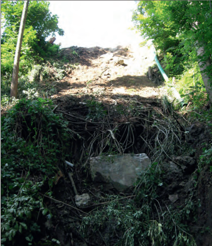
Abbildung 2: Abgerutschtes Hangmaterial und provisorische Ableitung des Meteorwassers.
