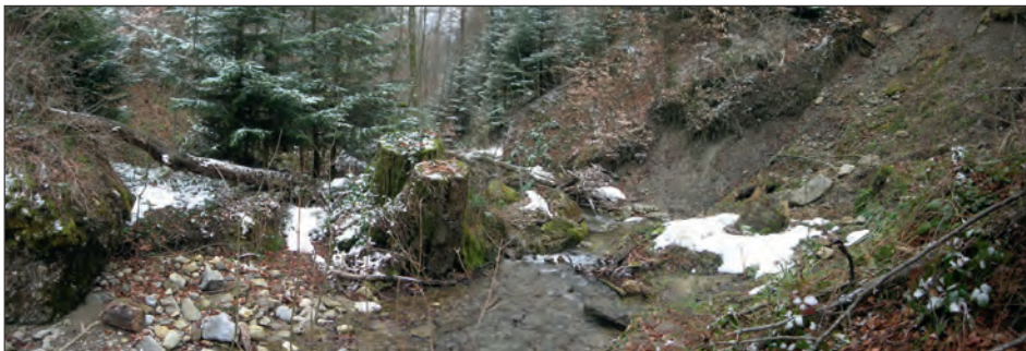
Abbildung 7: Der Mitteldorfbach erodiert am Fuss der unteren Rutschung (Prallhang). Dadurch bricht ständig Material nach. Figure 7: Erosion au pied du glissement inférieur du Mitteldorfbach (berge affouillée). Des matériaux sont sans cesse apportés.
