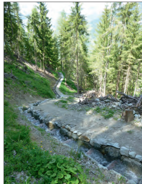
Foto 2: Mit Natursteinen eingefasster Wasserlauf, der in Holzkännel übergeht: neu gebauter Teil der Bisse des Ravines in Bruson VS. Photo no 2 : Cours d'eau revêtu à cet endroit de grosses pierres naturelles et prolongé par une conduite en bois : tronçon du bisse des Ravines rénové de Bruson VS.
