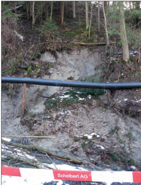
Abbildung 13: Abgerutschtes Böschungsmaterial beim Würzlibach.
