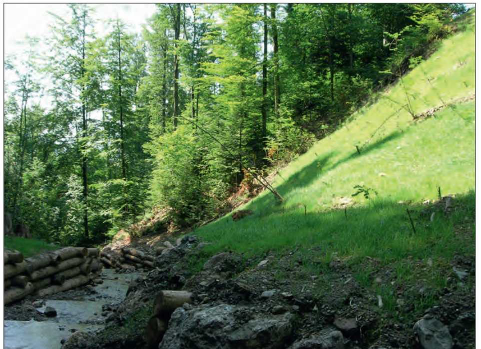
Abbildung 12: Der Hang wurde angesät und pro m 2 wurde ein Weidensteckholz oder eine Erle gepflanzt. Figure 12: La pente a été ensemencée et une bouture de saule ou un aulne a été planté par m 2 .
