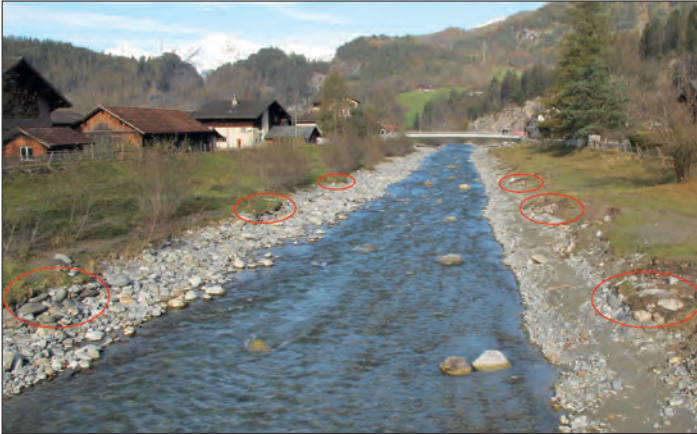
Abbildung 1: Kanalisierter Abschnitt der Aare in Innertkirchen (im Oktober 2010), welcher als Grundlage für das hydraulische Modell diente. Einige Bühnenköpfe sind rot markiert. Die Bühnenzwischenfelder sind über die Jahrzehnte praktisch vollständig verlandet. (Blick in Fließrichtung.)
