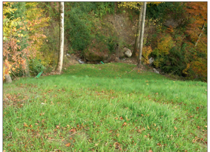
Abbildung 5: Der Hang wurde gleich nach Fertigstellung der Bautätigkeiten angesät und im Folgejahr mit Weidensteckhölzern bepflanzt. Mit der Ansaat wird der oberflächlichen Erosion rasch entgegengewirkt. Die Weiden tragen zur nachhaltigen Stabilisierung des Hangs sowie zur Beschattung bei. Die Beschattung ist ebenfalls wesentlich in Zusammenhang mit der Lebensdauer des Holzverbau.
