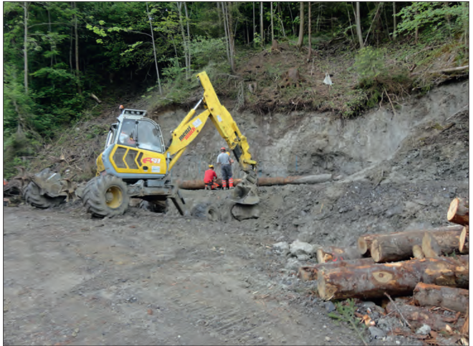
Abbildung 14: Anstelle eines Holzkastens wurde ein Baumstamm als Basis fixiert. Dahinter wurden die zwei Hangroste angeordnet.
