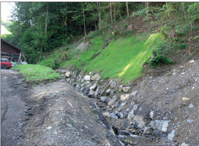
Abbildung 18: Sofortige Begrünung der Böschung und damit Schutz vor Erosion. Figure 18: Végétalisation immédiate du versant et donc protection contre l'érosion.
