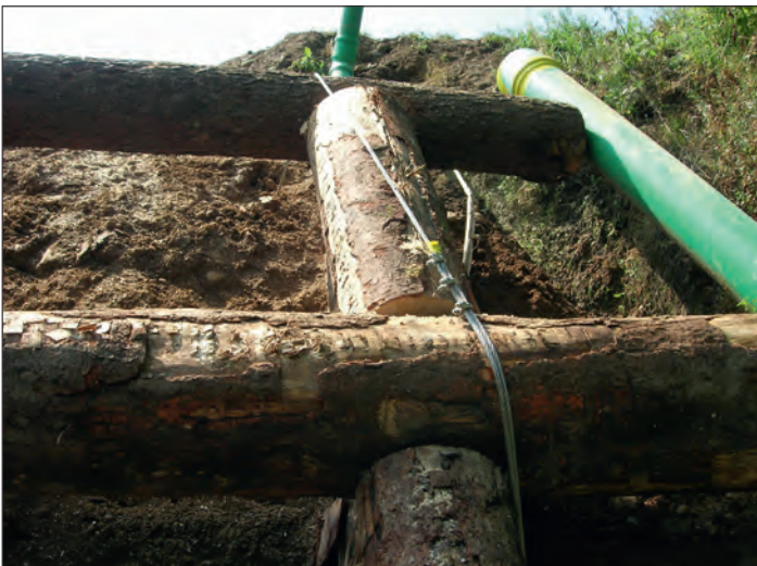
Abbildung 4: Der Hangrost wird mit Manta-Ray-Zuganker nach hinten fixiert. Das Bauwerk wird zudem entwässert.
