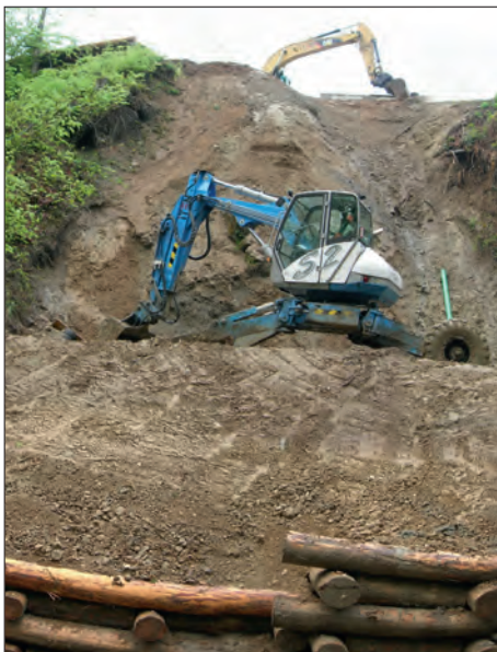
Abbildung 11: Sobald der Bach verbaut war, konnte mit dem Hangverbau, d. h. den Holzkästen, begonnen werden. Figure 11: Une fois que le ruisseau a été aménagé, la stabilisation de versant, c'est-à-dire les caissons en bois, a pu commencer.
