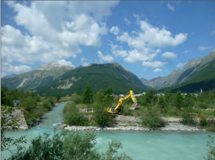
Foto 3: Einmündung des kanalisierten Beverin in den Inn bei Bever GR: bei Beginn der Bauarbeiten im Sommer 2012 ... Photo no 3 : Embouchure du Beverin (canalisé) dans l'Inn près de Bever GR. Début des travaux en été 2013 ...
