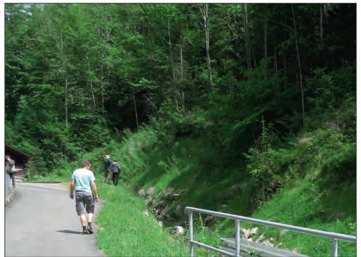
Abbildung 19: Drei Jahre nach Fertigstellung der Baustelle: Die Böschung ist vollständig verwachsen. Figure 19: Trois ans après l'achèvement des travaux : le versant est totalement recouvert de végétation.
