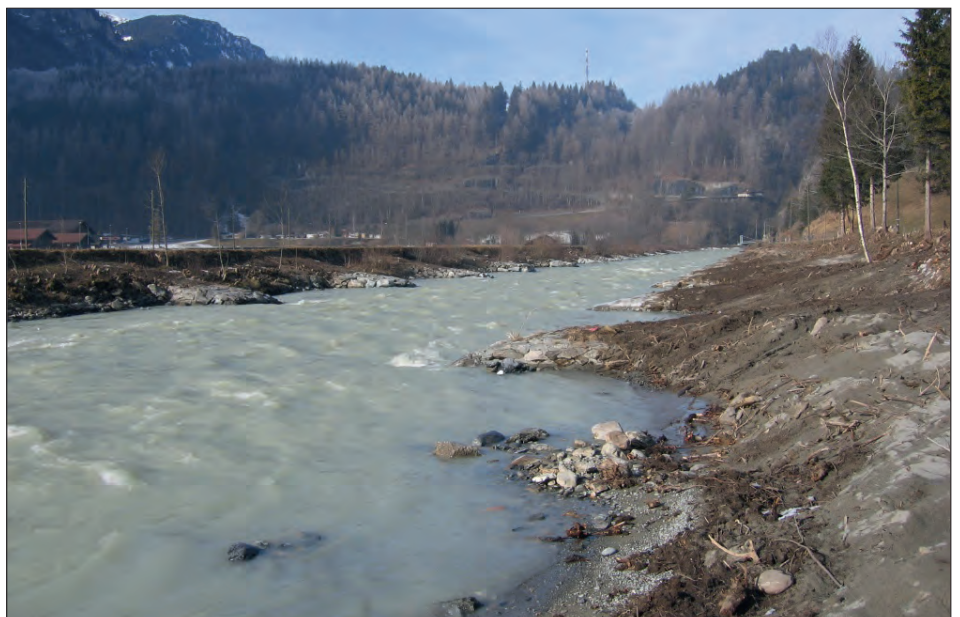
Abbildung 1: Aaregerinne / Bühnenstrecke im Bereich der Musterstrecke. Figure 1 : Lit de l'Aar / Tronçon avec épis dans le domaine du tronçon pilote.
