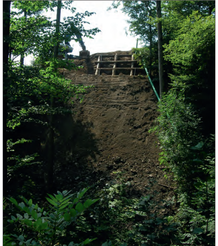
Abbildung 3: Holzkasten und Hangrost werden mit Erde eingedeckt. So bleibt die Feuchtigkeit des Holzes weitgehend gleich, womit die Lebensdauer stark erhöht wird.
