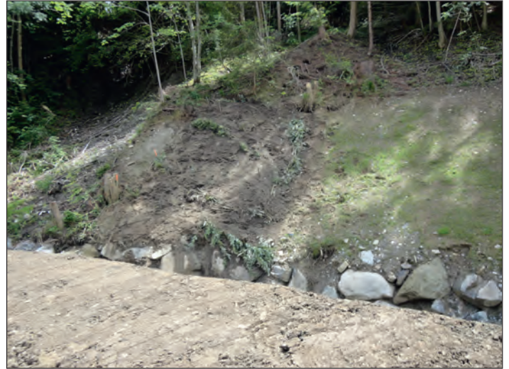
Abbildung 17: Weidenfaschinen zur Stabilisierung der Holzrost-Überdeckung sowie Ableitung des Wassers. Figure 17: Fascines de saule pour la stabilisation de la couverture de l'armature en bois, ainsi que déviation de l'eau.
