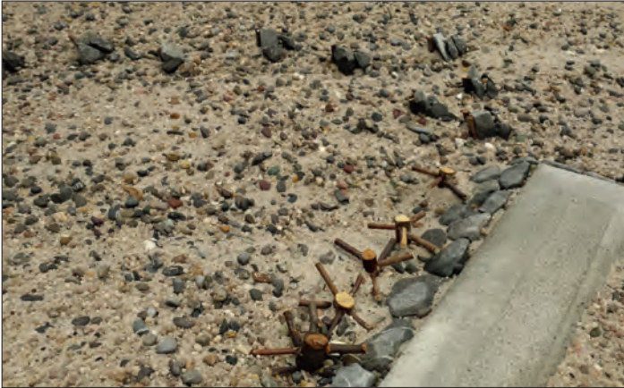
Abbildung 5: Im Kolk unterstrom einer Buhne wurden Wurzelstöcke auf unterschiedlichen Höhenlagen eingebaut. Im Mittelgerinne und am gegenüberliegenden Ufer sind Belebungssteingruppen angeordnet. (Fließrichtung von rechts nach links.)
