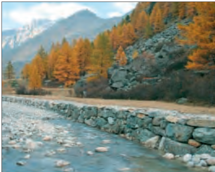
Fig. 1 : En régions de montagne, trop d'ouvrages de protection sont encore réalisés sans aucune réflexion sur la qualité écologique et paysagère des cours d'eau, alors même que les contraintes physiques ne sont pas toujours insurmontables pour des techniques plus intégrées (photo P.-A. Frossard, hepia).
