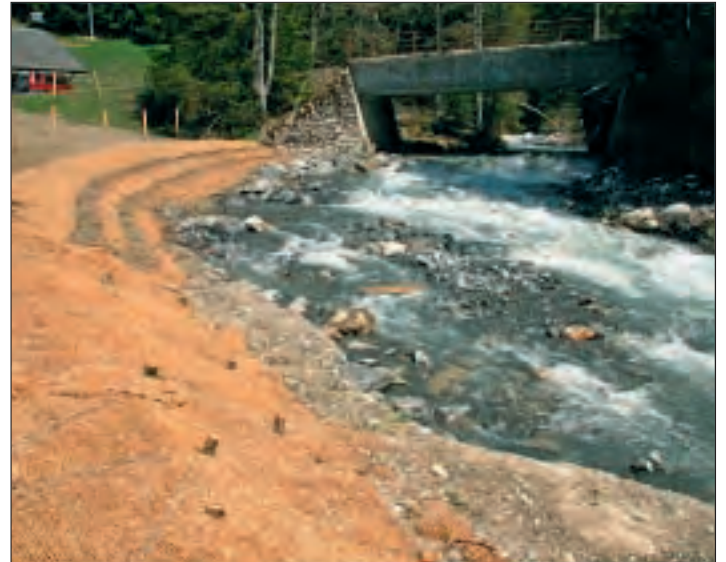
Fig. 6 : Aménagement des berges de l'Avançon d'Anzeindaz à l'aide de différentes techniques, sur les communes de Bex et Gryon (Suisse), au lieu-dit Pont de Cergnement (photo P.-A. Frossard, hepia).
