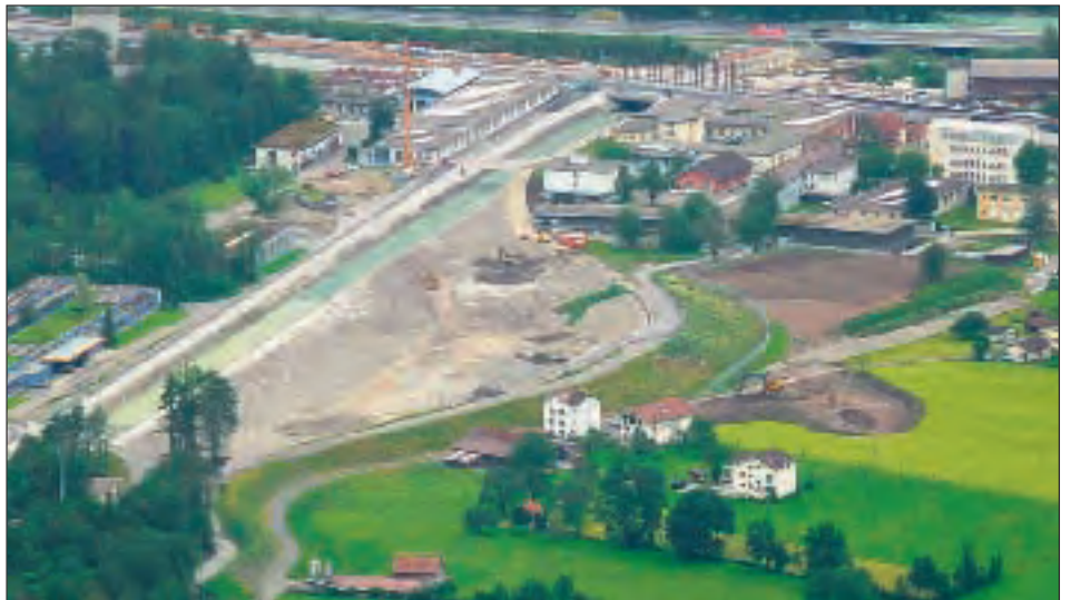
Abb. 3: Luftbild Baustelle Geschiebesammler vom Juli 2012, Enderarbeiten Geschiebesammler und Gestaltung der Sekundärdämme (Foto: Stefan Simmen, Terraplan).
