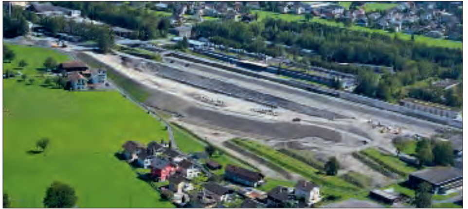
Abb. 2: Luftbild Baustelle Geschiebesammler vom 16. September 2011, Endgestaltung und Begrünung Hauptdamm (Foto: IUB Engineering AG).
