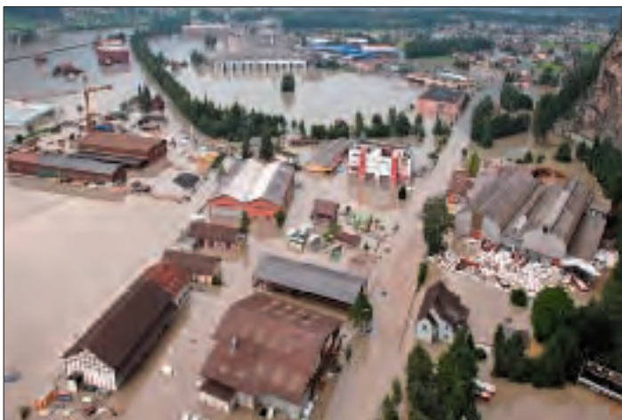
Foto 1: Schadenbild HW 2005 mit «Schattdorfer-See». Fig. 1: Illustration des dommages lors des inondations de 2005 avec le «lac de Schattdorf».
