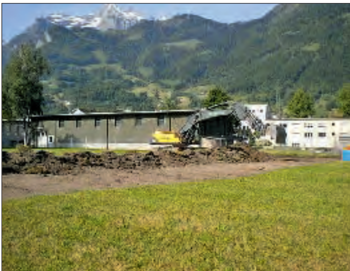
Abb. 6: Bodenabtragsarbeiten, 10. Mai 2011 (Foto: CSD Ingenieure AG). Fig. 6: Travaux d'enlèvement de la couverture végétale, 10 mai 2011 (photo: CSD Ingenieure AG).
