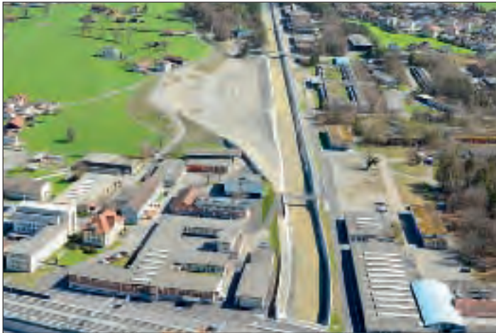
Foto 3: Fertig erstellter Geschiebesammler RUAG mit 80000–90000 m 3 Fassungsvermögen.
