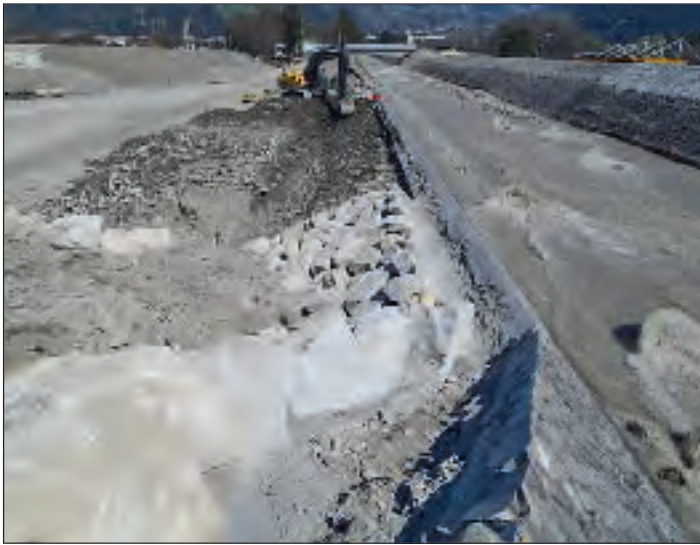
Abb. 4: Geschnittene Schächenschale beim Geschiebesammler, 26. März 2012 (Foto: CSD Ingenieure AG). Fig. 4: Mise en place dans le dépotoir à alluvions, 26 mars 2012 (photo: CSD Ingenieure AG).
