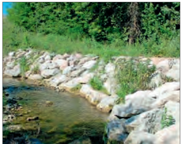
Fig. 2 : Une des berges enrochées échantillonnées (photo L. Ducasse). Abb. 2: Eines der erfassten Ufer mit Steinschüttung (Foto L. Ducasse).
