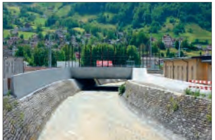
Foto 8: Druckbrücke über den Schächen.
