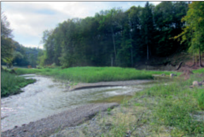
Foto 11: Revitalisierung der Glatt im Bereich Isenhammer (Kanton SG) mit Vernetzung von Amphibiengebieten von nationaler Bedeutung (Bild: Fröhlich Wasserbau AG). Photo 11: Revitalisation de la Glatt vers le domaine Isenhammer (canton SG) avec mise en réseau des zones réservées aux amphibiens d'importance nationale (image: Fröhlich Wasserbau AG).
