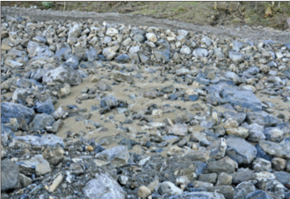
Foto 5: Stufenbecken-Sequenz von R. Weichert (2005) am Steinbach im Bezirk Einsiedeln. Photo 5: Séquence de bassins en étages de R. Weichert (2005) à Steinbach dans le district d'Einsiedeln.
