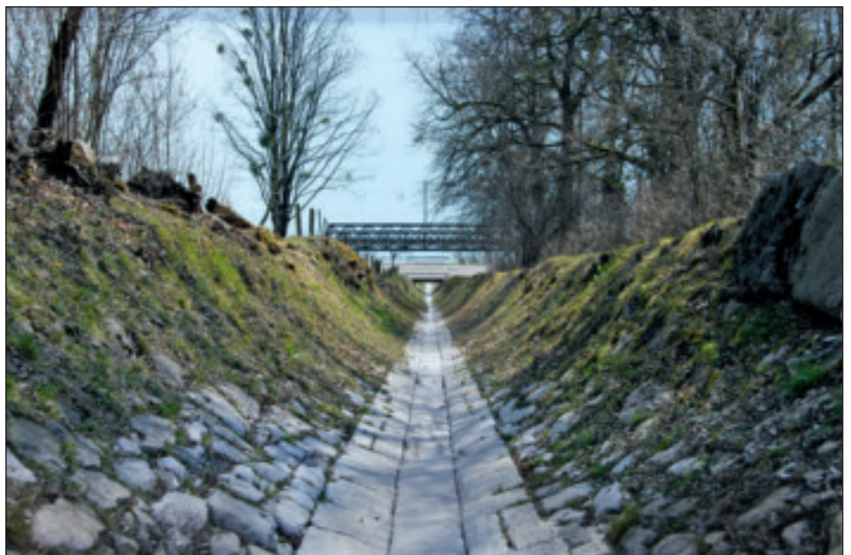
Abb. 1: Harte Verbauung am Hirscherenbach in Oberried am Brienzersee. Figure 1: Construction en dur au Hirscherenbach à Oberried au Lac de Brienz.
