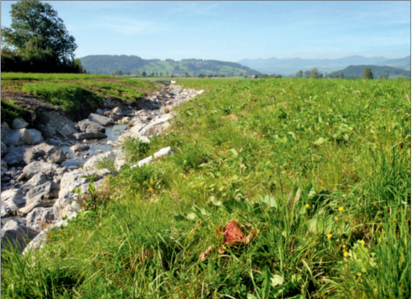
Abb. 8: Rappenbach bei Schänis im zweiten Jahr: Keine typische Uferpflanze ist in Sicht, weil keine aktive Begrünung stattfand. Zudem sind die Übergänge zu den übergrossen Steinen zu hart.
