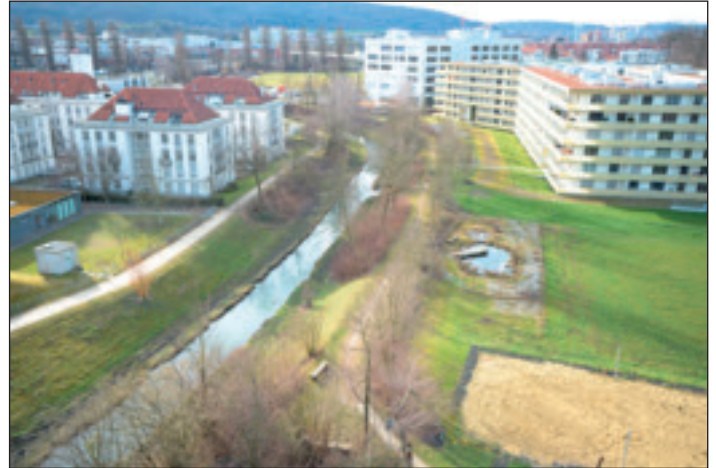
Foto 10: Zustand des Chriesbaches vor der Revitalisierung (Quelle: Andri Bryner). Photo 10: État du Chriesbach avant la revitalisation (source: Andri Bryner).
