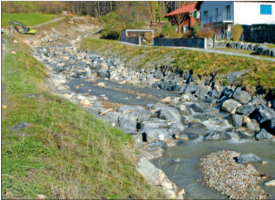
Abb. 7: Blockrampen mit flachen Zwischenstrecken am Flybach in Weesen. Figure 7: Rampes en blocs en combinaison avec des tronçons plats au Flybach à Weesen.
