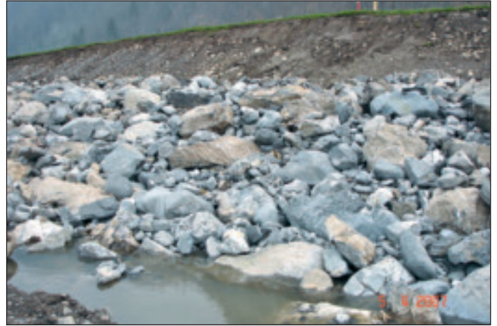
Foto 4: Rähnenverbau an der Minster in Unterberg. Photo 4: Ouvrage en bordure du Minster à Unterberg.
