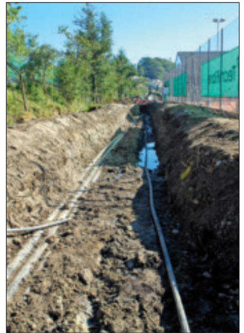
Foto 1: Leitungsgraben der zu verlegenden Leitung entlang des Krebsbaches in Wollerau.
