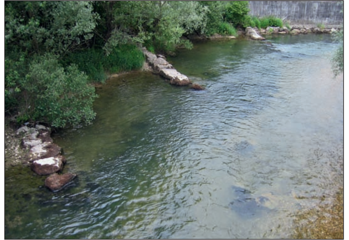
Fig. 4H : 2005. Vingt ans après les travaux, les épis sont toujours là et jouent infatigablement leur rôle de déflecteur. Des surprofondeurs existent entre les épis et la RG se végétalise de plus en plus favorisant un milieu diversifié pour la faune terrestre et aquatique.
