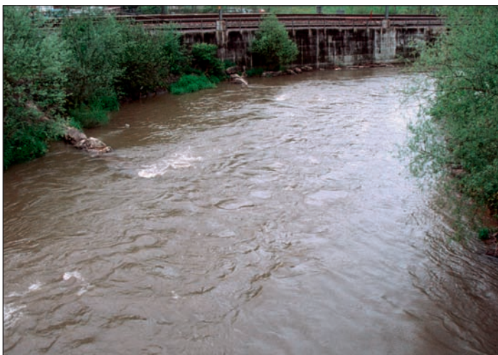
Fig. 4E : 1997. Petite crue montrant parfaitement bien le rôle des épis dans le recentrage du courant. Des saules se développent au pied des enrochements en RG.
