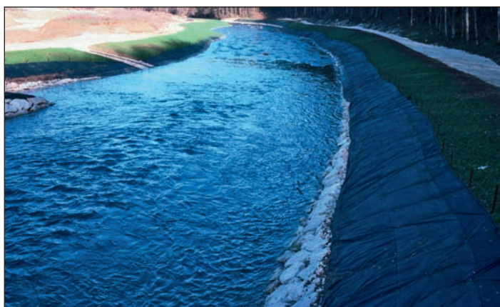
Fig. 2C : 1985. Protection provisoire durant l'hiver avec un géotextile synthétique. Les plantes herbacées ont poussé depuis l'automne 1984. L'eau coule depuis quatre mois dans son nouveau lit.
