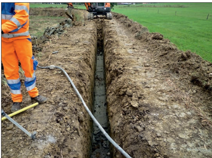
Fig. 9 : Creusage d'une tranchée dans la digue pour réalisation du muret anti-rat musqué (photo Biotec). Abb. 9: Aushebung eines Grabens im Deich, um die Wand zum Schutz gegen die Bismarcke einzulassen (Foto Biotec). Fig. 9: Scavo di una trincea nella diga per realizzare un muretto anti-topo muschiato (foto Biotec).
