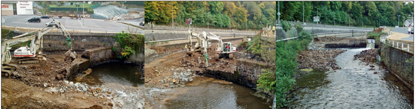
Fig. 6 : Démolition progressive du seuil, en dérivant successivement les eaux de la Corrèze gauche-droite (photos Biotec).
