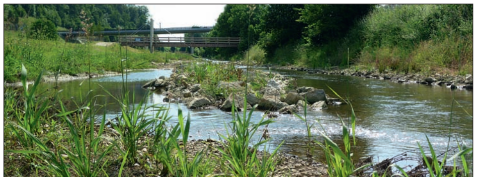
Fig. 8 : Création d'une certaine diversité et de structures dans le lit avec la mise en place d'îlots. Comme ici sur la photo, mais également avec des épis et des rampes (photo Biotec).
