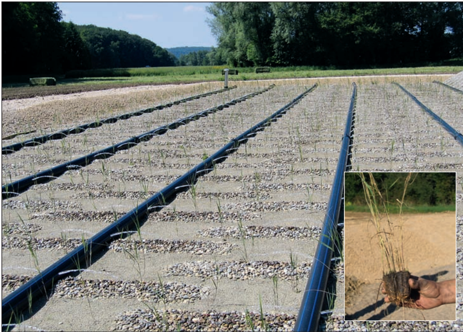
Fig. 5 : 2 e étage de traitement en fin de travaux, juste après la plantation des roseaux, avec le détail d'une motte de roseau ; on y observe la répartition des eaux sur toute la surface grâce à un arrosage horizontal produit par le siphon.
