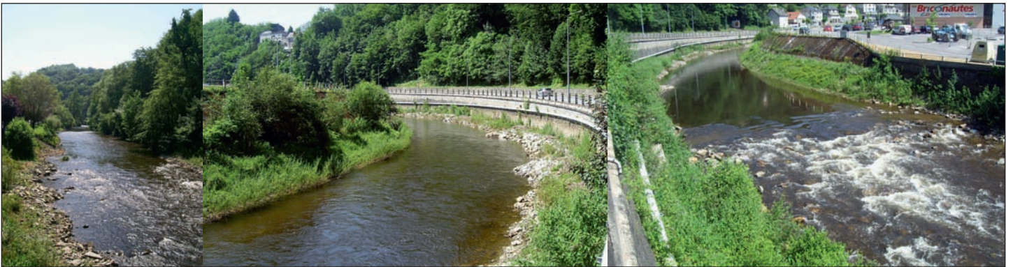
Fig. 9 : Evolution du site un an et demi après les travaux ; juillet 2010 (photos Biotec).
