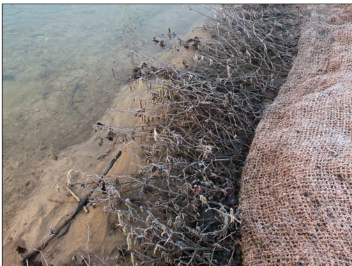
Fig. 11 : Détails du sac en coco avec l'effet des ramilles sur le piégeage des sédiments fins et plantation des hélophytes qui permettront la stabilisation du pied de berge à l'arrière des terrasses érodables (photos Biotec).
