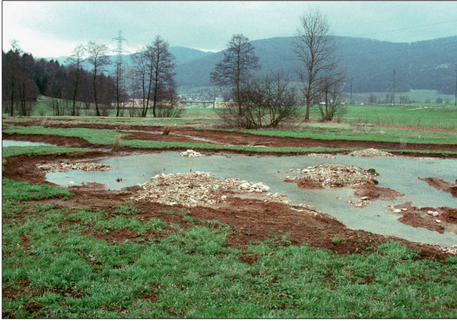
Fig. 7 : Etat vers la fin des travaux. Une mosaïque de structures diversifiées a été mise en place en relation avec l'eau (photo Biotec, 18.03.1993).
