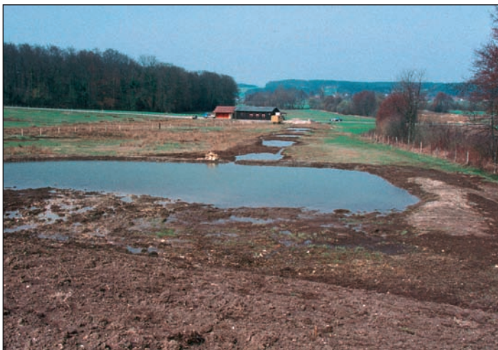
Fig. 8 : Grande mare réalisée avec le surplus de marne de la digue de l'étang. Elle récupère l'eau d'un des trop-pleins de l'étang qui poursuit sa course ensuite vers l'aval à travers de nouvelles vasques (photo Biotec, 1996).
