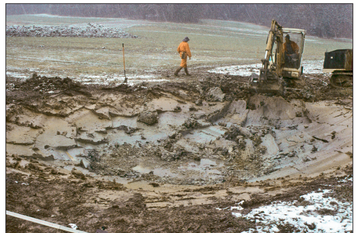
Fig. 4 : Creusage de nombreuses dépressions afin de créer des mares plus ou moins profondes (photo Biotec, 17.02.1993).
