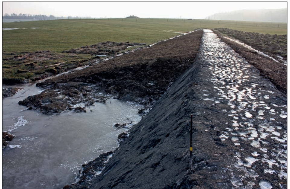
Fig. 7 : Illustration d'un prolongement de digue en travaux. On distingue au premier plan le noyau de marnes à opalines et en second plan le talutage final avec des matériaux terreux du site (photo Biotec). Abb. 7: Darstellung einer Deichverlängerung während der Bauarbeiten. Im Vordergrund ist der Deichkern aus opalinem Mergel zu sehen, im Hintergrund sehen wir die fertiggestellte Abböschung mit vor Ort vorhandenem Erdmaterial (Foto Biotec). Fig. 7: Illustrazione di lavori di prolungamento di una diga. Si distingue in primo piano il nucleo di marna con opaline e in secondo piano la disposizione finale a scarpata con materiali terrosi del luogo (foto Biotec).
