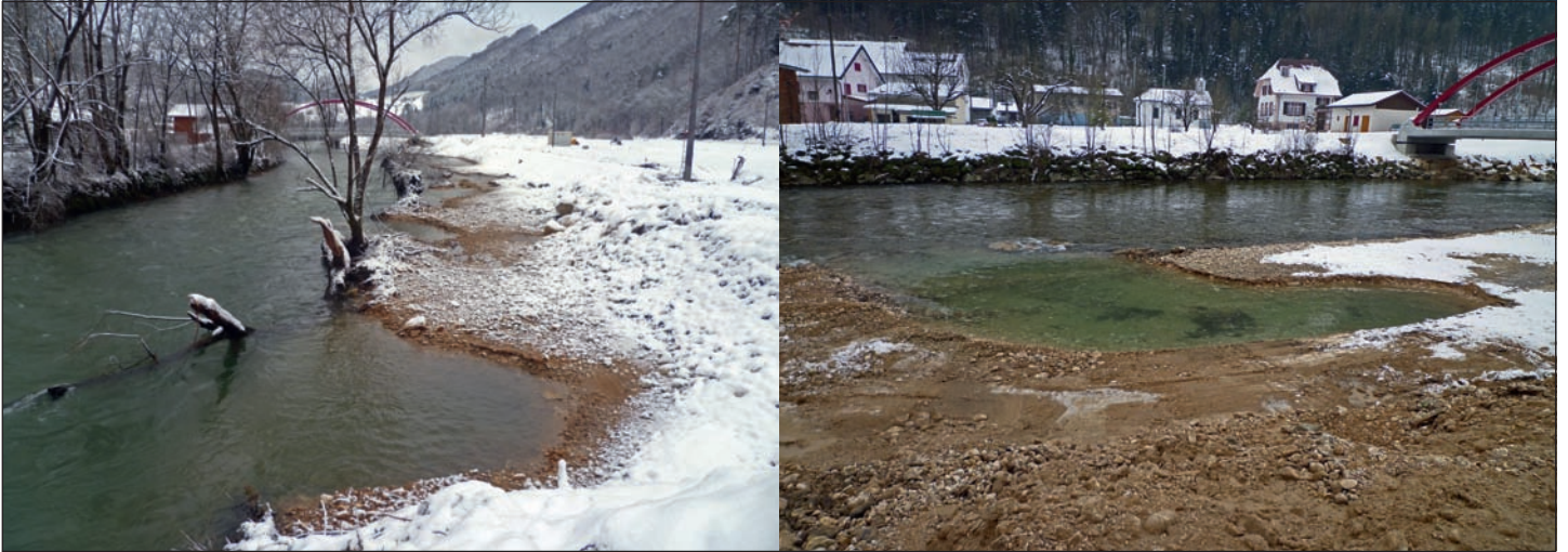
Fig. 10 : Amorces érosives créées sur les terrasses (photos Biotec).
