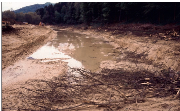
Fig. 2A : Début 1984. Début des travaux de terrassement du nouveau lit.
