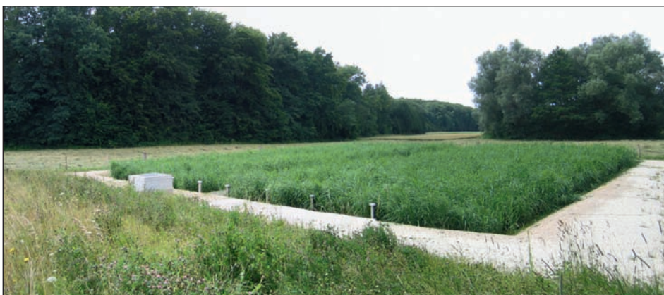
Fig. 8 : Des roseaux sur le 2 e étage de traitement deux ans après la réalisation des travaux.
