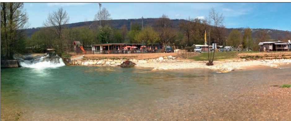
Fig. 11 : L'aménagement d'une zone d'accès à l'eau dans le camping de Delémont a été réalisé en bordure de la fosse du seuil de la Grande Ecluse. Pour garantir le maintien de la plage de graviers, des épis ont été mis en place (photo Biotec, avril 2012).
