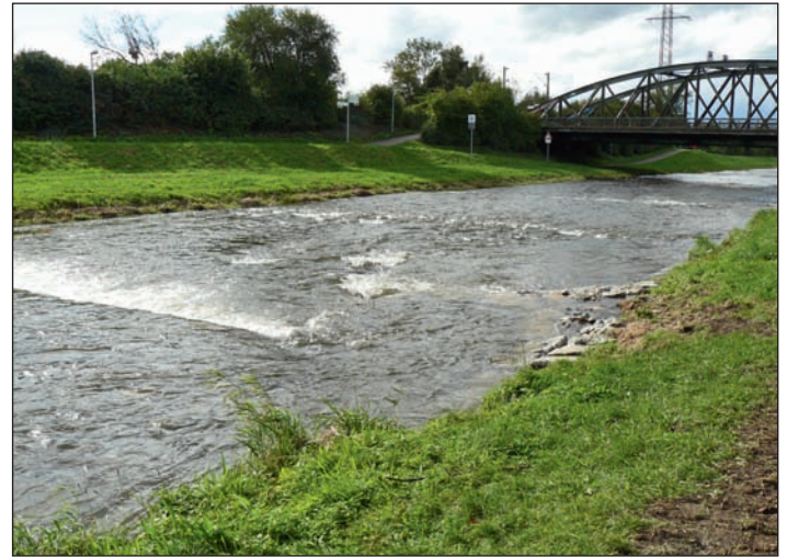
Abb. 3: Strömungsvielfalt im Umfeld von Lenkbuhnen (links); Wiederherstellung der biologischen Durchgängigkeit durch Teilöffnung einer Schwelle in Kombination mit einer Schneckenbuhne (rechts; Fotos: Erich Linsin).
