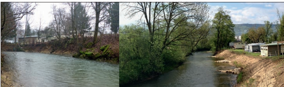
Fig. 7 : A gauche, importante érosion de la berge en bordure du camping ; à droite, traitement de la berge en technique mixte avec en arrière-plan la combinaison épis en blocs / fascines de saules et au premier plan enrochement de pied de berge surmonté de lits de plants et plançons (photos Biotec, février 2010 et mai 2012).
