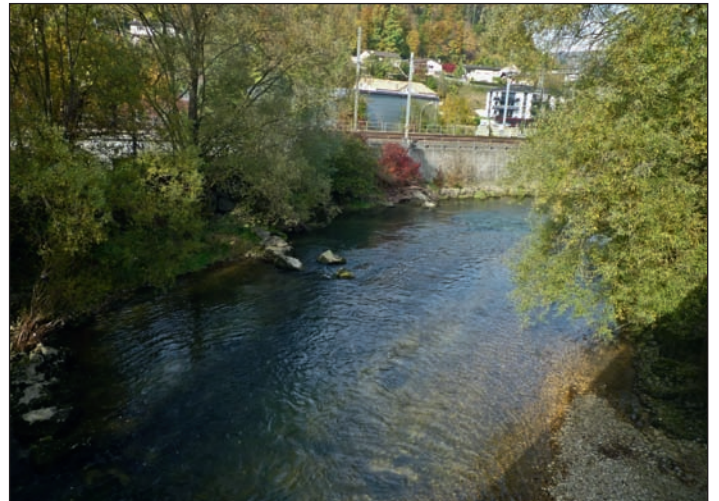
Fig. 4J : 2011. Vue générale du site presque 30 ans après. On remarque que les grandes crues de 2006 et surtout 2007 ont bousculé quelques blocs.
