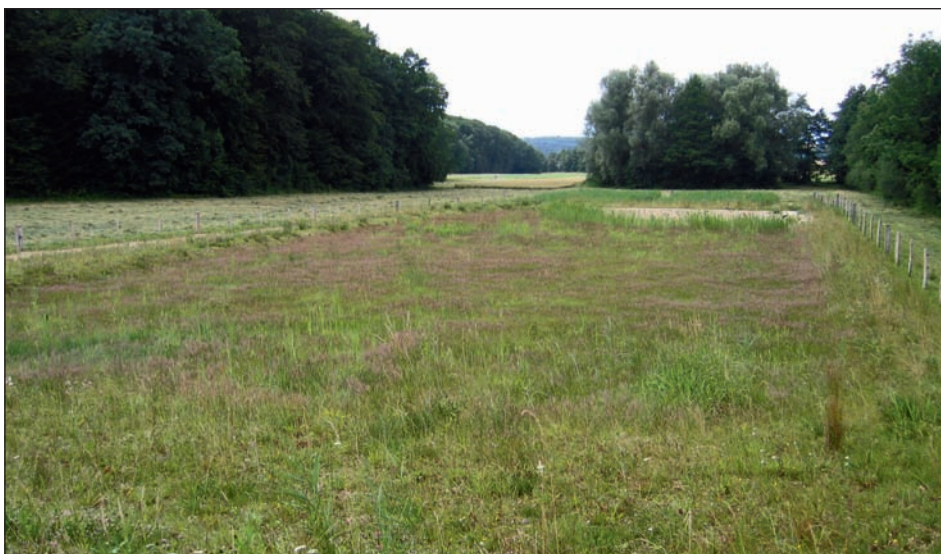
Fig. 6 : Zone humide située entre les deux étages de traitement permettant une épuration des eaux pluviales (750 m 3 ) avant le rejet dans la rivière.
