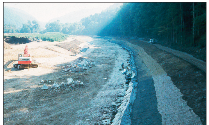
Fig. 2B : 1984. Fin des travaux de génie civil et mise en place des travaux de génie biologique (géotextiles, semis hydrauliques...). La technique végétale prioritairement utilisée est les mélanges grainiers de plantes herbacées et géotextiles.
