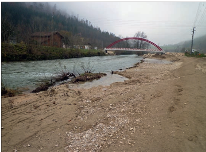
Fig. 8 : Élargissement du lit en aval du pont et diversification spontanée de la morphologie (photo Biotec).
