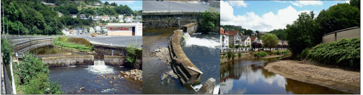
Fig. 5 : Première opération : ouverture des vannes et abaissement de la retenue, qui laissent déjà apparaître des bancs graveleux (photos Biotec).
