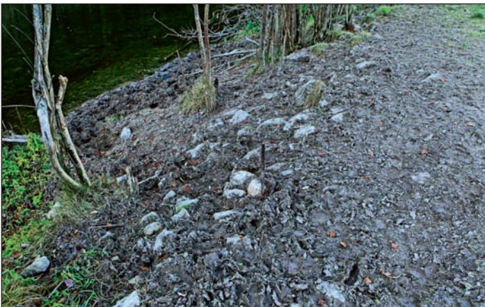
Photo 1 : Trop fortes pressions agricoles sur les berges du Doubs.
