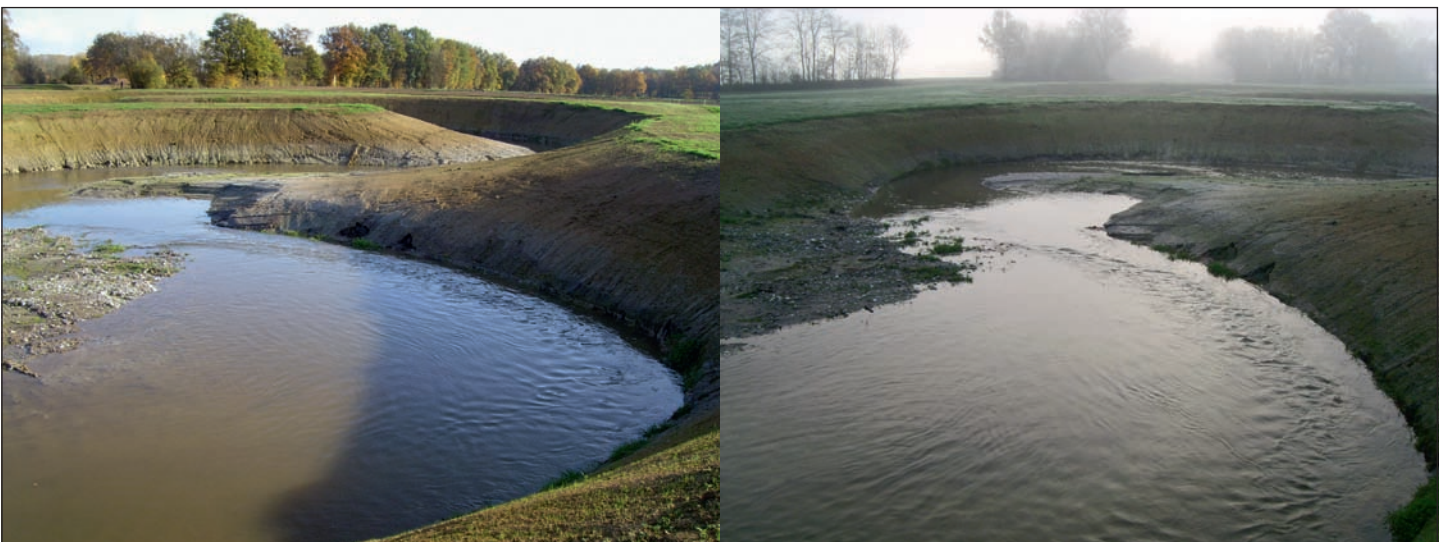
Fig. 8 : Premier jour suite à la « mise en eau » du nouveau cours d'eau (photos Biotec).
