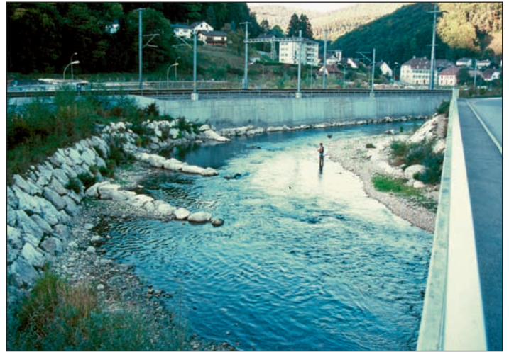
Fig. 4B : 1988. Le dépôt en rive droite, par rapport à 1985, est nettement moindre, uniquement exporté par l'effet des épis. On remarque bien la géométrie plongeante des épis, leur longueur et leur orientation vers l'amont.
