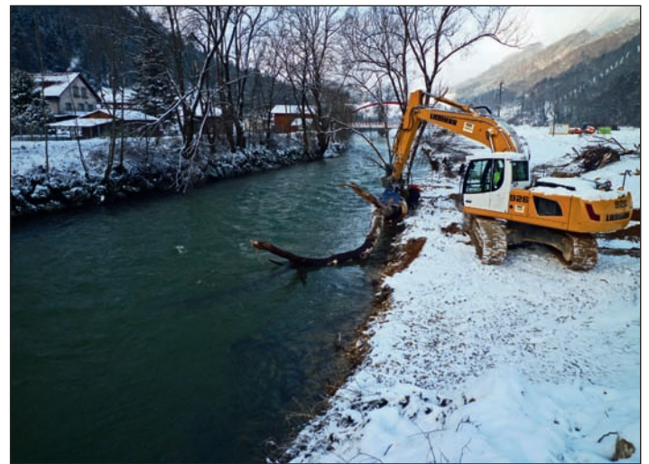
Fig. 9 : Mise en place de bois mort dans le lit du cours d'eau et arrimage à l'aide de câble à un arbre existant (photo Biotec).
