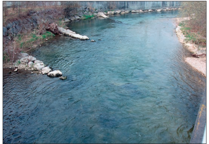
Fig. 4D : 1996. Malgré des crues successives importantes depuis la fin des travaux (1985), on constate que le banc de galets ne grossit pas et que les épis ont favorisé le dépôt de matériaux fins en rive gauche, au pied des enrochements, ce qui permet à la végétation spontanée de s'installer.
