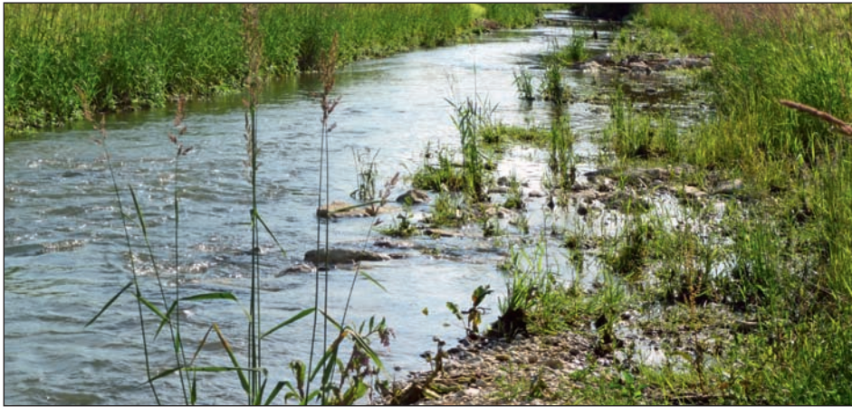
Fig. 9 : Les replats inondables en rive droite (ici en décrue) n'ont pas été stabilisés mais uniquement plantés d'hélophytes pour amener une certaine diversité et surtout laisser à la rivière la possibilité d'éroder ces terrasses pour définir elle-même son propre lit (photo Biotec).
