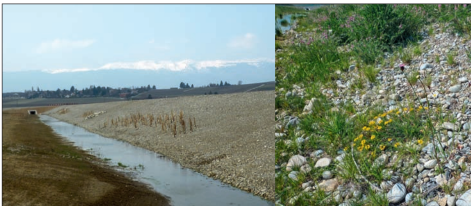
Fig. 9 : Détail des matériaux graveleux utilisés pour le recouvrement de la digue bordant le fossé de gestion des eaux de ruissellement et de l'excellent développement de la prairie fleurie sèche, quelques années après le semis. Malgré un substrat très pauvre, cette mosaïque de milieux secs et humides a déjà vu l'installation du crapaud calamite, du petit gravelot et de différentes espèces d'azurés (papillon) (photos Biotec).
