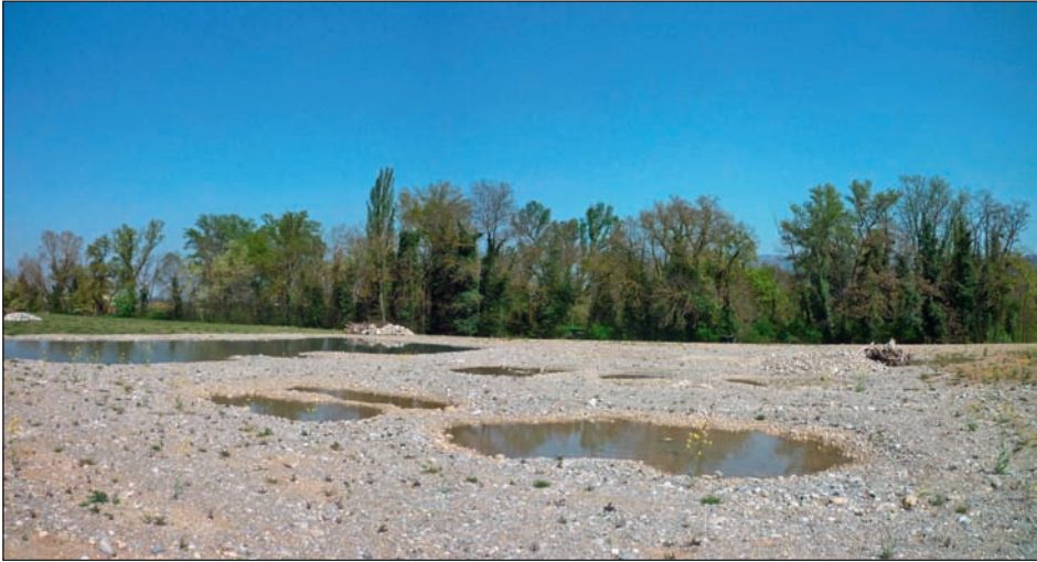
Fig. 10 : Création de milieux pionniers avec mares et microstructures pour la petite faune sur une zone remblayée avec 200 000 m 3 de matériaux provenant des terrassements du nouveau lit de l'Aire (gestion des excavations exclusivement sur le site du projet) (photo Biotec).
