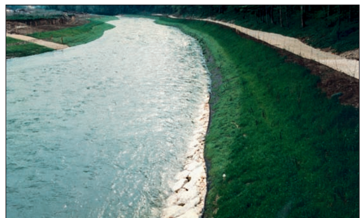
Fig. 2D : 1985. Enlèvement du géotextile synthétique et plantation d'espèces ligneuses en sommet de berge droite pour reconstituer l'effet lisière. Quelques autres techniques végétales (tressage, bouturage) ont été utilisées sur la rive gauche.
