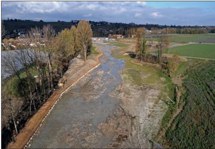
Fig. 6 : Espace mis à disposition de l'Aire avec de grandes zones inondables, parfois vouées à être reboisées (saulaies, aulnaies) ou maintenues ouvertes (mégaphorbiaies). Vue juste à la fin des travaux de terrassement, en novembre 2009 (photo Induni).
