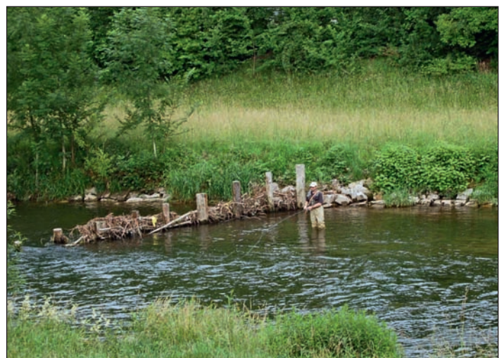
Abb. 2: Strömungs- und Strukturvielfalt im Umfeld eines Wurzelstamms (links) und einer Pfahlbuhne (rechts).
