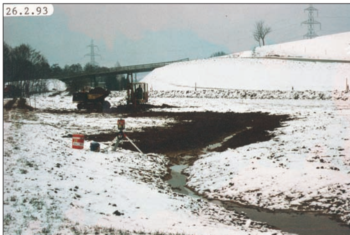
Fig. 3 : Travaux en cours. Terrassement et façonnage de nouveaux tracés pour l'eau en surface (photo Biotec, 26.02.1993).
