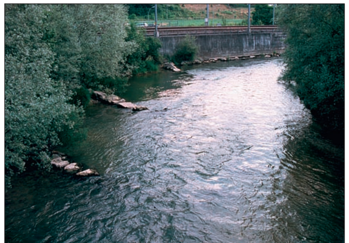
Fig. 4F : 2001. Vue d'ensemble montrant que les épis jouent également un rôle important dans la structure géomorphologique et les habitats avec des faciès d'écoulement et des profondeurs variés.
