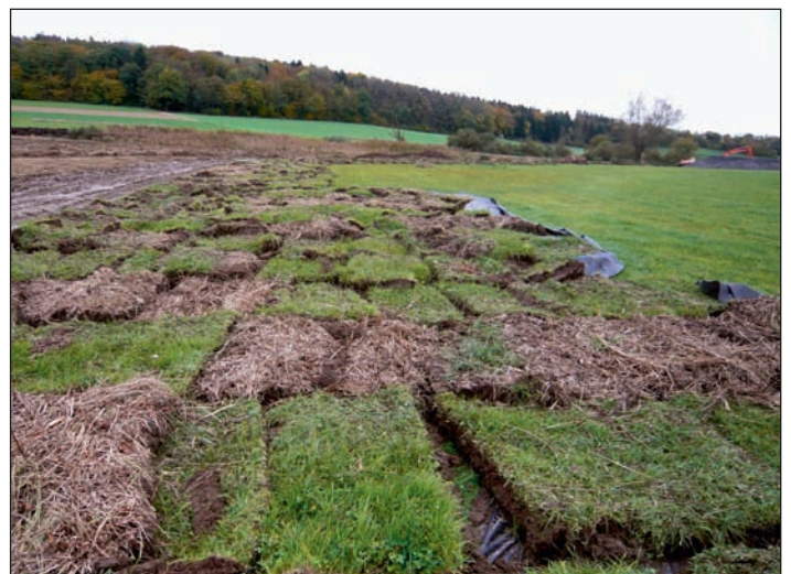
Fig. 10 : « Plaques » de végétation décapée et mise en dépôt provisoire (photo Biotec). Abb. 10: Abgetragene und zwischengelagerte, mit Vegetation bewachsene Erdschollen (Foto Biotec). Fig. 10: «Lastre» di vegetazione scarificata e messa in deposito provvisorio (foto Biotec).
