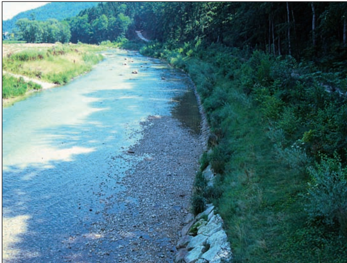
Fig. 2E : 1987. Evolution naturelle. De 1984 à 1987, sept crues (> 100m 3 /s) sont passées sur les berges, amenant au passage un fort potentiel de graines, de pousses de saules et d'autres arbustes, favorisant ainsi la recolonisation spontanée.
