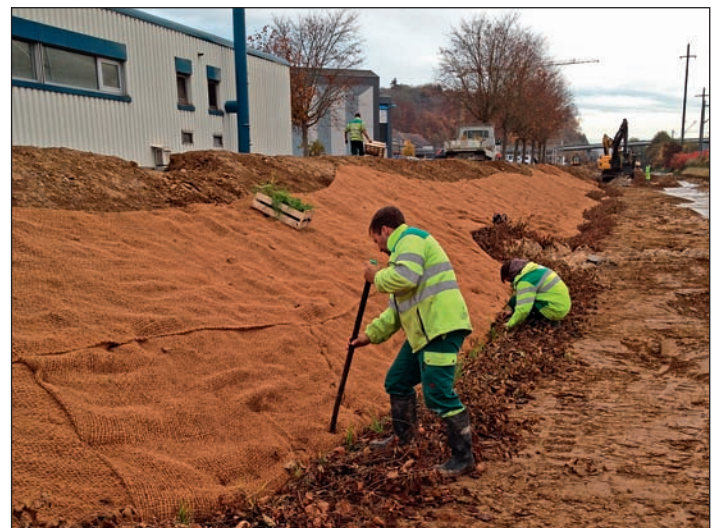
Fig. 11 : Détails du sac en coco avec l'effet des ramilles sur le piégeage des sédiments fins et plantation des hélophytes qui permettront la stabilisation du pied de berge à l'arrière des terrasses érodables (photos Biotec).
