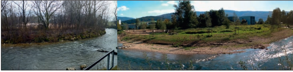
Fig. 4 : A gauche, l'ancienne berge entièrement enrochée a été démolie et couchée en pente douce ; à droite, le jeu de l'érosion et des dépôts consécutifs aux crues permettent une évolution naturelle de la morphologie et de la végétation de la berge. En arrière-plan, on voit l'espace « nature » en compensation du manque de place au centre-ville (photo Biotec, février 2010 et avril 2012).
