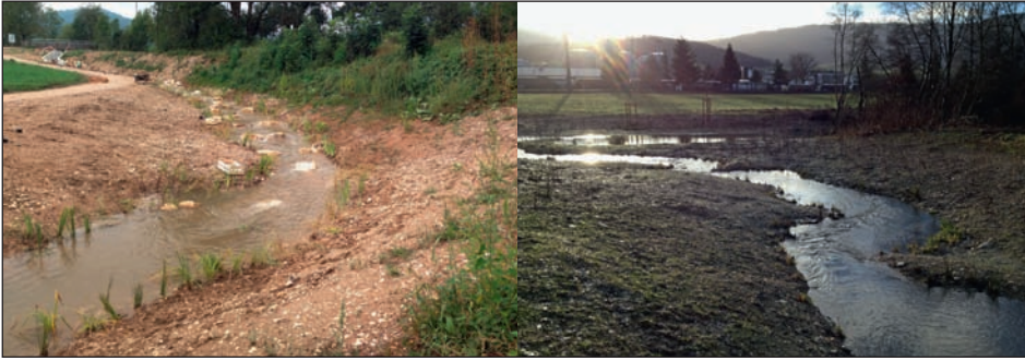
Fig. 10 : A gauche, création d'un lit restreint et mise en place d'obstacles pour ralentir les eaux et obtenir une profondeur suffisante pour le déplacement des poissons. A droite, variation du tracé et de la largeur (photo Biotec, sept. 2012).
