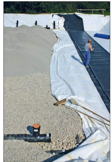
Fig. 2 : 1 er étage de traitement en construction où l'on distingue l'étanchéité (bâche noire), les différentes couches de graviers calibrés et le système de drainage/aération (juillet 2005).
