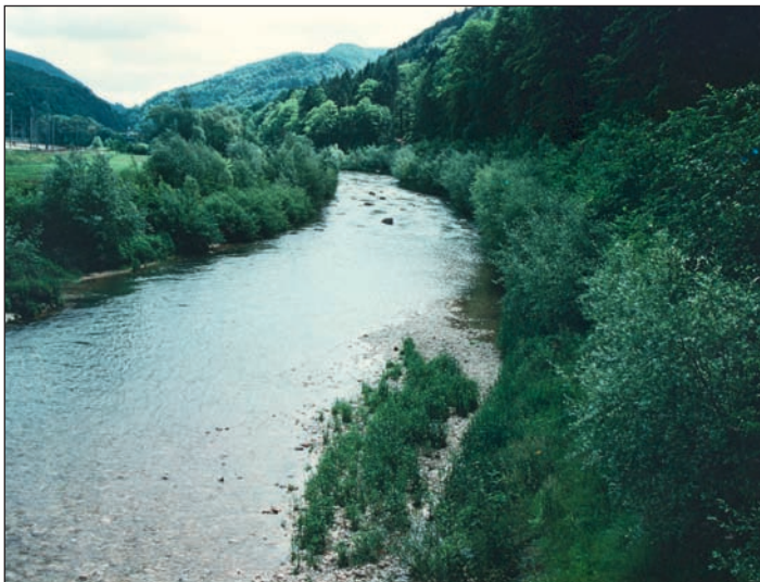
Fig. 2G : 1991. Quelques années après on ne voit plus vraiment qu'il s'agit d'un tronçon artificiellement aménagé. C'est « le » critère de réussite du génie biologique : ne plus voir qu'il y a eu une intervention !
