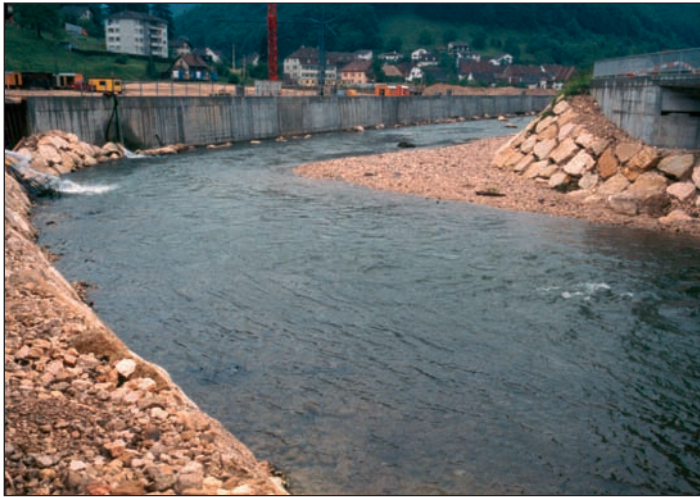
Fig. 4A : 1985. Après l'ouverture du verrou pour diriger la Birse dans son nouveau lit, les petites crues ont déposé un important banc de graviers en intrados.
