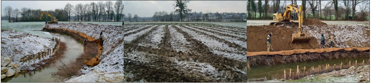
Fig. 9 : Plantations sur rives et génie végétal sur berges localisés dans des secteurs à enjeux (photos Biotec).
