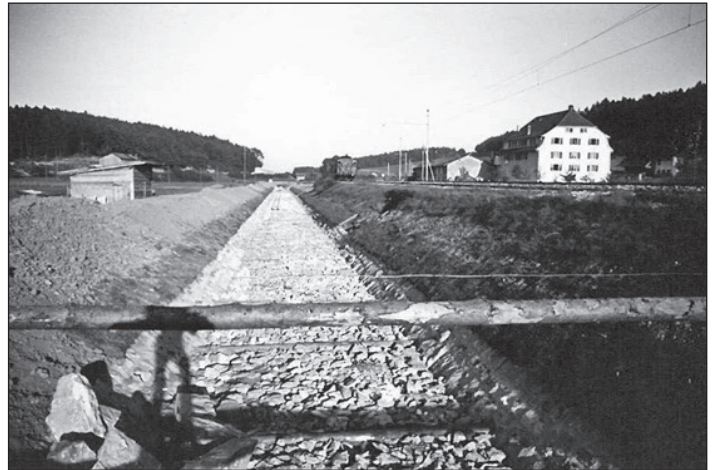
Fig. 3 : Travaux de corrections de l'Allaine dans les années 1940 avec la création d'un chenal totalement empierré et des pieds de berge réalisés en perré maçonné (photo Dr. A. Perrone, musée de l'Hôtel-Dieu, Porrentruy).
