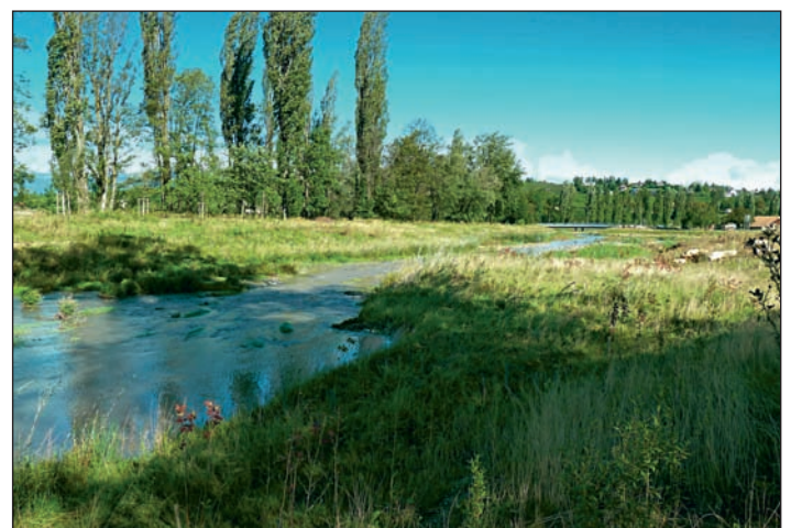
Fig. 5 : Nouveau lit de l'Aire, libre de s'écouler dans un important espace de liberté, végétalisé à l'aide des techniques du génie biologique ; une dizaine de mélanges grainiers particuliers pour les herbacées et 9 listes de plantes pour les ligneux ont été développées et utilisées pour la végétalisation de plus de 100 000 m 2 (photo Superpositions).
