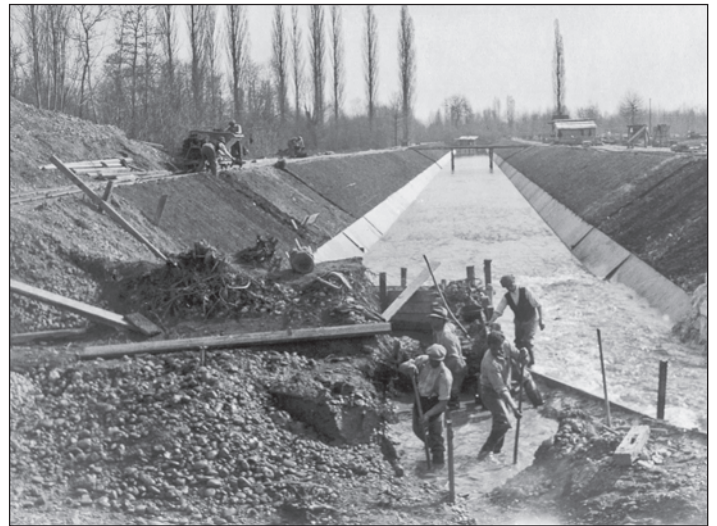
Fig. 12 : Travaux de correction de l'Aire dans les années 1930 sur le secteur de la 3 e étape de revitalisation ; les anciens méandres ont été supprimés au profit d'un canal en béton rectiligne qui sera, à son tour, abandonné de la rivière (source : archives du canton de Genève).
