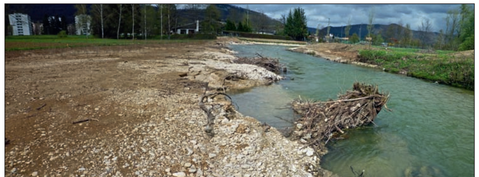
Fig. 3 : Lors de la création de la terrasse inondable, les enrochements ont été supprimés, mais pas les souches d'arbres qui avaient réussi à se développer en berge. L'aménagement favorise le développement d'une érosion naturelle et la création de conditions favorables pour la faune piscicole et terrestre (photo Biotec, avril 2012).
