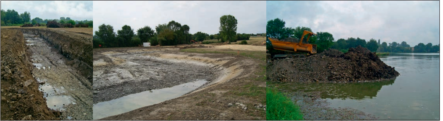
Fig. 6 : Poursuite des terrassements. Le fond du lit laisse apparaître l'eau de la nappe phréatique et une matrice graveleuse (photos Biotec).
