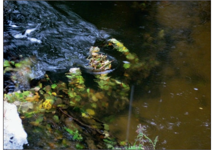
Abb. 5: Einfache «Stöckchenbühne» als Fängerstruktur für Geschwemmsel wie z.B. Laub (Fotos: Ludwig Tent).
