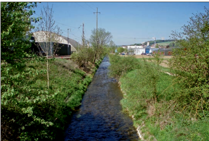
Fig. 6 : Etat du canal de l'Allaine, avant la revitalisation, avec un fond constitué de casiers remplis de blocs et des berges constituées par un perré maçonné en pied (voir fig. 3). Aucune variation de largeur ou de structure dans le lit n'est possible (photo Biotec).
