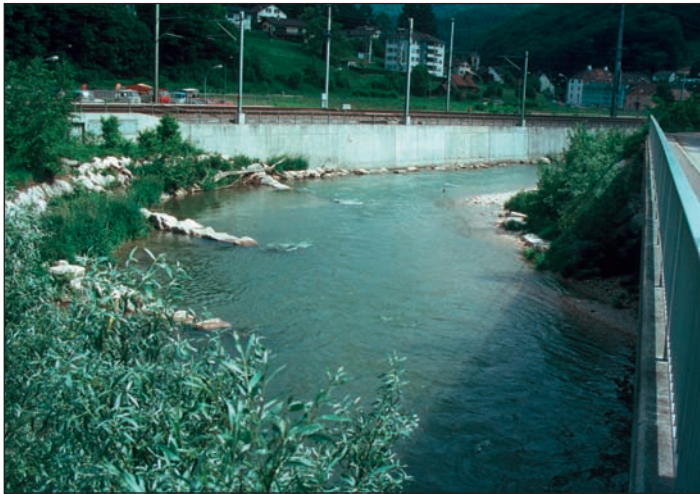
Fig. 4C : 1991. Après le passage de dix grosses crues, les épis simples résistent bien et le banc de graviers ne se reconstitue plus.
