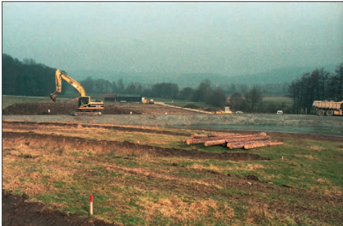
Fig. 6 : Terrassement des lits du ruisseau et des mares, création de seuils en bois pour relever le niveau piézométrique et démolition des drains au passage (photo Biotec, 1996).
