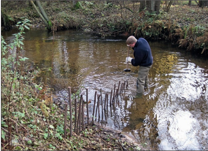
Abb. 5: Einfache «Stöckchenbühne» als Fängerstruktur für Geschwemmsel wie z.B. Laub (Fotos: Ludwig Tent).
