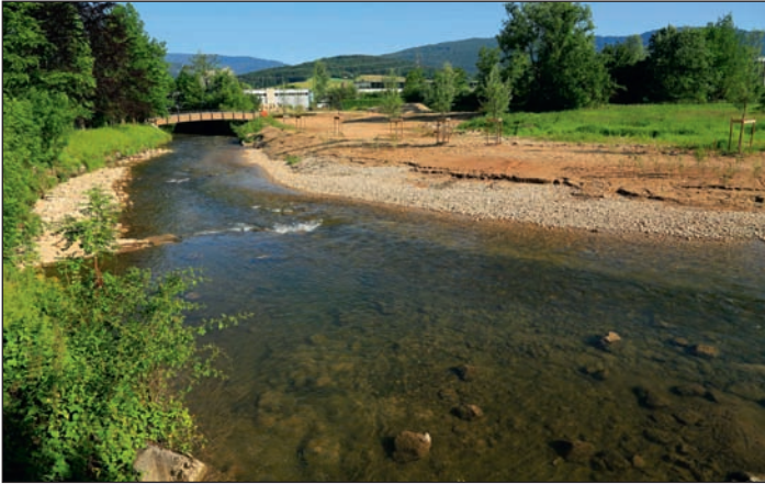
Photo 3 : Centre professionnel Delémont. La suppression de l'enrochement et du cordon rivulaire en rive droite.
