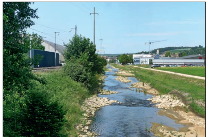
Fig. 7 : Nouvelle configuration de la rivière avec un fond du lit libéré de son corset et la création de terrasses inondables et érodables permettant à l'Allaine de créer elle-même une diversité de largeur, de vitesses d'écoulement et de qualité de substrats (photo Biotec).
