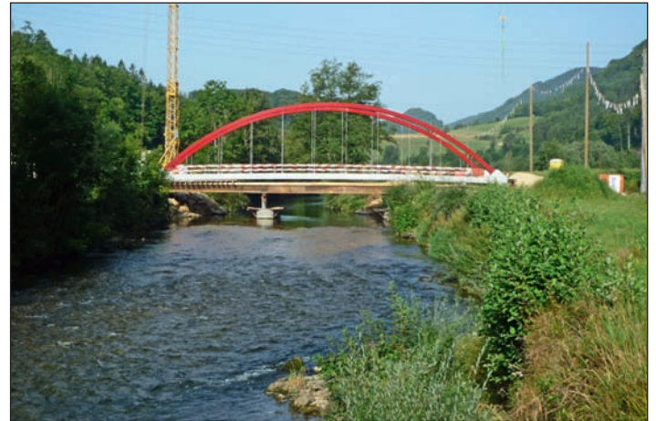
Fig. 7 : Construction du nouveau pont des Riedes-Dessus vu depuis l'aval (photo Biotec).
