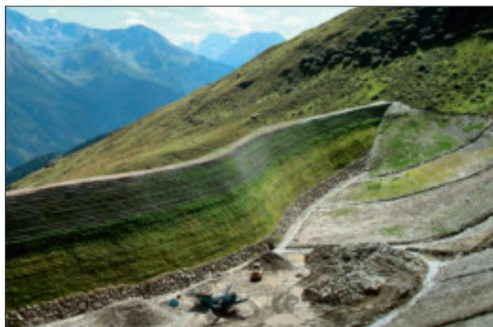
Abb. 4: Mischungsversuch und bergseitige Böschung aus bewehrter Erde, begrünt mit Spritzbegrünung
