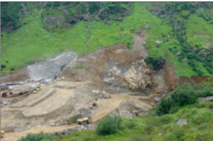
Foto 30: Der Aufbau des Damms 2004; Links im Hintergrund das Portal des Triebwasserstollens
