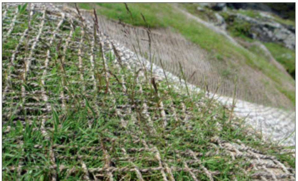
Bild 17: Projekt «Kitzsteinhorn 2015»: Spätestens im zweiten Jahr nach der Einsaat beginnt die sich etablierende Vegetation Samen zu produzieren, ein sicherer Indikator für den Erfolg der Begrünung
