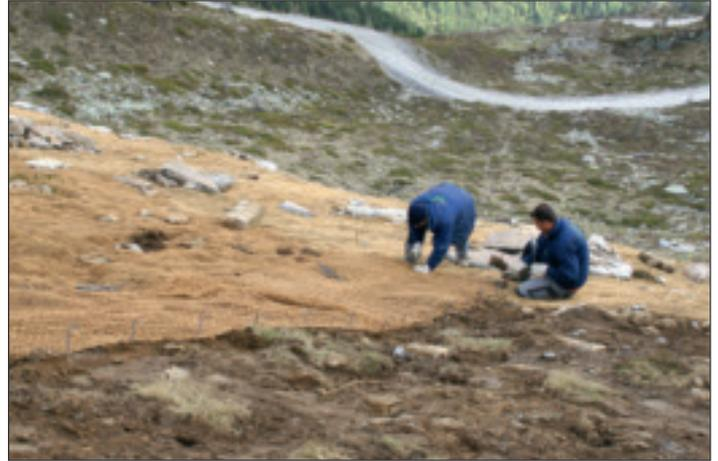
Bild 8: Pumpspeicherkraftwerk Reisseck II, Felslagerstätte Schoberboden: nach Aufbringen von Oberboden, Rasensoden, Einsaat und Düngung wird das Erosionsschutzgewebe aufgelegt und vernagelt
