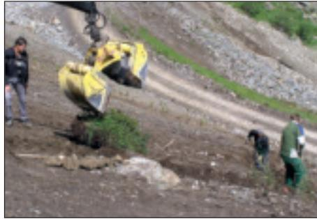
Foto 4: Der Schreitbagger ladet die Rasensoden mit den Zwergsträuchern ab, diese werden handisch eingebaut (August 2005).
