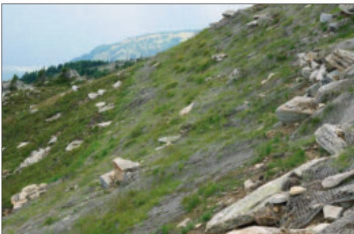
Bild 11: Pumpspeicherkraftwerk Reisseck II, Felslagerstätte Schoberboden: Das Kokosgewebe verrottet im Laufe der Jahre, gleichzeitig kann die erosionsichernde Wirkung durch die Pflanzendecke übernommen werden
