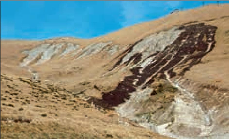
Abb. 11: Meran 2000, äusserer Kuhleitengraben, Begrünung durch Bitumen-Strohdecksaat
