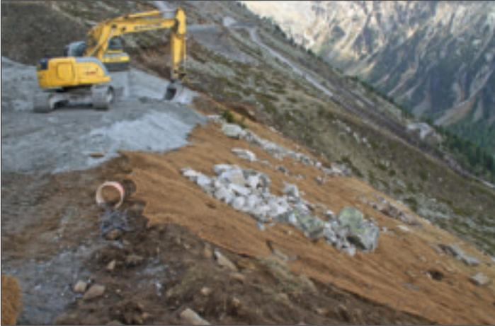
Bild 7: Pumpspeicherkraftwerk Reisseck II, Felslagerstätte Schoberboden: Die Begrünungen und Gestaltungen werden sukzessive mit der Deponie des Felsausbruchs höher gezogen
