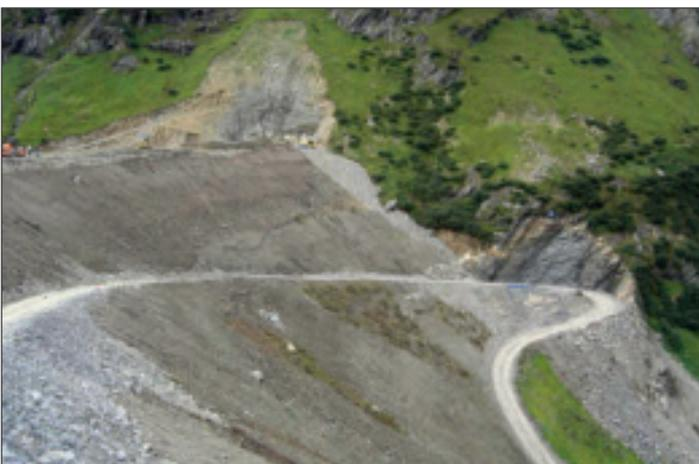
Foto 26: Der mittlere und oberste Dammschnitt kurz vor Fertigstellung, gut sichtbar die verpflanzten Rasensoden und Zwergstrauchgebüsche (Juni 2005)
