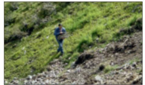
Foto 9: Die Weidensteckhölzer werden vom Vorarbeiter ausgelegt und unmittelbar darauf von den Pflanzarbeitern mittels Pflanzeisen gesetzt (August 2005).
