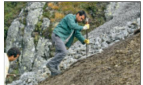
Foto 10: Mit dem Pflanzeisen werden die Pflanzlöcher für die Weidensteckhölzer vorgeschlagen (August 2005).
