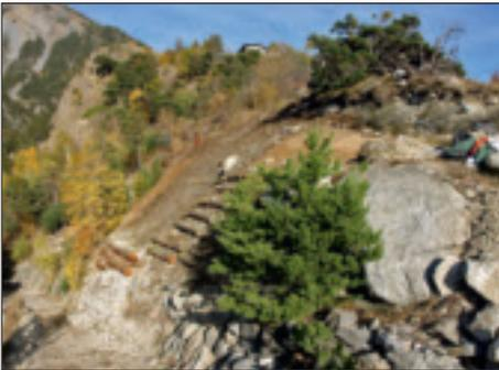
Abb. 9: Böschungsverbauung fertiggestellt; Ph. Müller
