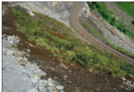
Foto 7: Die aufgebrauchten Rasensoden und Zwergsträucher im Mittelhang (August 2005)
