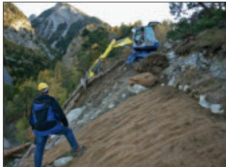
Abb. 6: Abflachung der Böschung und Hinterfüllung Holzroste; Ph. Müller
