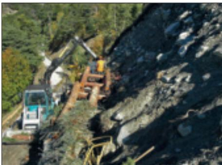
Abb. 4: Bau eines zweihäufigen Holzkastens durch Forstgruppe; Ph. Müller
