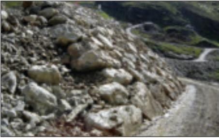
Foto 12: Steinschichtung auf der Wasserseite des Dammes (Foto Kurz, August 2005)
