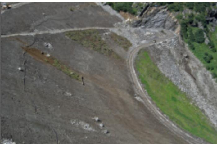
Foto 32: Der mittlere und oberste Dammschnitt kurz vor Fertigstellung, gut sichtbar die verpflanzten Rasensoden und Zwergstrauchgebüsche Juni 2005)
