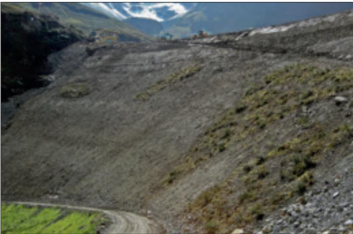
Foto 24: Der mittlere Dammschnitt kurz nach Fertigstellung, gut sichtbar die verpflanzten Rasensoden und Zwergstrauchgebüsche (8/2005)
