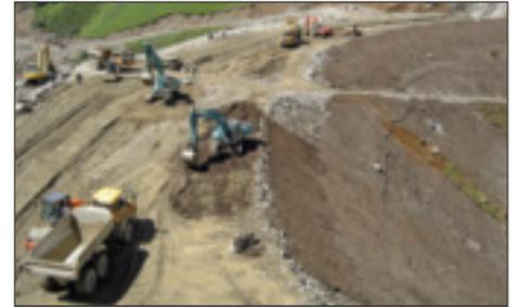
Foto 8: Der Staudamm vor Erreichen der vollen Höhe, die Andeckung der Luftseite mit rd. 10 cm Oberboden erfolgte sukzessive mit dem Hochziehen des Damms (August 2005).
