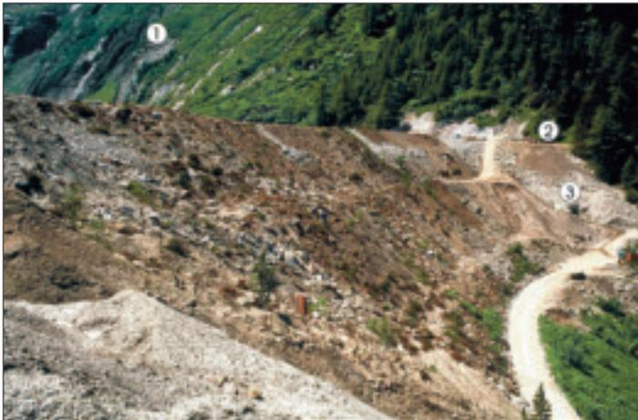
Bild 3: Der Damm des Rotgüldensees während der Begrünungsmassnahmen mittels Saat-Soden-Kombinationstechnik (die Punkte 1–3 markieren Details zum besseren Vergleich mit Bild 4)
