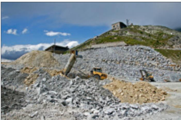
Bild 5: Pumpspeicherkraftwerk Reißbeck II, Felslagerstätte Schoberboden: In einer Seehöhe von 2200 und 2300 m werden ca. 260 000 m<sup>3</sup> Felsausbruch abgelagert
