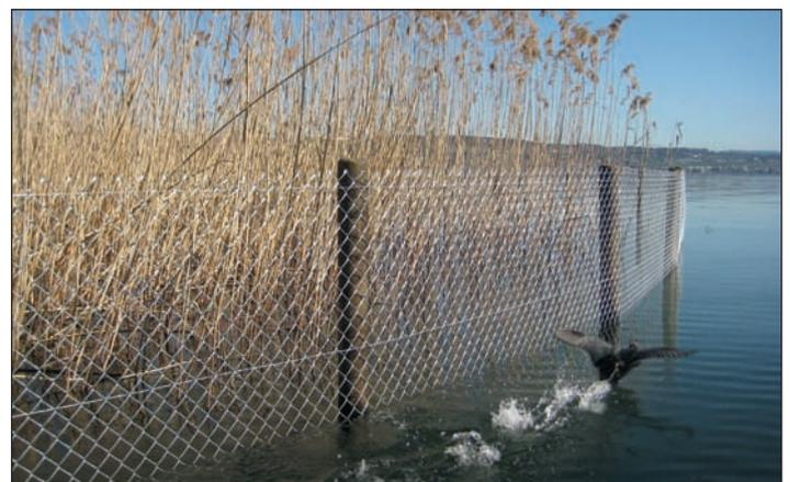
Abb. 11: Schutzzaun für die Ausbreitung von Schilf (Foto Fritz Studer, Betriebsleiter Wasserbau, AWEL).
