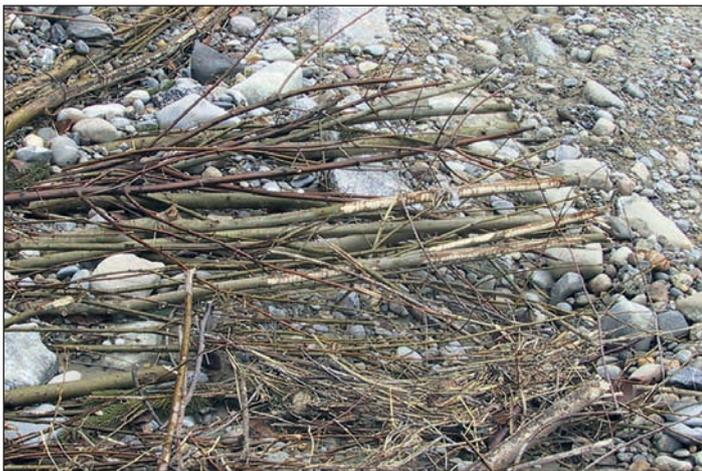
Abb. 2: Durch Biber angefressene Spreitlage (unten) und Faschine (oben) (Foto Urs Spychiger).
