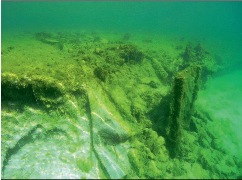
Abb. 2: Situation Buonas 2009. An der 1994 mit Geotextil und Holzverbauung (rechts im Bild) «geschützten» Kliffkante ist die fortschreitende Erosion gut zu erkennen. Die Kliffkante ist heute rund einen Meter zurückversetzt, Die Holzverbauung steht frei im Wasser.
