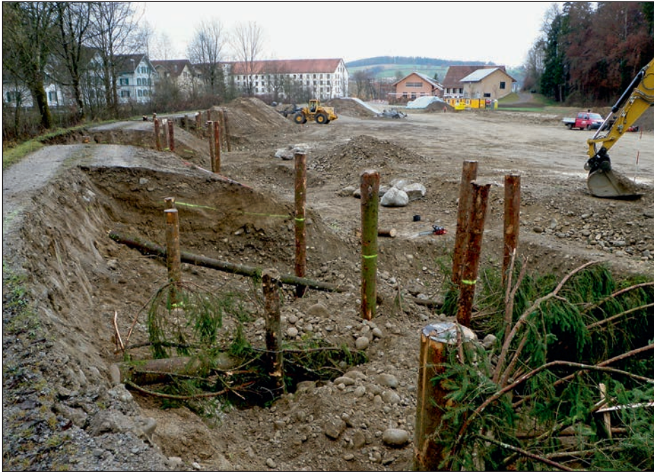
Abb. 4: Abfolge von Bambuhnen als Strömungsablenker in den Kurvenaussenseiten. Der neue Flusslauf folgt dem abhumusierten Bereich in Richtung der Baubaracken (Foto: Tiefbauamt Kanton Zug).
