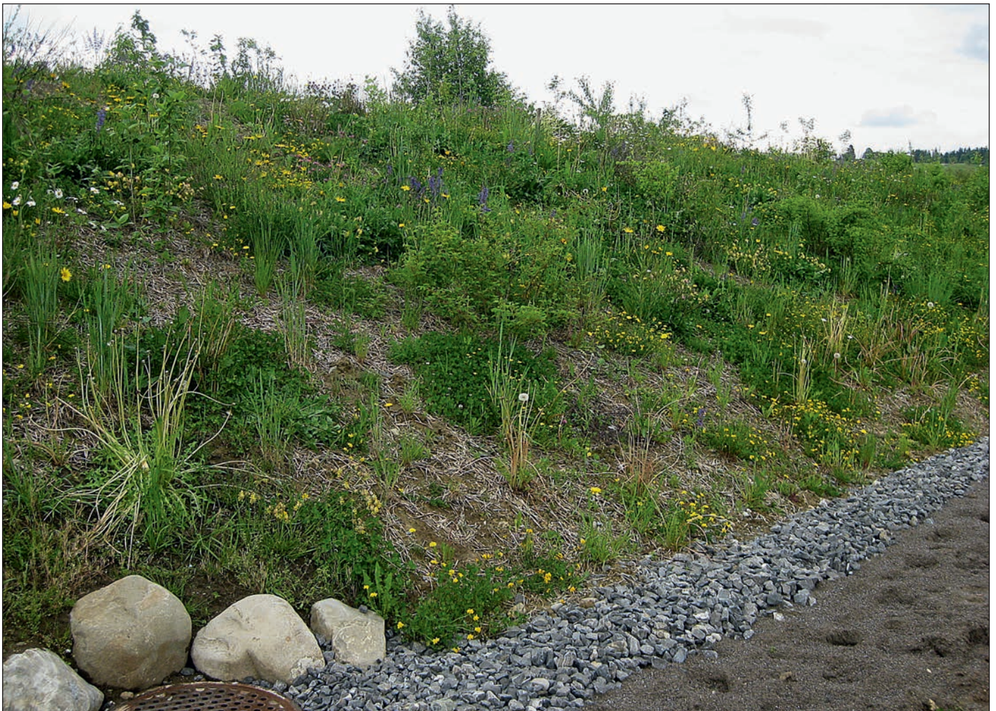
Abb. 5: Vegetationsstand des Lärmschutzdammes rund zwei Jahre nach Einbringen der Hydrosaat (Bild: Tiefbauamt des Kantons Zug).
