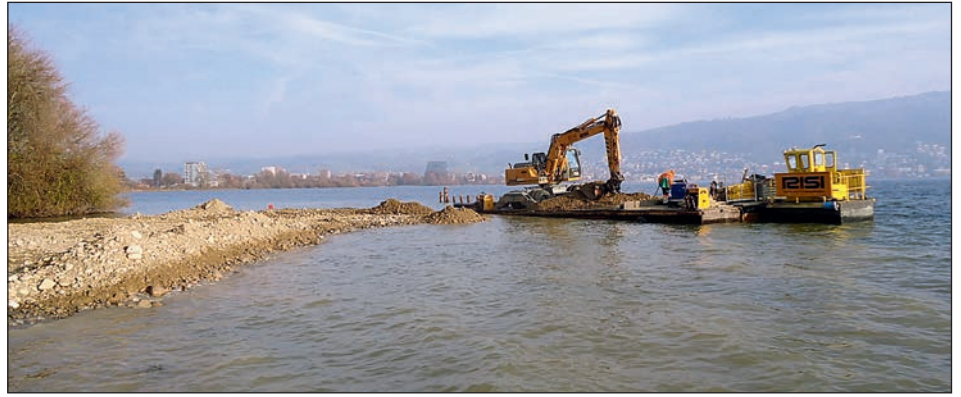
Abb. 3: Schüttung Kiesinsel mit Hilfe eines Pontons. Fig. 3: Remblayage de l'île de gravier au moyen d'un ponton.
