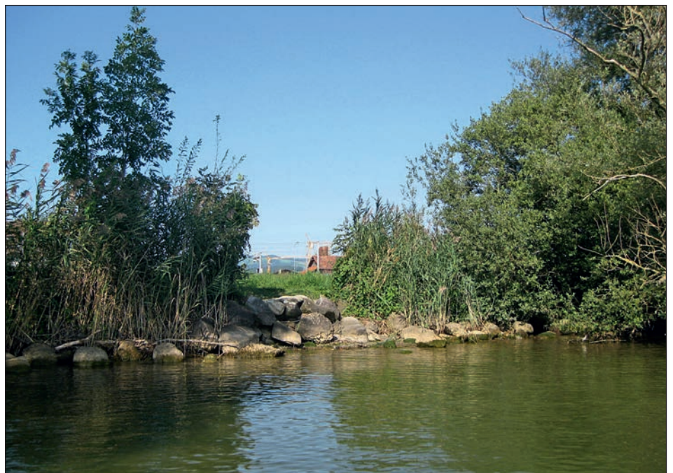
Abb. 1: Ausgangslage Flachwasserschüttung Choller (Blockwurf).
