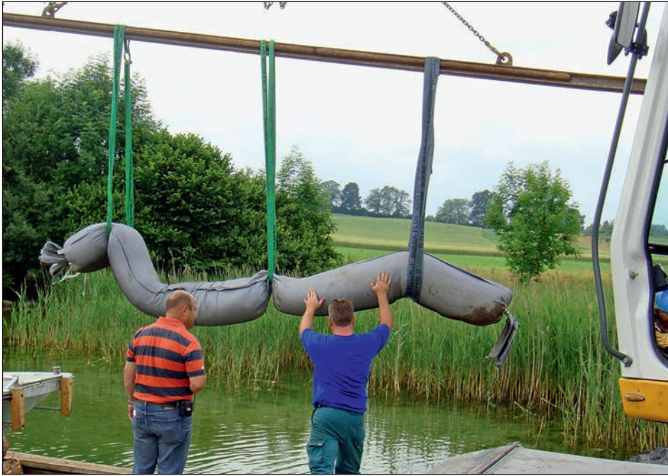
Abb. 4: Kliffkantenschutz Buonas mit Geotextilwalzen; 2009.
