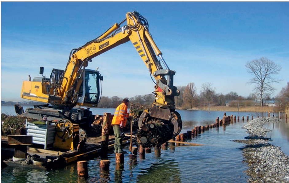
Abb. 3: Einbau Lahnung, Kiesschüttung bereits erfolgt.
