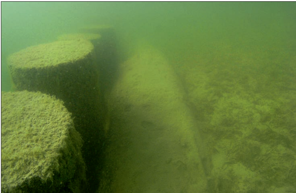
Abb. 7: Bündiger Abschluss der Geotextilwalze am oberen Ende der Abbruchkante.
