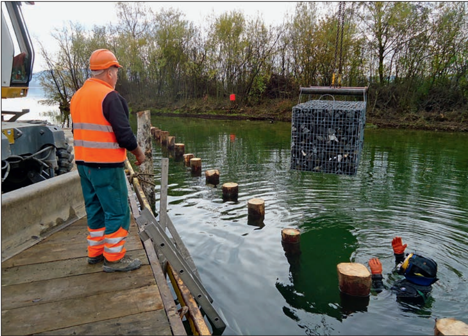
Abb. 7: Versetzen der Drahtschotterkörbe mit Bagger von Ponton aus mit Beihilfe eines Tauchers. Fig. 7: Mise en place des gabions avec des pelles mécaniques depuis le ponton avec l'aide d'un plongeur.
