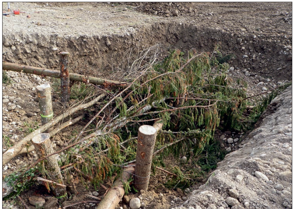
Abb. 3: Einbau einer Baumbuhne mit Nadel- und Laubbäumen (Foto: Tiefbauamt Kanton Zug).
