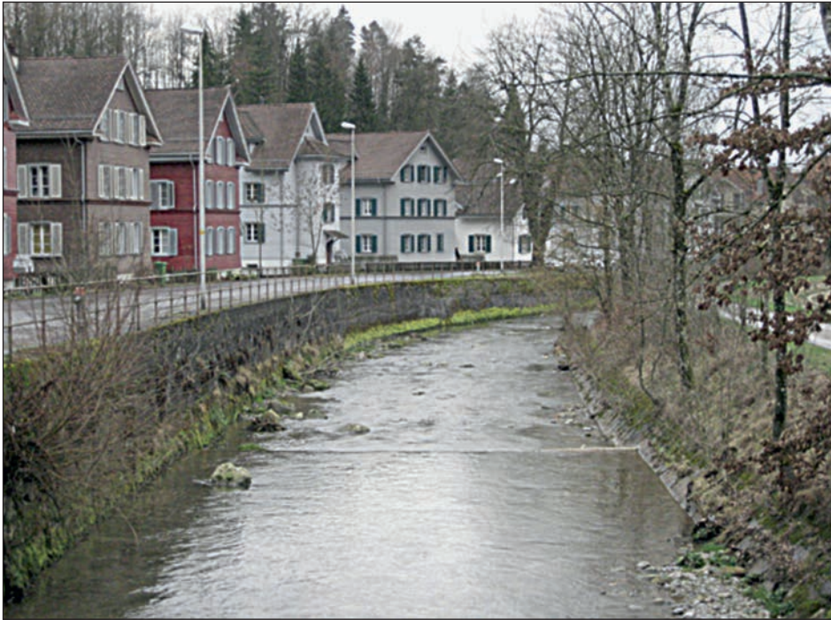
Abb. 2: Hart verbaute und kanalisierte Lorze im Bereich der Höllhäuser, Blick in Fließrichtung (Foto: Flussbau AG, Zürich).
