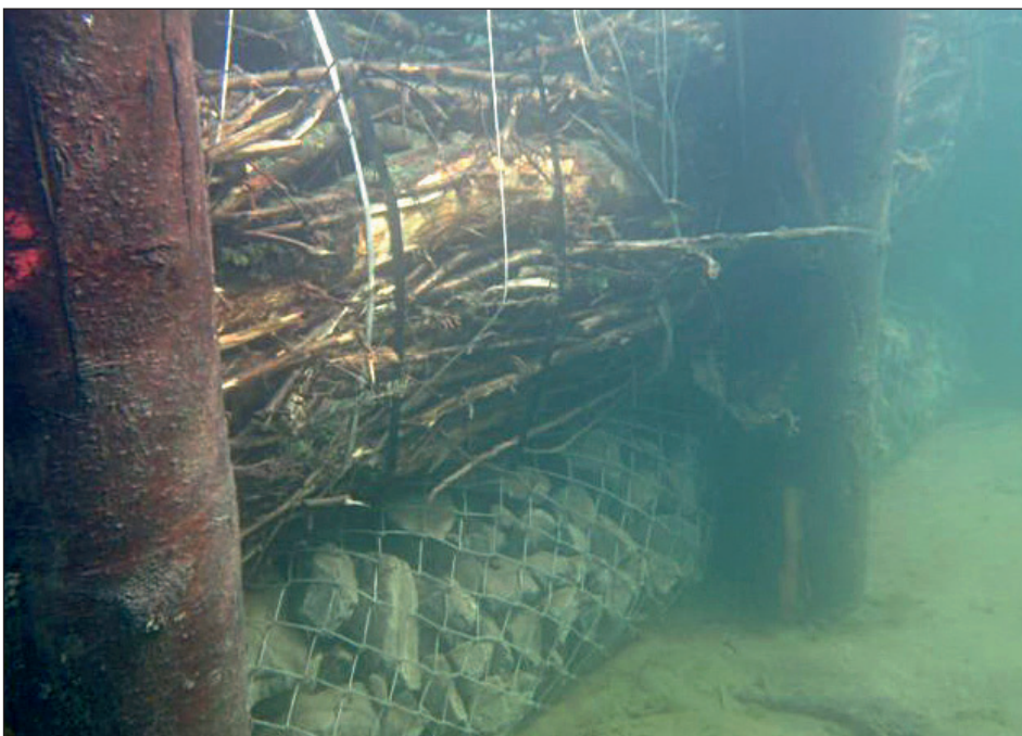
Abb. 4: Unterwasseraufnahme Fussicherung und Lahnung; Habitatstrukturen für Jungfische.
