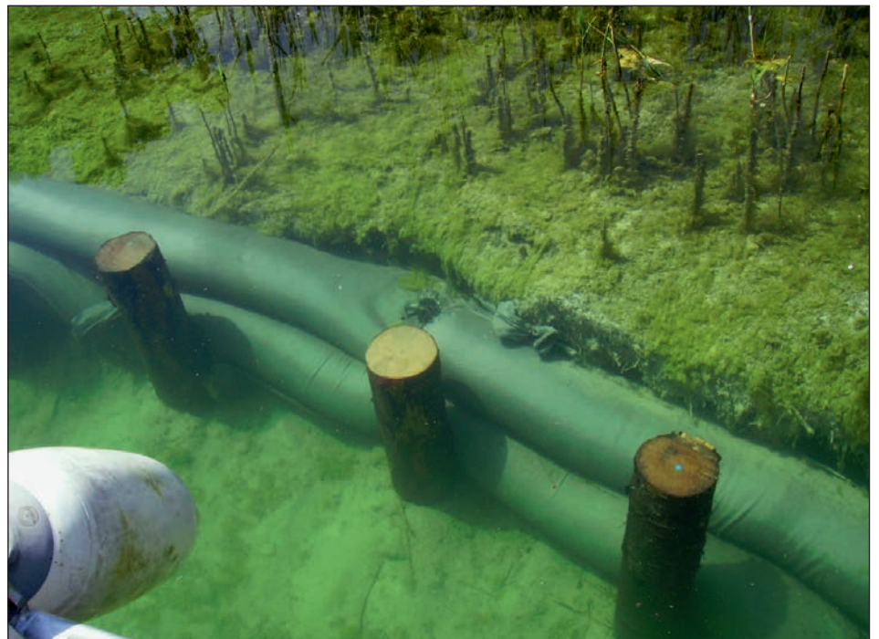
Abb. 5: Kliffkantenschutz Buonas mit Geotextilwalzen; 2009.
