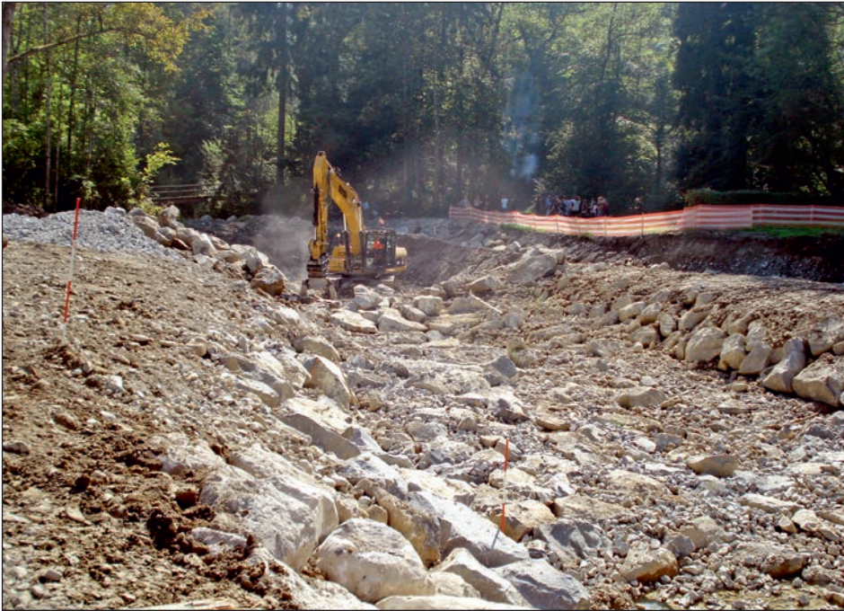
Abb. 5: Bau der Blockrampe im oberen Projektabschnitt. Abmessungen: L = 40 m, B = 10 m, J = 4%, Blockgewicht 1.5–2 to (Foto: Tiefbauamt Kanton Zug).
