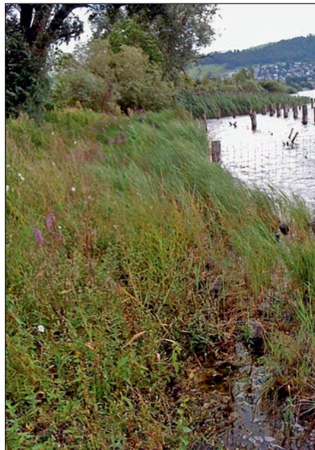
Abb. 6: Matten und Faschinen im Sommer (ca. 5 Monate nach Einbau). Fig. 6: Nattes et fascines en été (environ 5 mois après leur mise en place).
