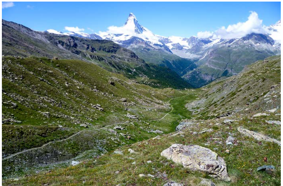
Landschaftsverträgliche Baumassnahmen in Wintersportgebieten sind nur mit umsichtiger Planung und enger Baubegleitung möglich. Bild: Bergbahnen Zermatt
