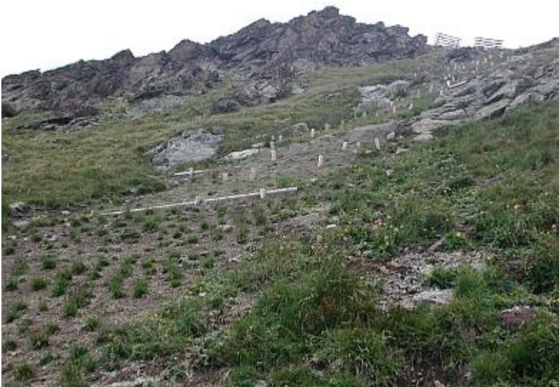
Foto: N. Locher Oberholzer, grupo de trabajo vegetalización de zona de alta cuota Planting of steep slope, ski world championship 2003, St. Moritz, 2800 m ü. M.
